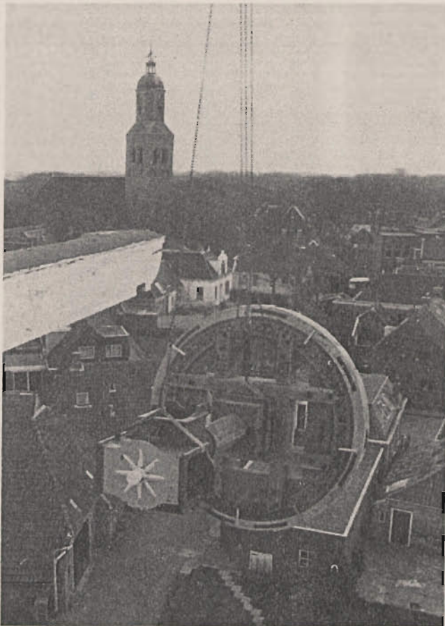
De zware bovenas (ijzergieterij L.I. Enthoven & Co. te s-Hage, nr. 657, anno 1879) begint, met bovenwiel en vang, in de takels van de kraan aan de duizelingswekkende afslaling tijdens de sloop van de oude kap op de molen van Eenrum. Deze foto is genomen door Martin van Doornik, zittend op de windpeluw, wat dit spectaculaire beeld heeft opgeleverd. Links een deel van de lange spruit. Opname 4 april 1995.
