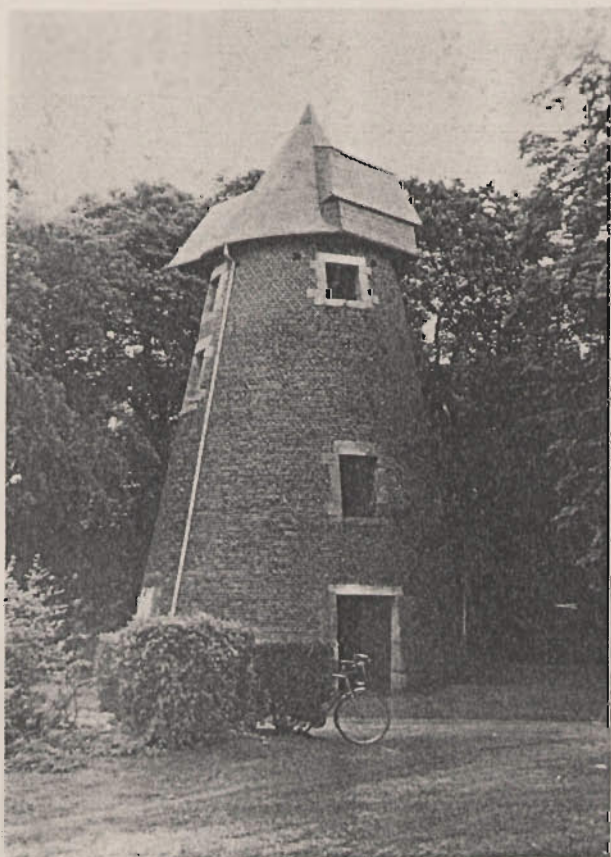
De vervallen ronde stenen grondzeiler-korenmolen te Givet in Frankrijk, genaamd «Moulin Vienot». Hij dateert uit 1844 en was een zogenaamde kettingkruier. Een zeer zwaar gebouwde molen, want de muren boven de grond zijn 1,17 meter dik! Martin van Doornik heeft deze molen in zijn geheel opgemeten en er zijn schetsen van gemaakt. Er konden daar sporen worden aangetroffen hoe de vroegere inrichting was. Reeds onttakeld na 1890. Foto: 18 juli 1995.
