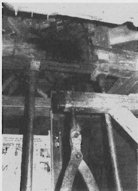
De oude dons balk is onmiddellijk na de ontdekking van zijn slechte staat voorzien van stalen stempels, zodat er verder gedraaid kon worden. De kruisarmen van het spoorwiel dateren uit 1610! Foto december 1997.
