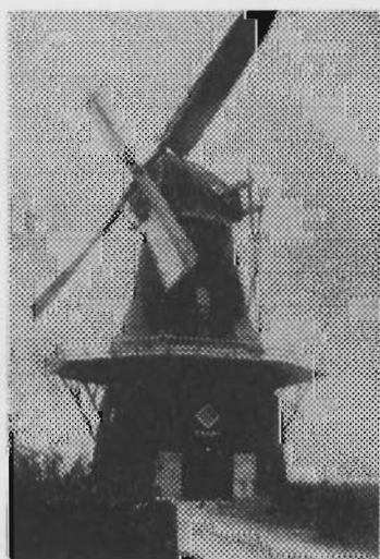
Koren- en pelmolen „ Windlust ” te Molenrij. Getailleerde achtkant op vierkante houten onderbouw. Gebouwd in 1889 en door blikseminslag afgebrand op 16 september 1955. Foto ± 1933 van W.O. Bakker te Harkstede.
