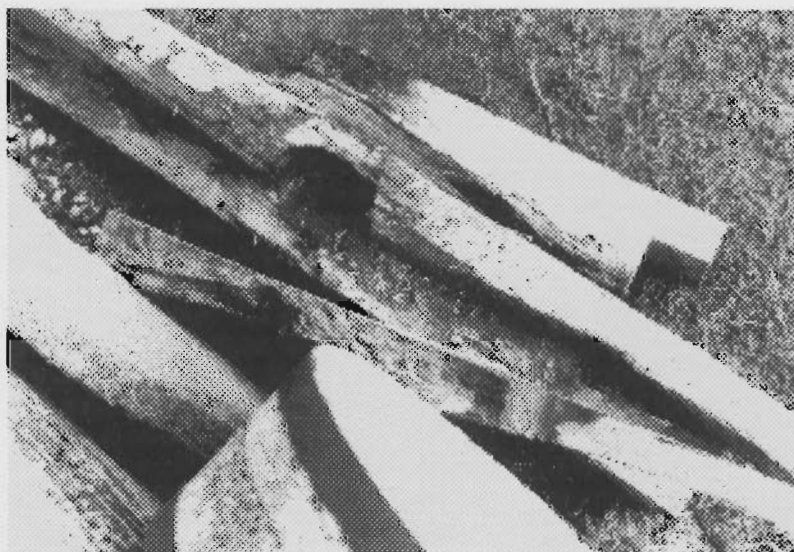
Zo lag de oude taatsbalk erbij in stukken, nadat hij vanaf de stelling naar beneden was gegooid. Om een goede foto van te maken, stond ik op een oude molensteen tegen de molenmuur met de camera naar beneden gericht.
