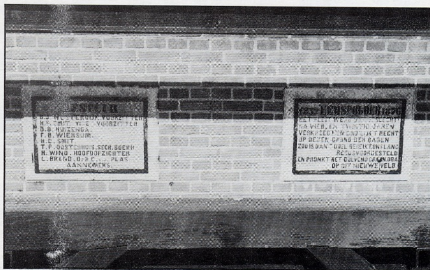
De beide gedenkstenen op de muur van de duikersluis bij de molen. De donkere streep boven is de schaduw van een balk.
