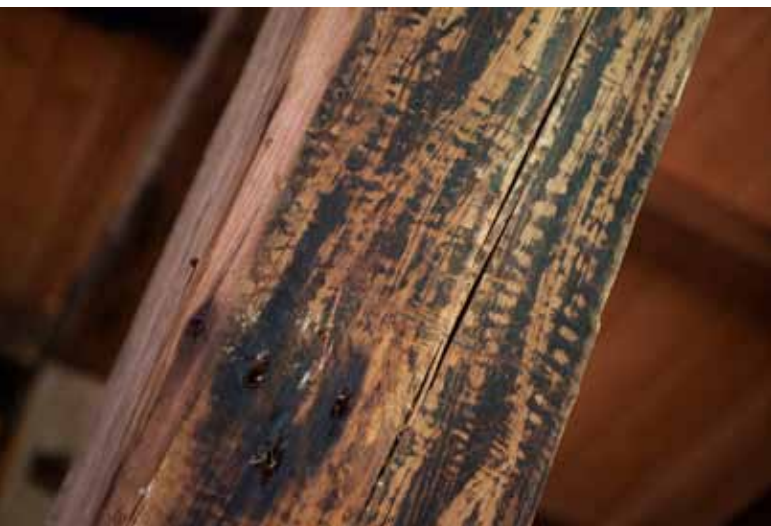
DE VELE ROETPLEKKEN OP DE BALKEN LATEN HET MEEST VAN DE OUDE OLIEMOLEN ZIEN
