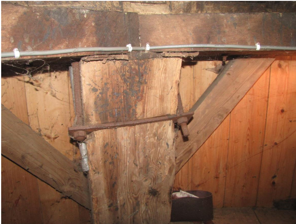
Figuur 28 Aan de sporen van de cirkelzaag valt te zien dat dit nieuwe tafelementstukken zijn. Ook de vulhoutjes en de draadeinden wijzen hierop.
