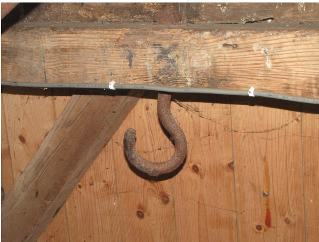
Figuur 29 Oorspronkelijk grenen tafelementstuk met een haak voor het ophijsen van een maalspil.
