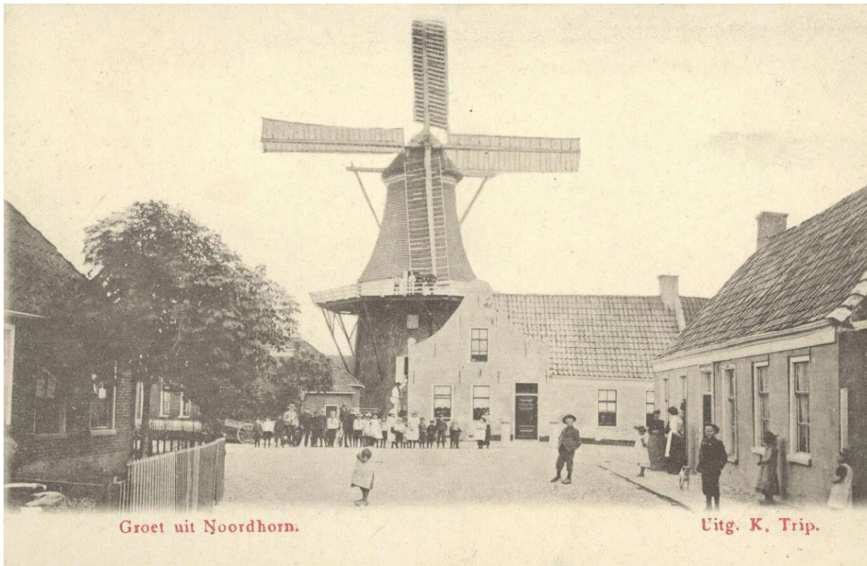
Figuur 11 De molen in 1903, met op de voorgrond het molenaarshuis. De molen heeft al zelfzwichting, met aan weerszijden van de roeden kleppen. (foto Groninger archief).
