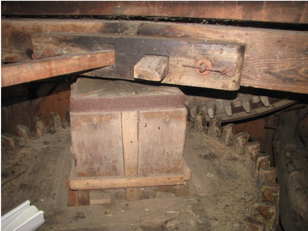
Figuur 42 Bonkelaar, bestaande uit twee platen.
