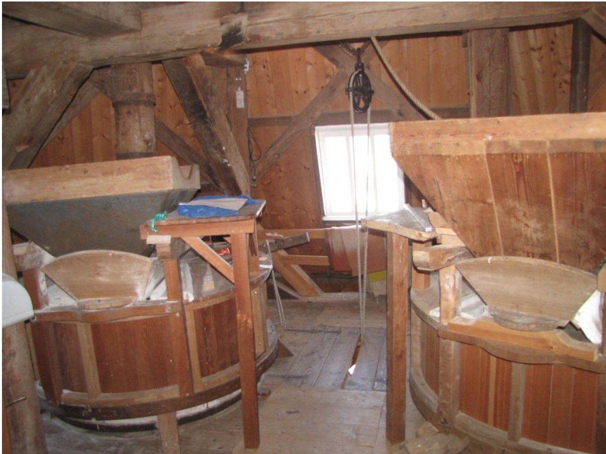
Figuur 51 Opstelling maalstenen met daartussen het lulijk. De houten spil loopt hier nog vrij van de kruisbalken.
