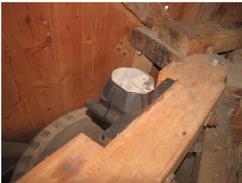
Figuur 50 Lagering ijzeren maalspil.
