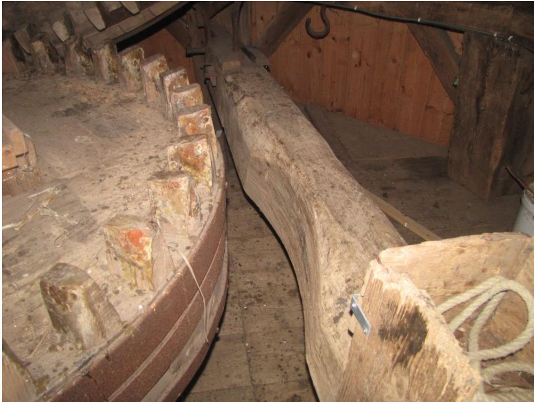
Figuur 34 Vangbalk met uitholling voor de bonkelaar.
