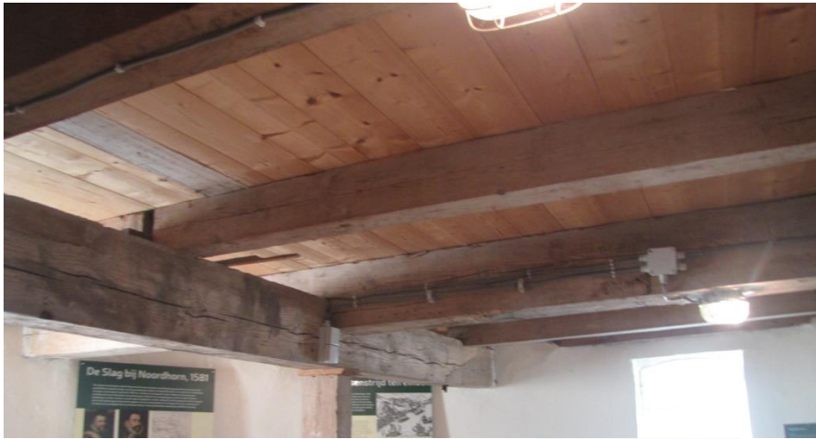
Figuur 23 De balklagen in de onderbouw bestaan uit vier in elkaar gekepte balken, met op de onderste binten losse tussenbalken.
