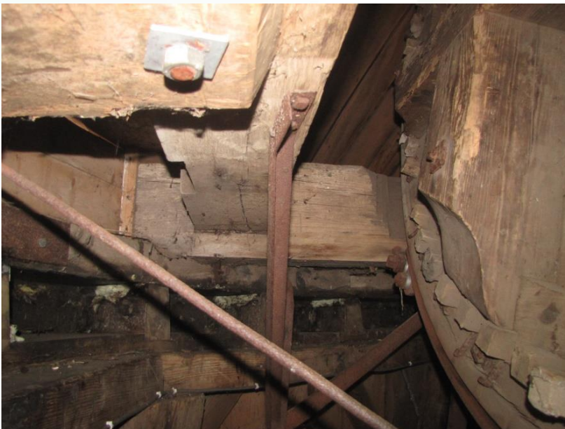
Figuur 31 Stormbalk met keep voor een kalf. Boven het huidige kalf.
