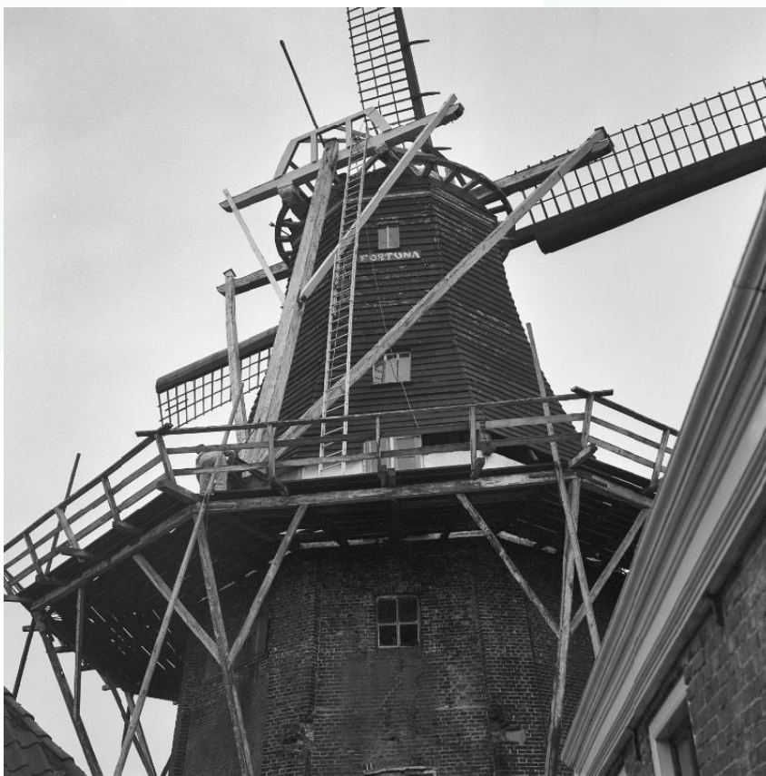
Figuur 17 Restauratie 1982. Te zien valt dat vooral de kap flink onder handen wordt genomen (foto RCE).
