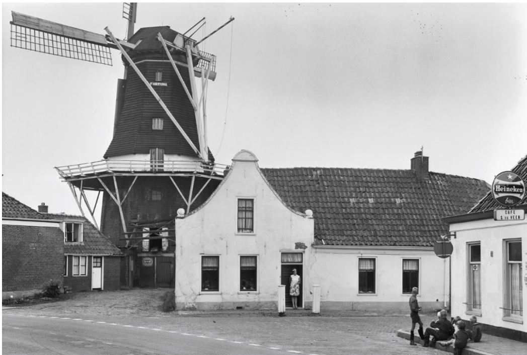
Figuur 16 De molen in 1968, voorzien van fokken op de nieuwe roede (foto RCE).
