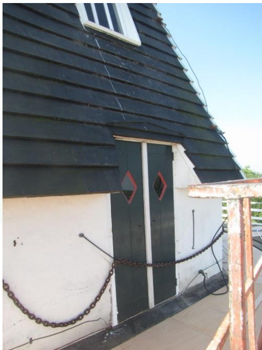
Figuur 22 Muurwerk tussen de stelling en de uittimmering. De stellingdeuren hebben ook een tijd grote ramen gehad.
