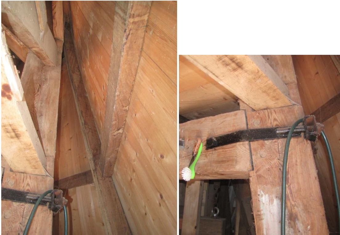
Figuur 27 Links een zeer lange aanloper (uitbreker) en rechts een detail van de verankering.
