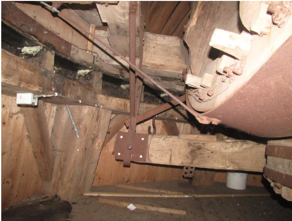
Figuur 35 Voorste hanger en vang van constructiestaal.
