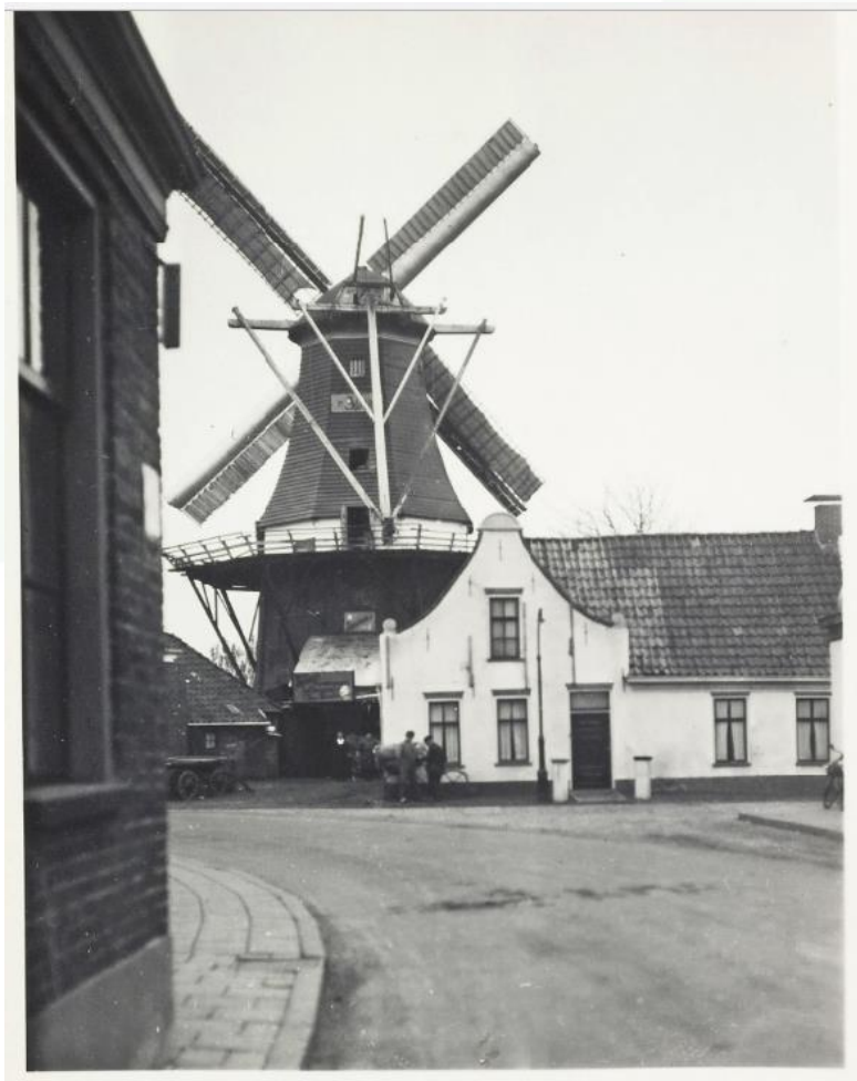
Figuur 13 De molen in 1934, nu voorzien van op één roede dekkerwieken met zelfzwichting en op de andere roede zeilen. (foto collectie De Hollandsche Molen).
