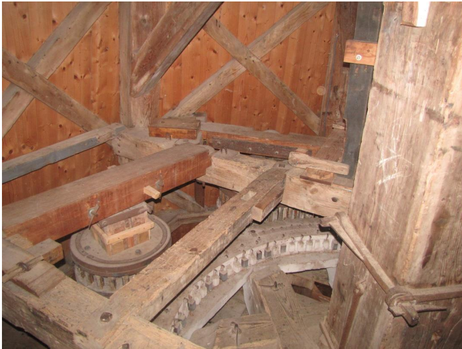
Figuur 47 In het valse veld een maalschijf en in het ware veld een pelschijf.
