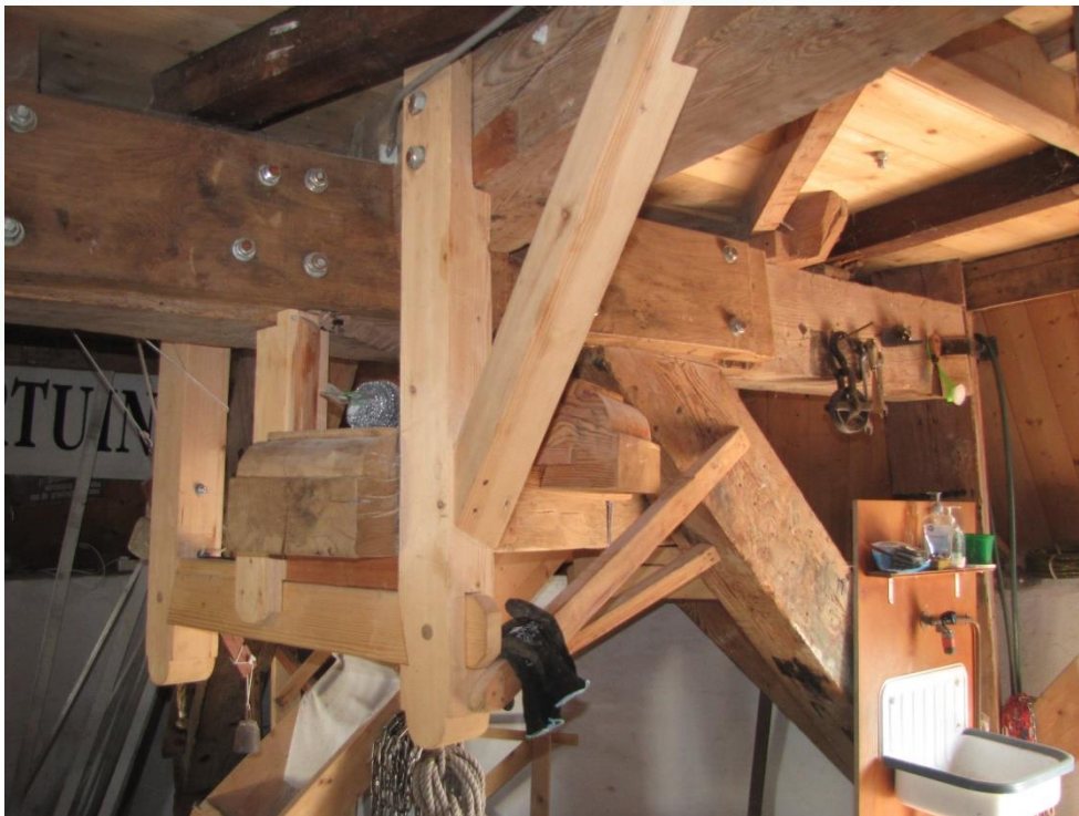
Figuur 54 Brugbalk met kussen met oplegging tegen korbeel
