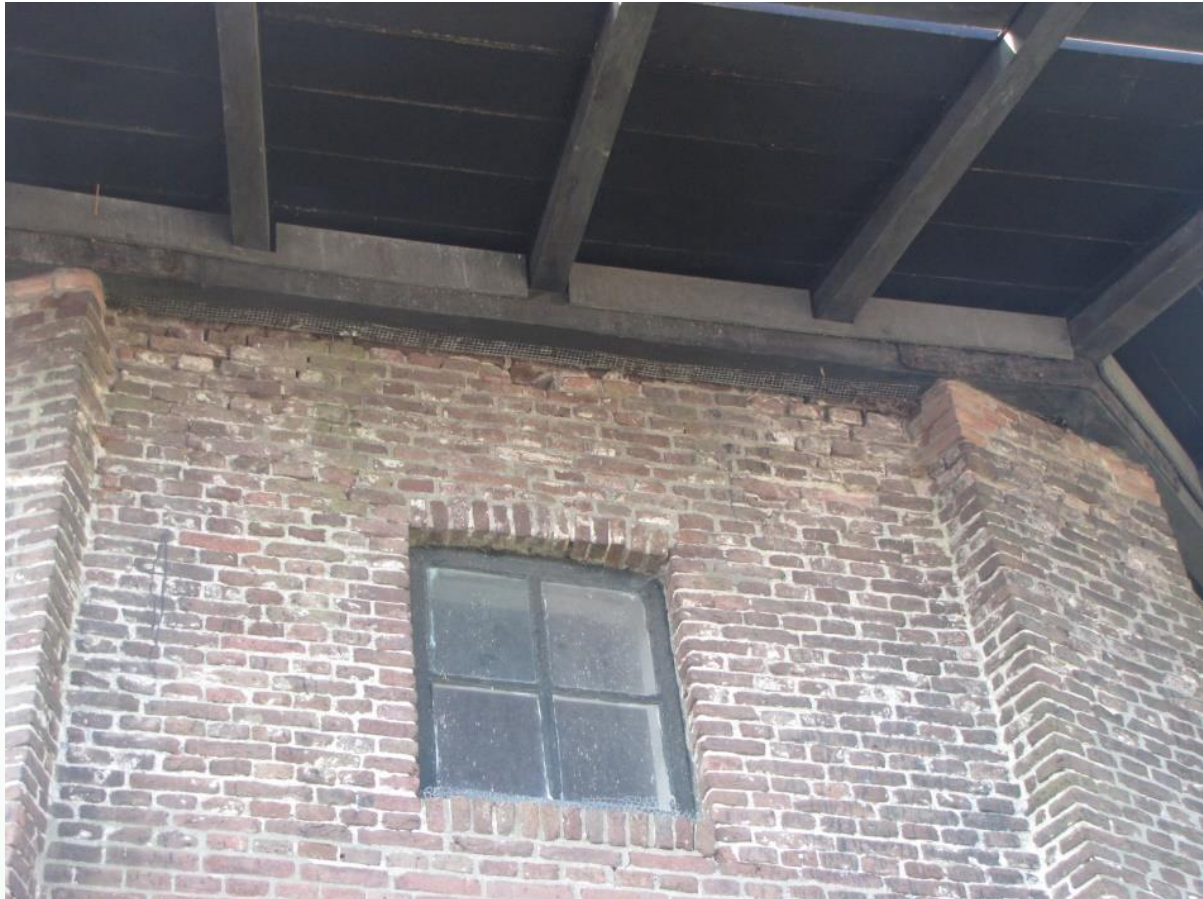
Figuur 20 De pilasters eindigen tegen de binnensluiting van de stelling.
