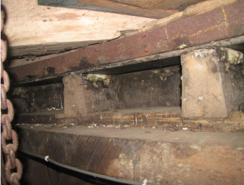
Figuur 30 Boventafelement met vrij dunne neutring, hoge neuten met daarop een vrij dunne kruiring met daarop een voeghout.
