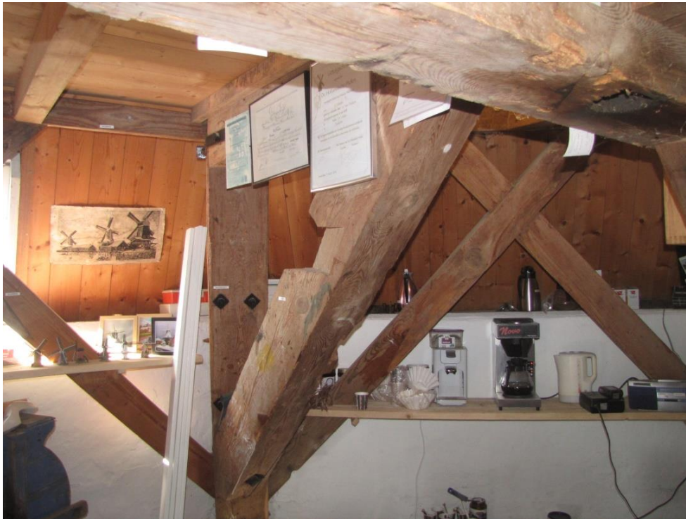
Figuur 53 De keep in het korbeel en het gat in de kruisbalk wijzen op de plaatsing van nog een koppel stenen.
