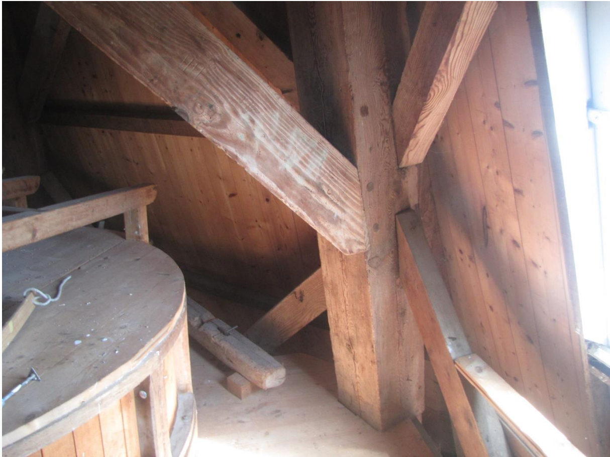
Figuur 25 Samenkomst van de onderste met de middelste veldkruisen.
