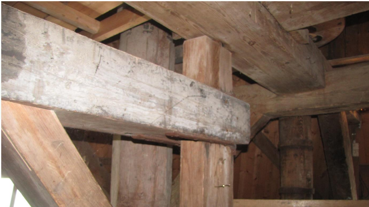
Figuur 24 Op de voorgrond de steenkraan die boven in de losse bintbalk steekt, met daarboven de dons balk.
