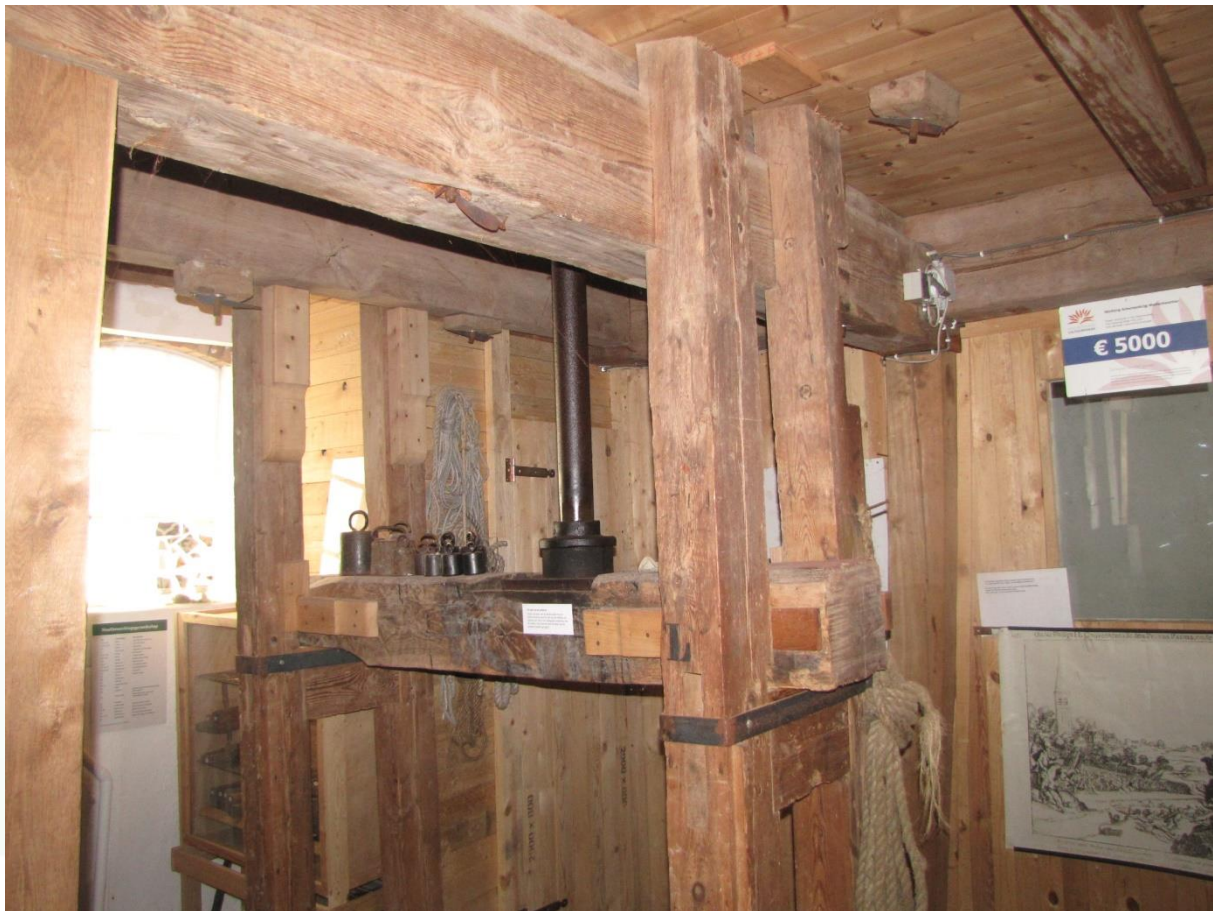
Figuur 63 De hangerij met brugbalk van de naloper op de tweede verdieping van de molen.
