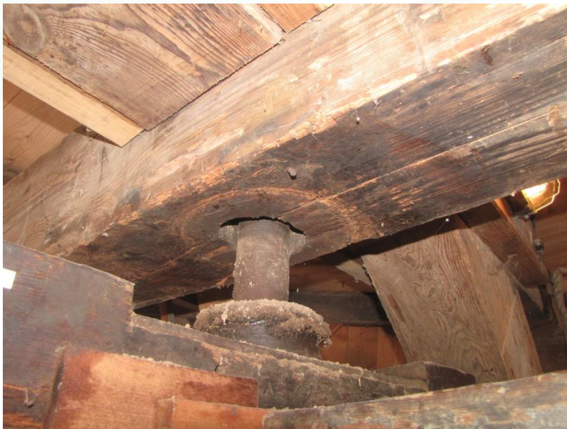
Figuur 52 De steenspillen gaan dwars door de onderste kruisbalken.
