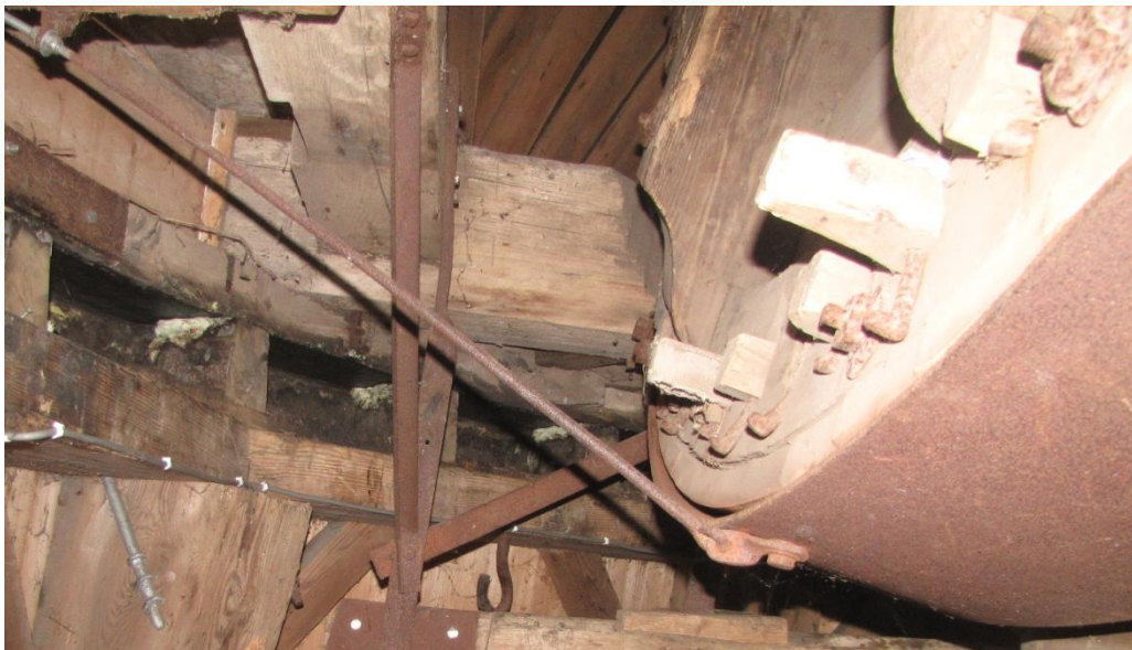
Figuur 41 De achterarmen zijn op de gebruikelijke wijze over het beleg gekeept.
