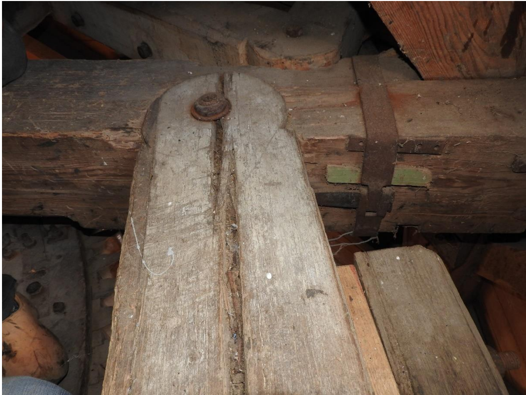
Afbeelding 4.90: De wervelbalk, die in het verleden aan één zijde geschilderd is, wat er mogelijk op duidt dat dit een vloerbalk of iets dergelijks is geweest.
