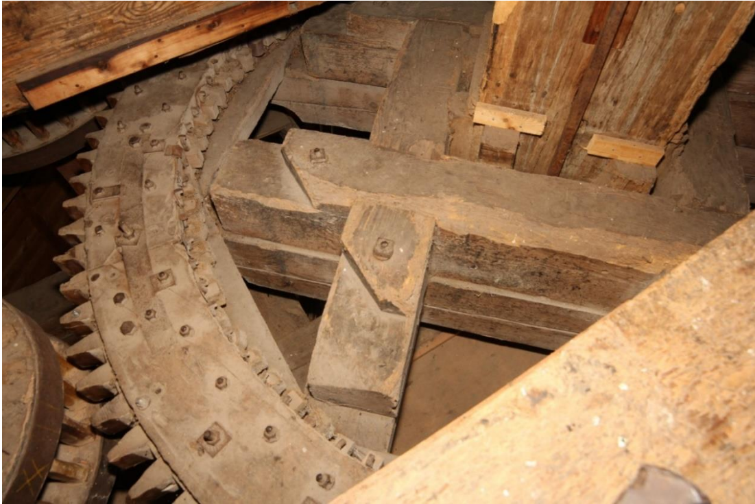
Afbeelding 4.91: Het spoorwiel met uiterst links één van de spillen. Het spoorwiel is vermoedelijk het omgebouwde bovenwiel uit de standermolen van Niekerk en heeft een hoge ouderdom. De inkepingen voor de plooiestukken in de kruisarmen zijn nog zichtbaar.
