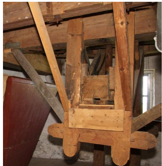
Afbeelding 4.36: Het paard van de voorloper, met de lagering, de pasbalk en het (niet zichtbare kussenblok).
