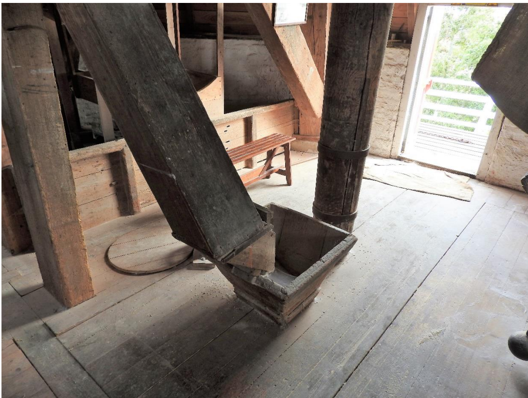
Afbeelding 4.58: De stellingzolder met links het deksel voor de toegang tot de dustvloer, waar de schootemmer stond die de gort van de naloper opvangt voor in de zeverij. De schootemmers worden niet meer gebruikt omdat hun functie is overgenomen door de jakobsladders.
