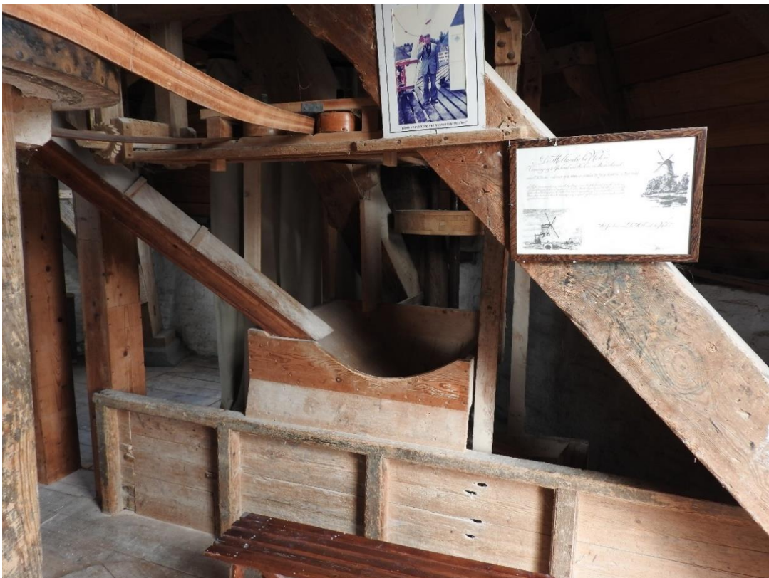
Afbeelding 4.53: Links de stortkoker van de naloper (vanaf de jakobsladder) die de gort naar de zeefkaar voert. Linksboven de aandrijving van de zeverij via een riem vanaf de naloper (uiterst links).
