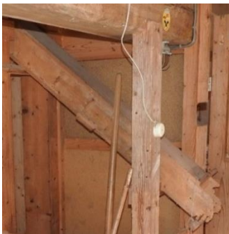
Afbeeldingen 4.18, 4.19 en 4.20: Stortkoker voor de gort vanaf de eerste zolder, jakobsladder met aandrijving voor transport van gort vanaf de begane grond naar de halfschilhokken.
