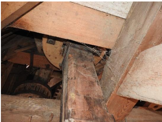
Afbeeldingen 4.66, 4.67, 4.68, 4.69 en 4.70 (van links naar rechts, van boven naar beneden): De vierkante spil van de aandrijving van de pletter. De spil was oorspronkelijk een roede, zichtbaar door oude hekstokgaten (links boven). Aan de bovenzijde draait het spoorwiel de spil aan (rechts onder).
