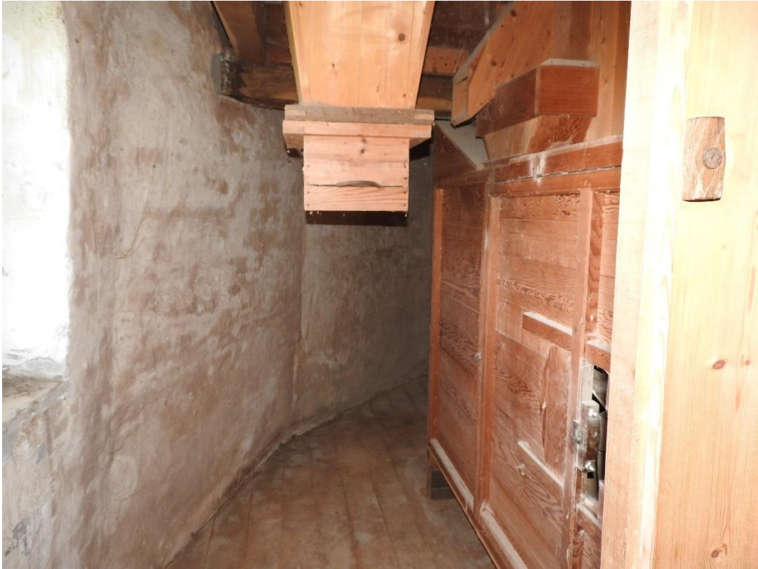
Afbeelding 4.45: De opvangbak voor het stof van de stofafzuiging van de pelstenen op de dustvloer, achter de wanmolen.
