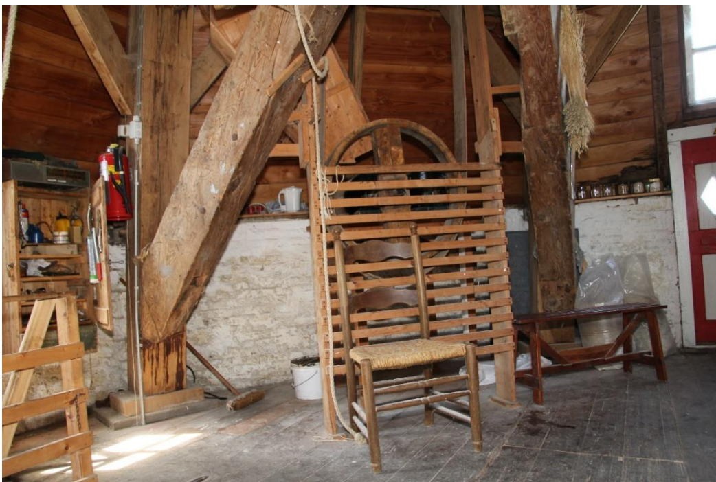
Afbeelding 4.47: De stellingzolder met (achter de lattenconstructie) de aandrijving voor de pletter, waarmee haver geplet werd. Oorspronkelijk zat de pletter lager zichtbaar bij de vloer (onder de huidige aandrijving), maar deze is omhoog geplaatst, waardoor een deel van houten stortkoker er links boven (achter de korbeel) schuin afgezaagd is.
