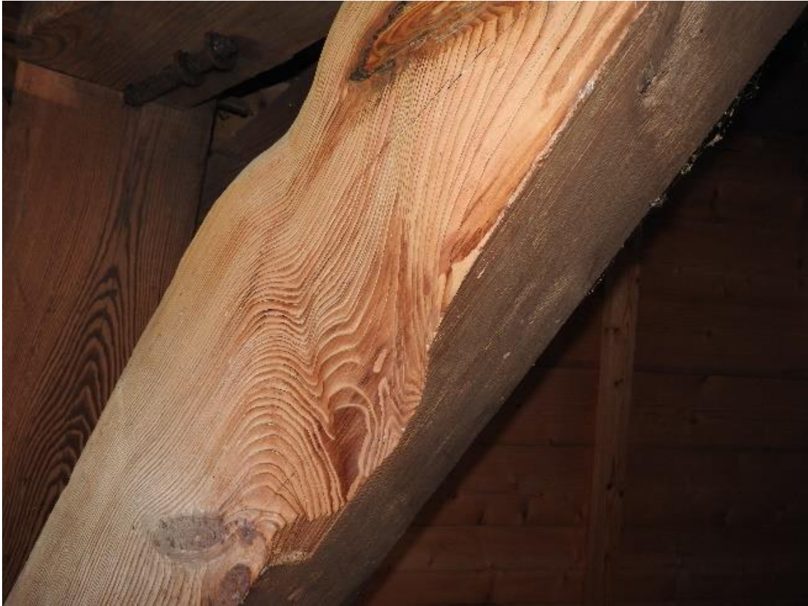
Afbeelding 4.74: Het korbeel van het rechter halfschilhok, dat door de scherpe randen van de gerst is uitgesleten.
