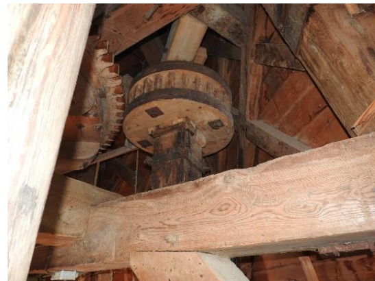
Afbeeldingen 4.66, 4.67, 4.68, 4.69 en 4.70 (van links naar rechts, van boven naar beneden): De vierkante spil van de aandrijving van de pletter. De spil was oorspronkelijk een roede, zichtbaar door oude hekstokgaten (links boven). Aan de bovenzijde draait het spoorwiel de spil aan (rechts onder).
