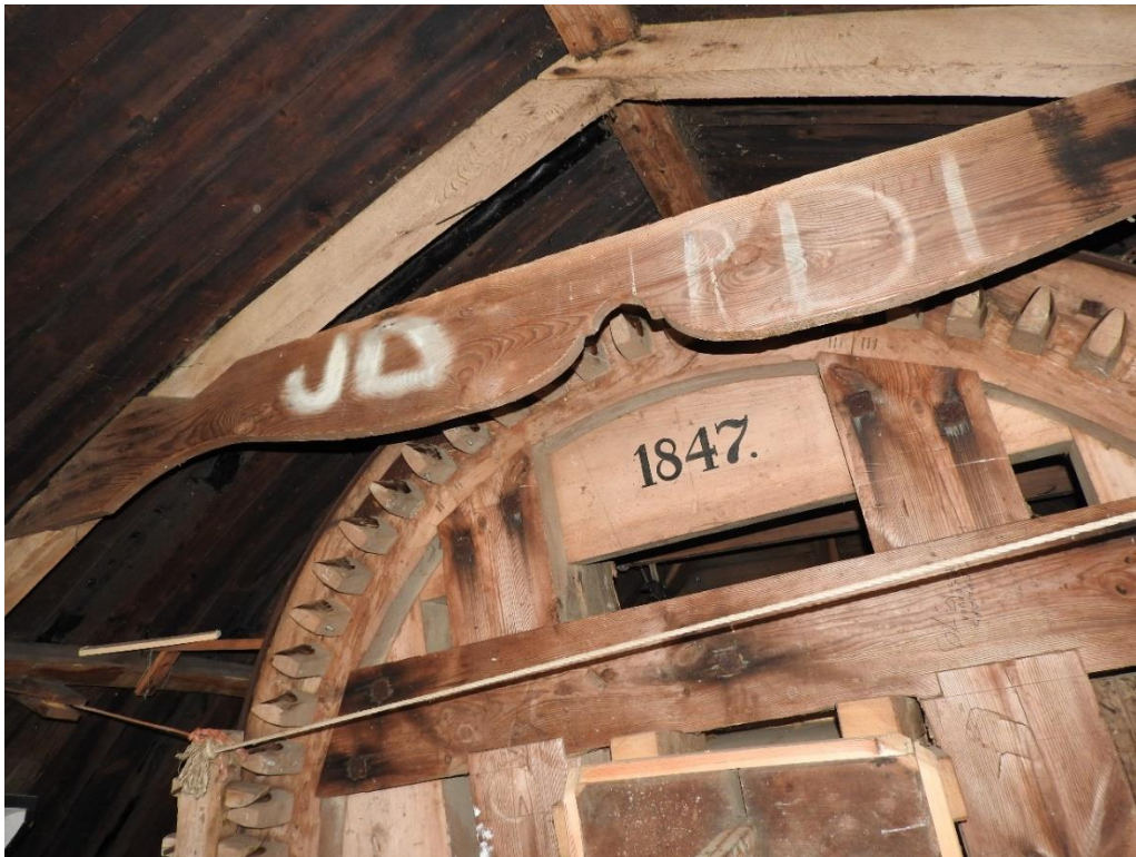
Afbeelding 4.100: Het bovenwiel met stalen bandvang op de kapzolder, met jaartal van de bouw van de molen te Niekerk. De vang wordt gebruikt om de molen stil te zetten.
