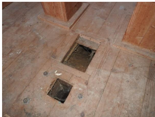
Afbeelding 4.30: Openingen voor het storten van gort (boven) en een niet gebruikte opening (onder) op de eerste zolder.
