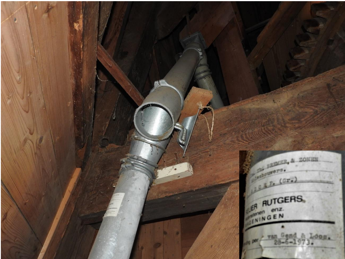
Afbeelding 4.77: IJzeren buis voor transport van de gort na het pellen, die niet in gebruik is geweest. Deze buis stamt uit 1973 (zie inzet sticker rechtsonder) en is dus slechts tien jaar gebruikt. Met een schuif werd het gort ofwel naar beneden geleid (via de buis midden links) ofwel naar het linker halfschilhoek (de toegang in het midden).
