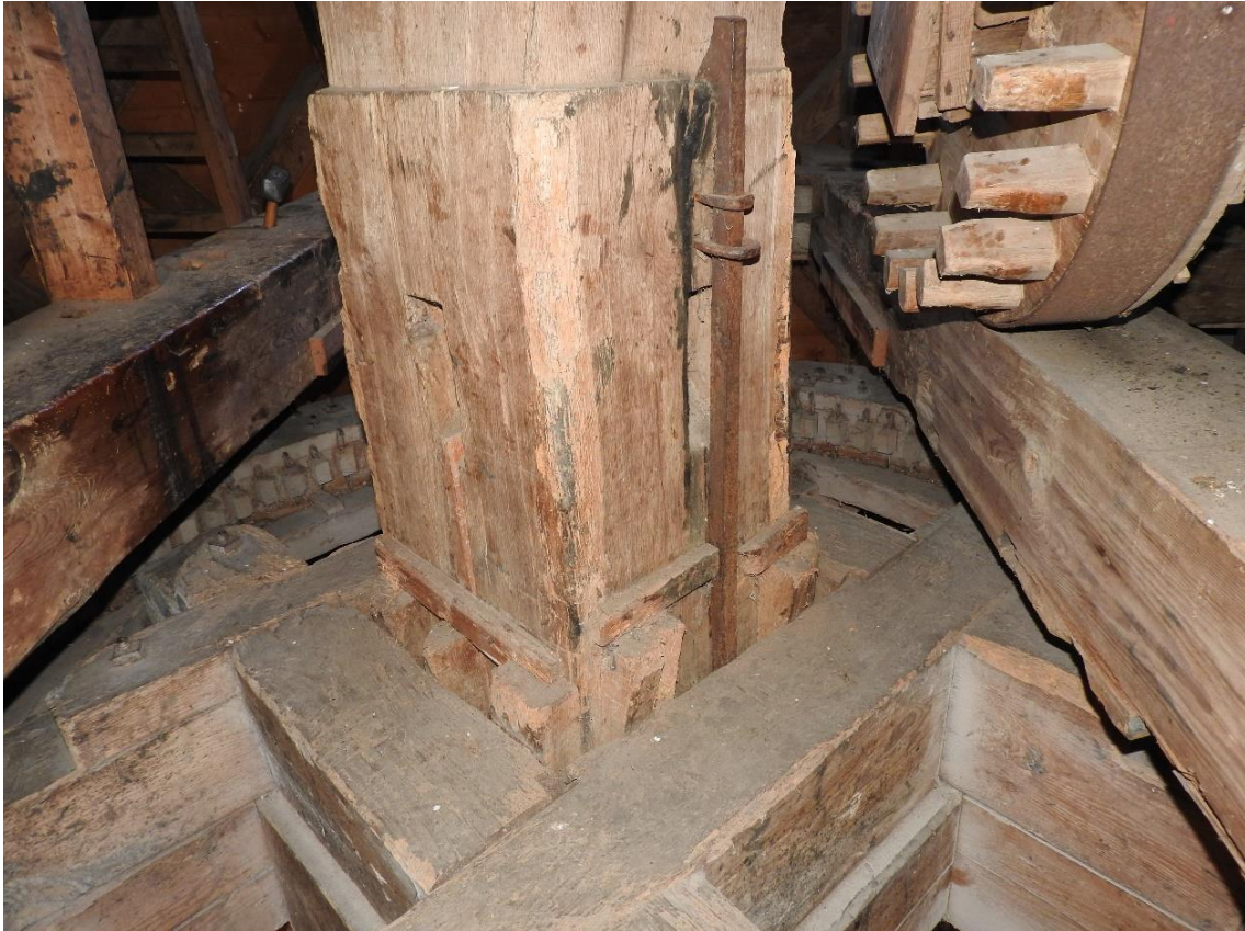
Afbeelding 4.83: De koningsspil, die oorspronkelijk de staak (standerd) van de standermolen uit Niekerk was. De kepen van de verbindingen zijn nog zichtbaar. Rechts het luiwiel.
