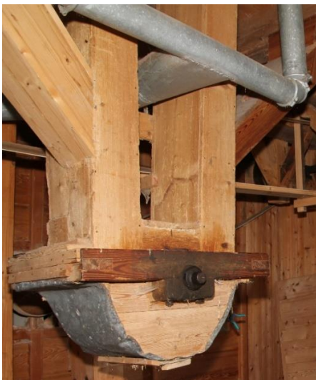
Afbeelding 4.38: De jacobsladder voor het transport tussen de voorloper en de naloper en de pellerij.
