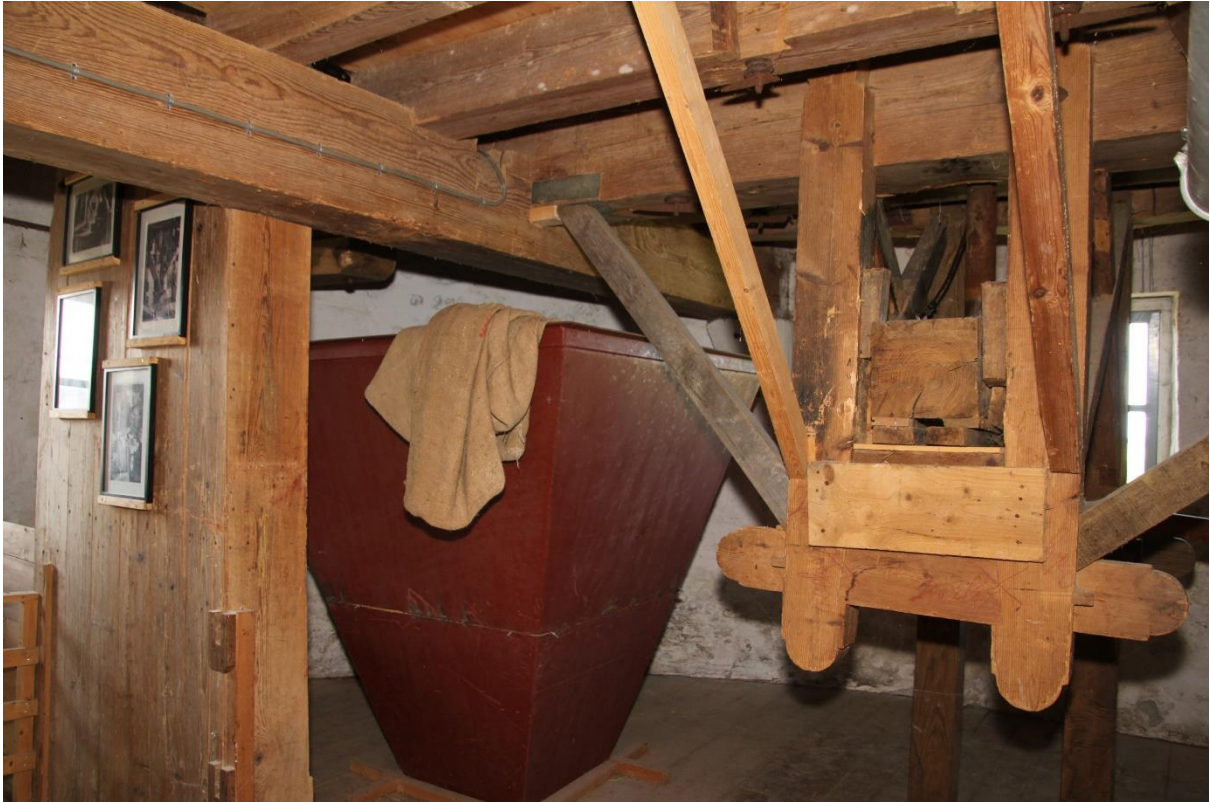
Afbeelding 4.34: De wanzolder, met in het midden de opslagsilo voor haver en rechts het paard (hangende constructie) van de voorloper van de pellerij.
