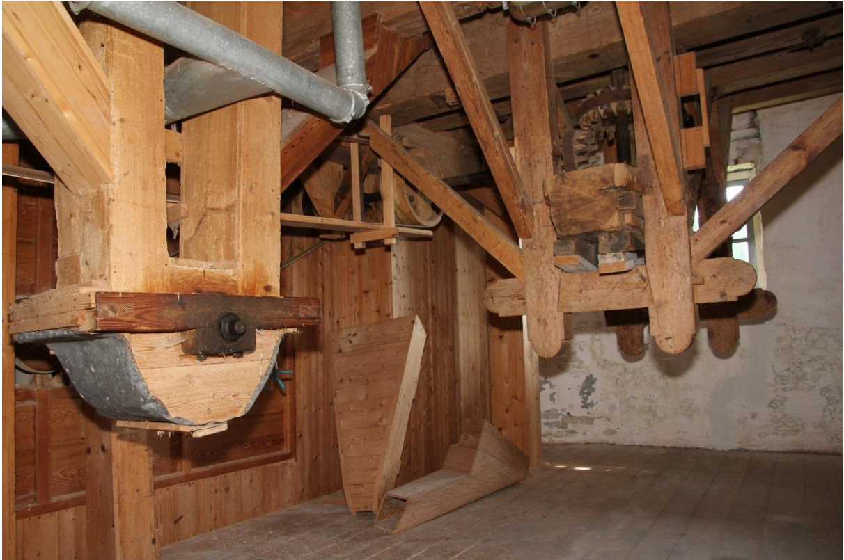
Afbeelding 4.37: Overzicht van de wanzolder met links de jacobsladder voor het transport van de gort en rechts de naloper van de pellerij. Op de achtergrond de wanmolen (waaierkast) en een tweetal houten stortkokers. De linker koker werd gebruikt na het pellen om de gort via een (niet meer zichtbaar) gat in de vloer naar de linker opslagruimte op de opslagzolder te brengen; de rechter koker was de verbinding tussen de waaierkast en de jacobsladder, waarbij de gepelde gort uit de waaierkast via de jacobsladder omhoog werd geleid om nogmaals gepeld te worden.
