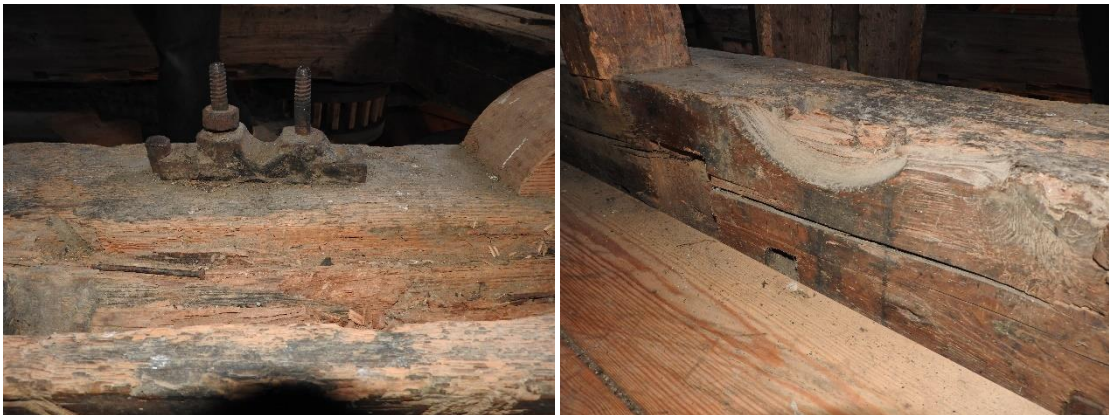
Afbeeldingen 4.87 en 4.88: Sporen van eerder gebruik van de schaarbalk: een oude lagering van eerder gaand werk.
