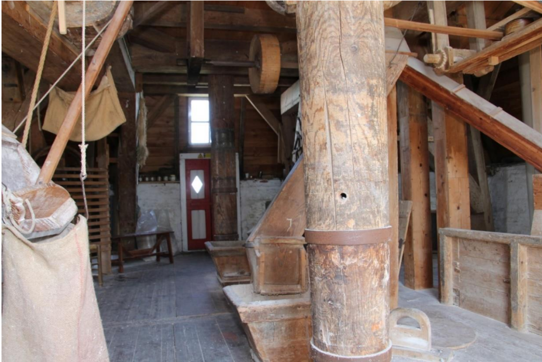
Afbeelding 4.57: De stellingzolder vanaf de stelling. Op de voorgrond in midden de pelspil van de naloper. Daarachter de stortkoker en pelkaar van de naloper. Uiterst links de maalbak van de malerij.
