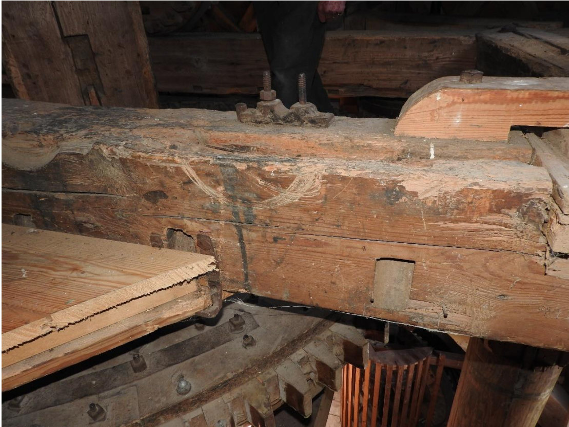
Afbeelding 4.86: Eén van de schaarbalken boven het spoorwiel, die oorspronkelijk als roede gebruikt is. Dit is op de afbeelding te zien aan de gaten voor de hekstocken.
