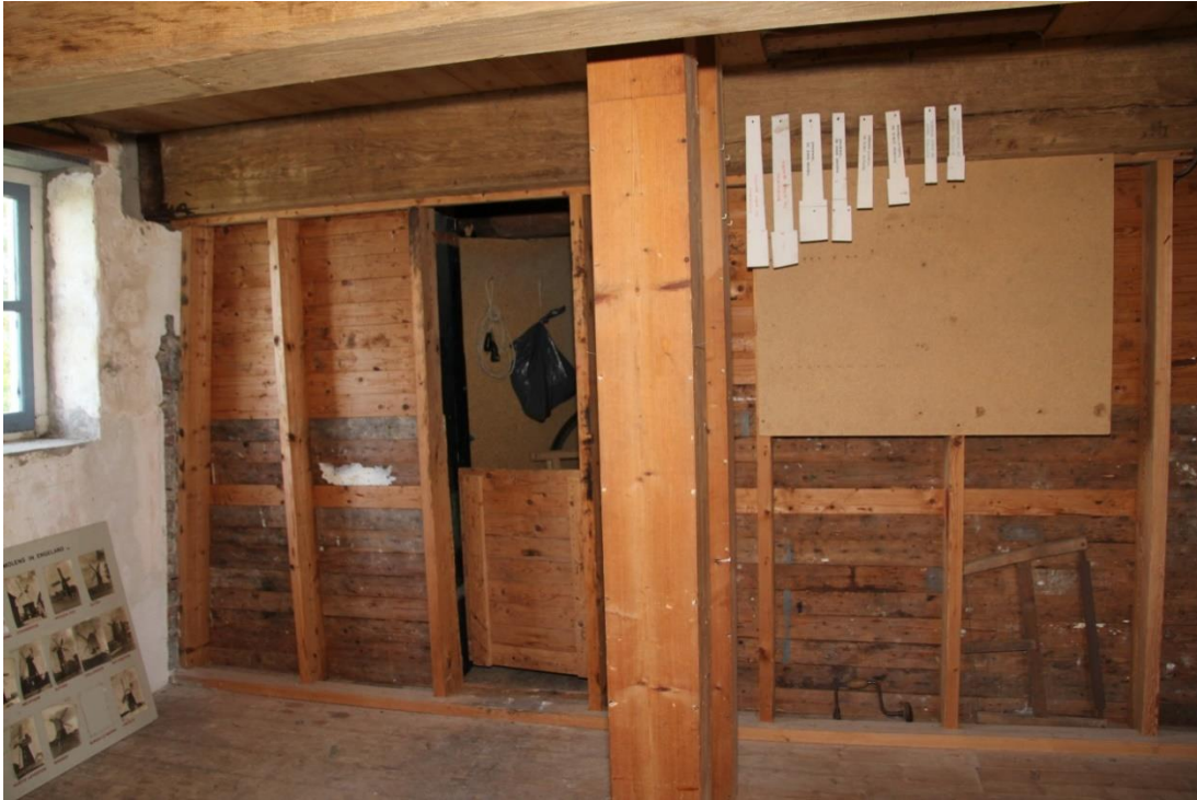
Afbeelding 4.25: De eerste zolder met scheidingswand, waar achter het gort werd opgeslagen. In het midden de kokers van de jakobsadders, die de gerst van beneden naar de halfschilhoeken op de steenzolder brengt.
