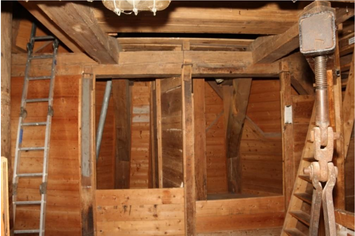
Afbeelding 4.71: De halfschilhoeken voor de opslag van gerst/gort op de steenzolder, voordat deze naar de pelstenen getransporteerd wordt.
