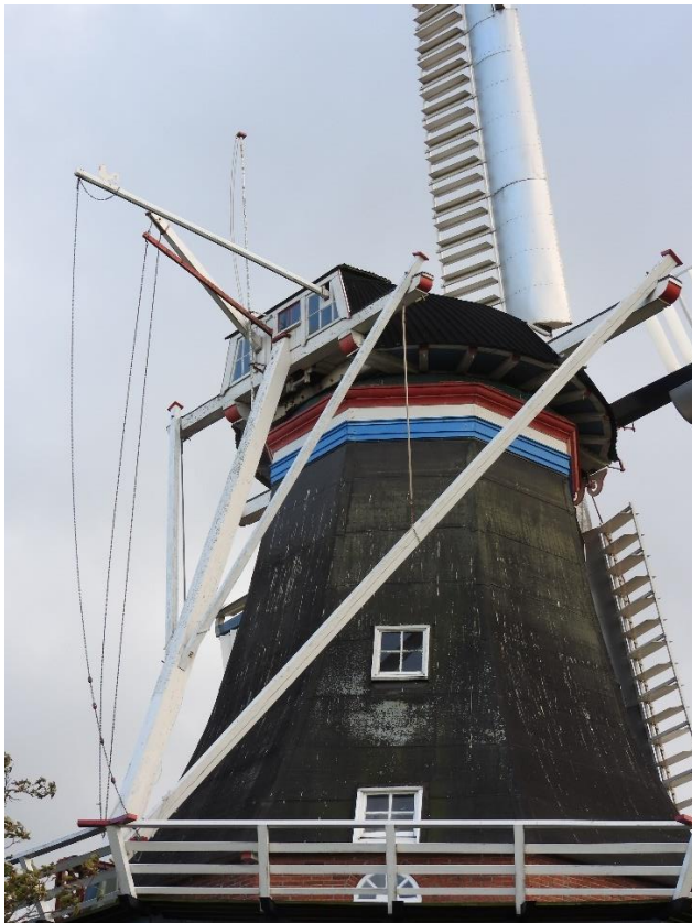
Afbeelding 4.8: De staartconstructie van de molen vanaf de noordzijde.
