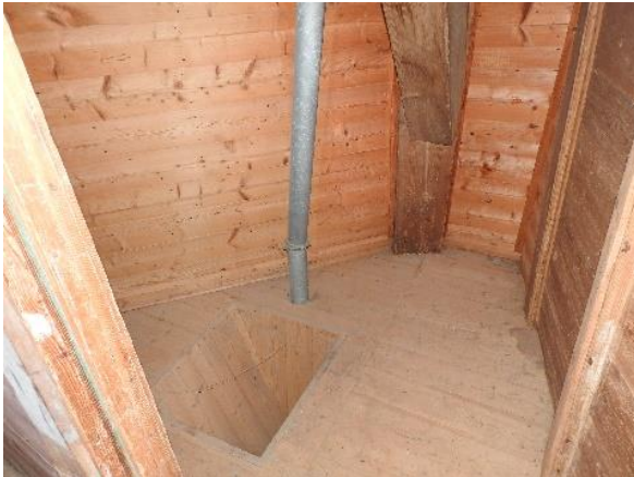
Afbeeldingen 4.72 en 4.73: Het linker (links) en rechter (rechts) halfschilhoek met opening naar de voorloper.
