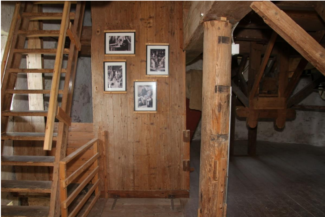
Afbeelding 4.31: De wanzolder, met links de trapopgang naar de stellingzolder, midden links foto's van het molenbedrijf en midden rechts een staander die naar verwachting dienst heeft gedaan als maalspil.
