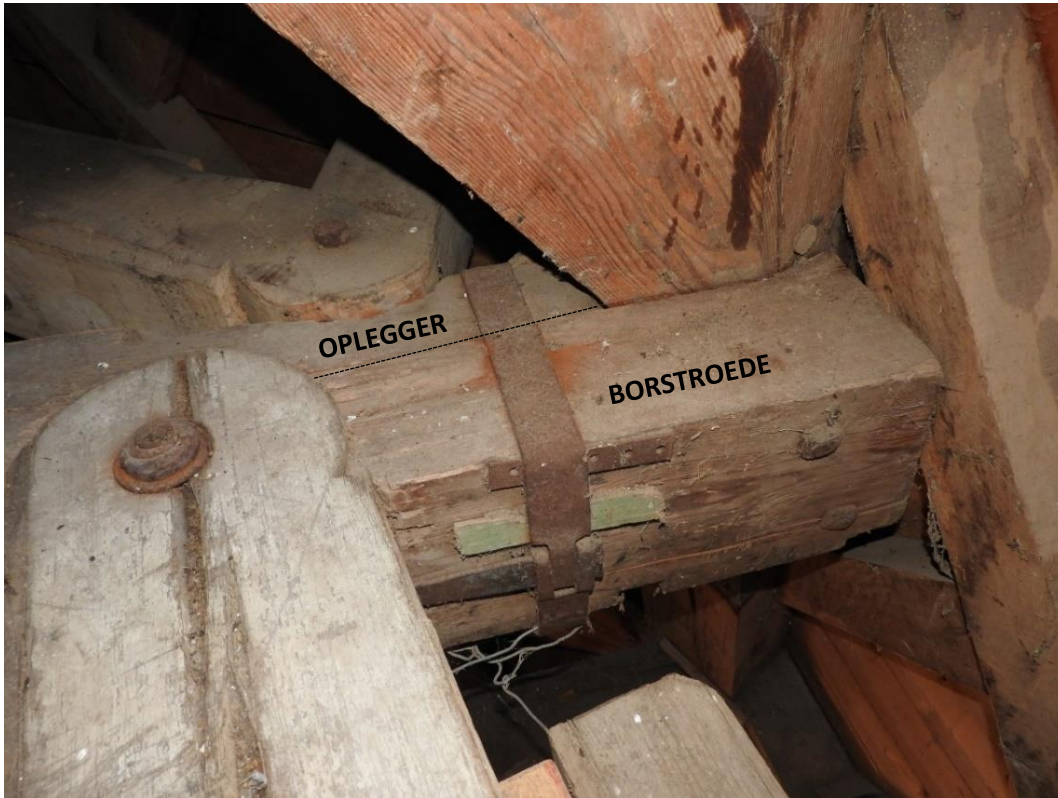
Afbeelding 4.89: De schaarbalk, oorspronkelijk een houten borstroede (rechtsvoor) met oplanger (links achter). De haaks opliggende wervelbalken zijn met de roede verbonden.
