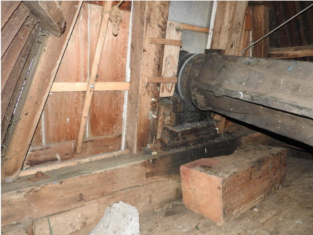
Afbeelding 4.98: Het voorkeuvelens, de windpeluw (onder) en de bovenas met halssteen aan de voorzijde van de kapzolder.
