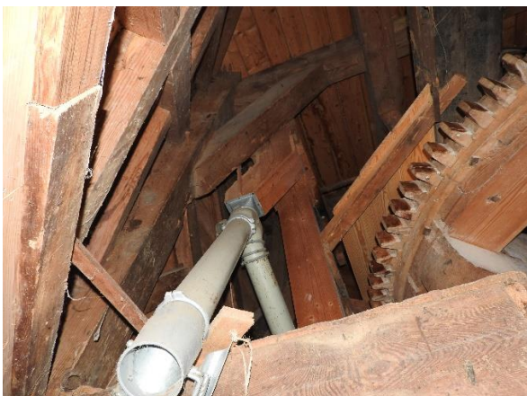
Afbeeldingen 4.78 en 4.79: Bovenzijde van de transportbuis (links) en verbinding met storkoker van de jakobs ladder (rechts). Ook bij deze verbinding zat een schuif voor de toegang naar één van beide halfschilhoeken.
