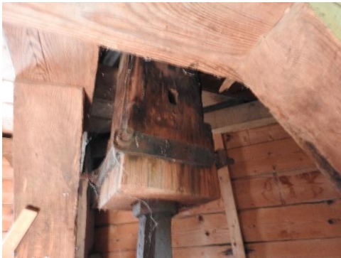
Afbeelding 4.65: De steenzolder met door latten afgeschermdde spil en wielen voor de aandrijving van de haverpletter op de stellingzolder.
