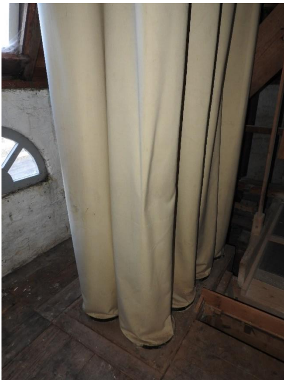
Afbeelding 4.55: De luchtzakken voor de stofafzuiging van de pelstenen op de dustvloer.
