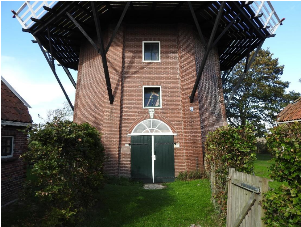
Afbeelding 4.5: De onderbouw van de molen met toegangsdeuren vanaf de zuidzijde.
