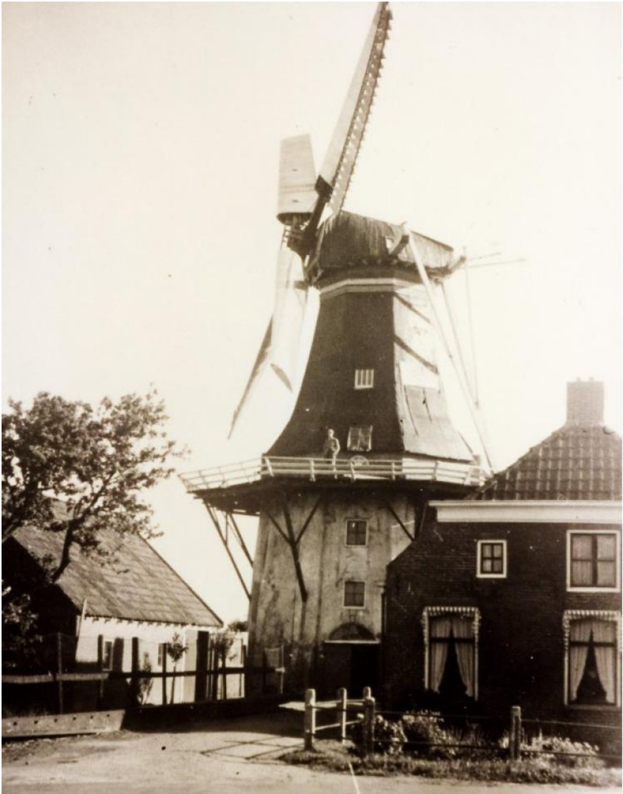
Afbeelding 3.1: Archieffoto uit juni 1944 van molen De Jonge Hendrik te Den Andel, met op de buitenroede het systeem Bremer. Op de binnenroede de Dekkerstroomlijn met zelfzwiching. 11
