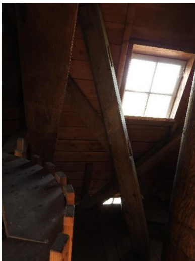
Afbeelding 4.63 en 4.64: Links de staander van de oude steenkraan op de steenzolder. Rechts de bevestiging van de kraanbeugels van de steenkraan. De kraanbeugels kunnen zo nodig hoger bevestigd worden, zodat de steen over de bolspil heen kan wordt gedraaid.
