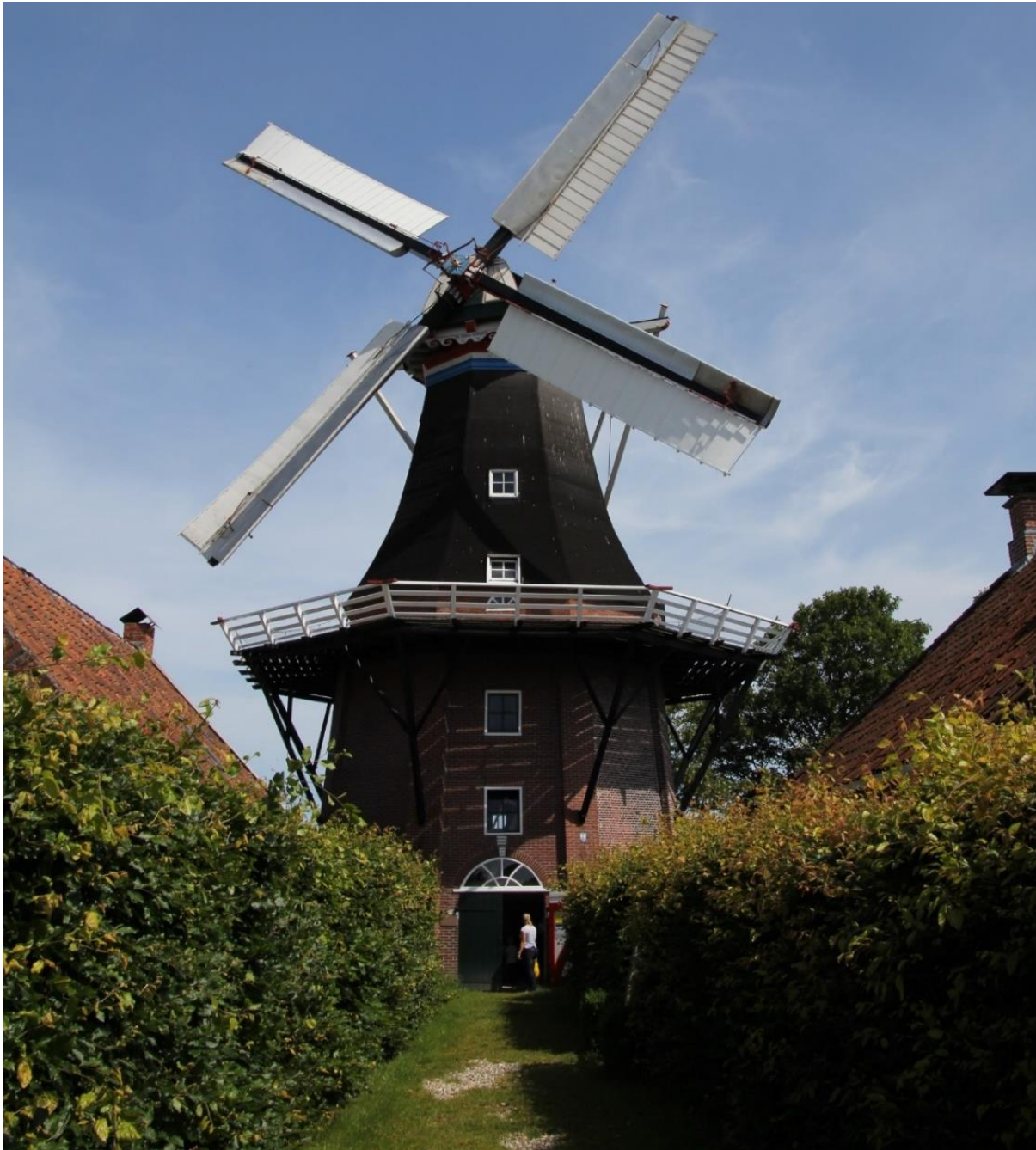
Afbeelding 4.3: Het erf naar de molen vanaf het zuiden.
