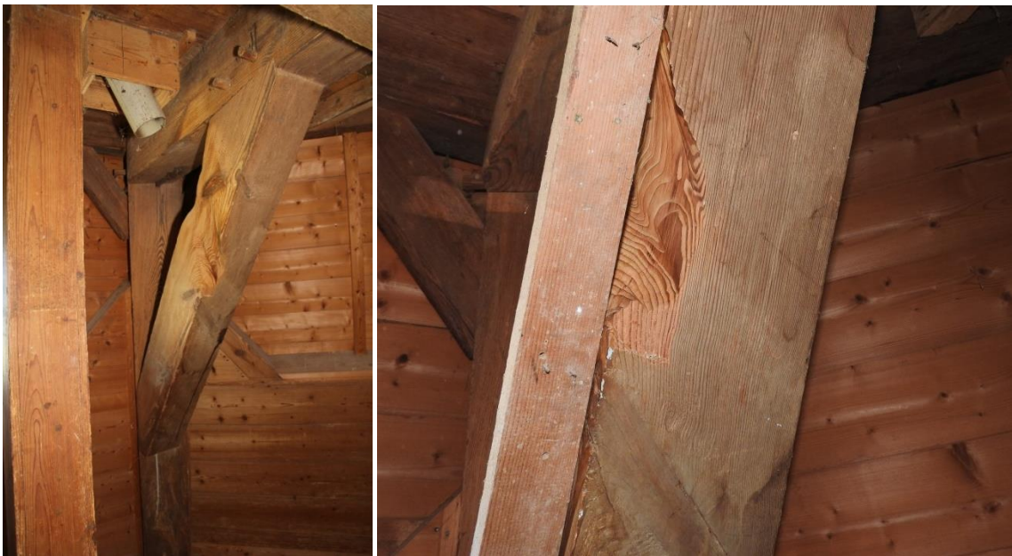
Afbeeldingen 4.75 en 4.76: Links het halfschilhok rechts op afbeelding 4.71 voor gerst/gort. Het korbeel rechts onder het gat is door de scherpe randen van de gerst uitgesleten (rechts).
