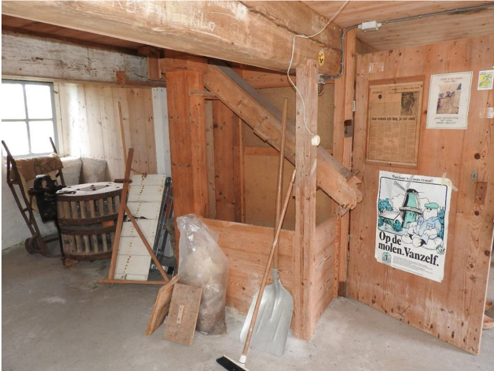
Afbeelding 4.14: De begane grond van de molen links achter, met de jakobsladders voor het transport van gerst naar de halfschilhokken, de stortkoker voor de gort en de deur naar de koffiehok.
