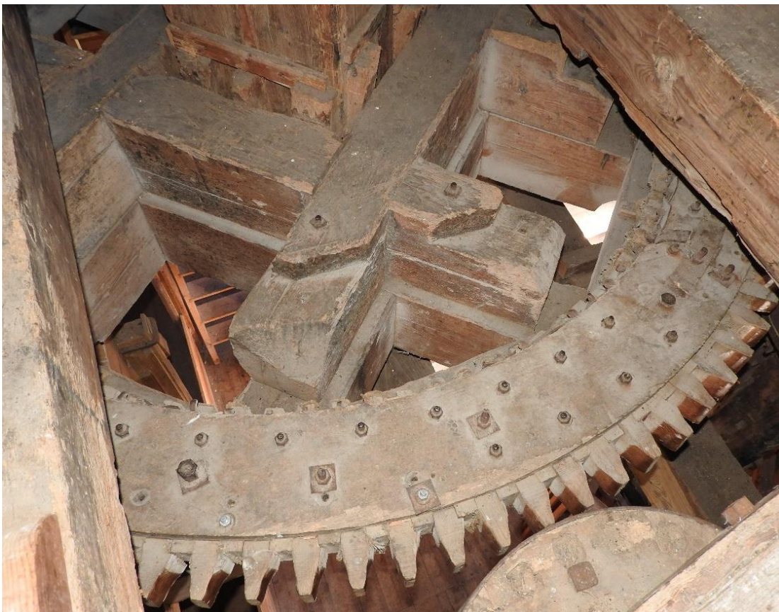
Afbeelding 4.92: In de kruisarmen van het spoorwiel zijn de inkepingen voor de plooiestukken van het bovenwiel nog zichtbaar.
