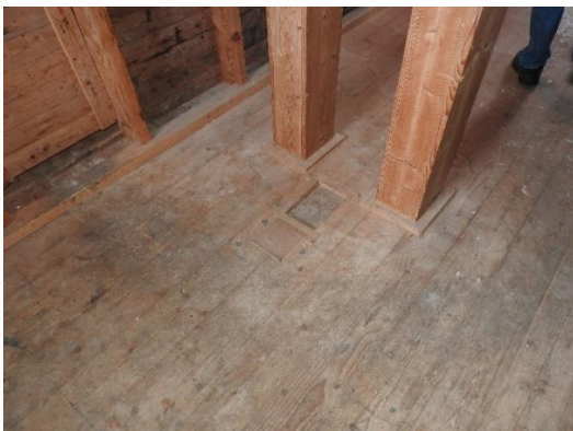
Afbeelding 4.29: Afgedekte openingen in de vloer van de eerste zolder.
