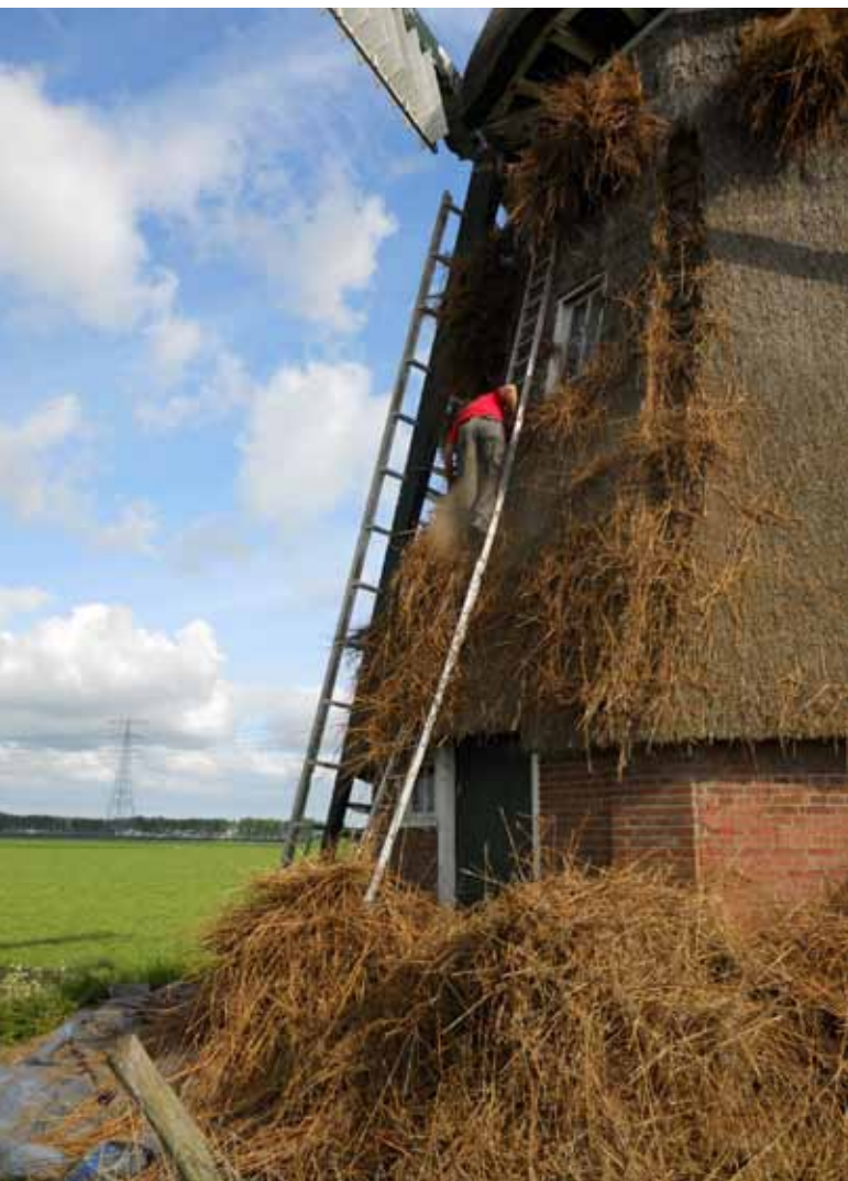
HET VERWIJDEREN VAN HET RIET VAN HET ACHTKANT
