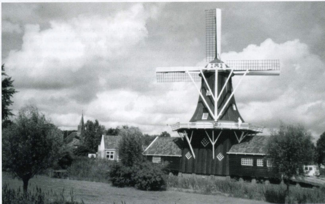
Houtzaagmolen Fram gezien vanaf de dijk van het Eemskanaal NZ.
