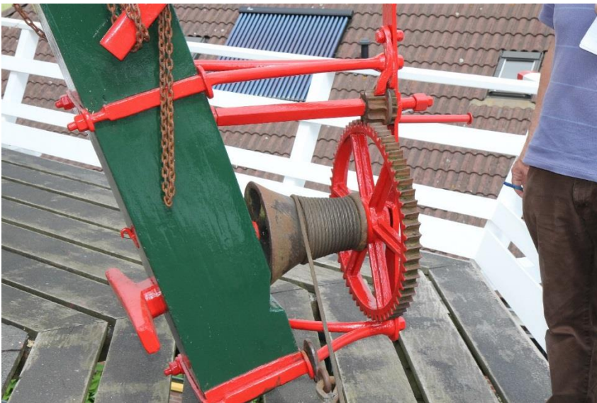
14. De smeedijzeren lier is nog grotendeels origineel.
