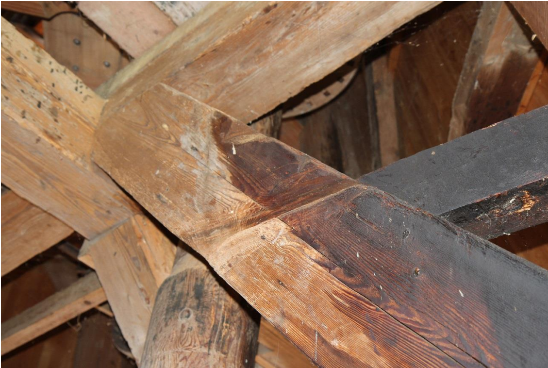
19. Het slijtspoor van de touwsnaaraandrijving. Het olie- en vetspoor van een latere transmissie loopt hier dwars doorheen.
