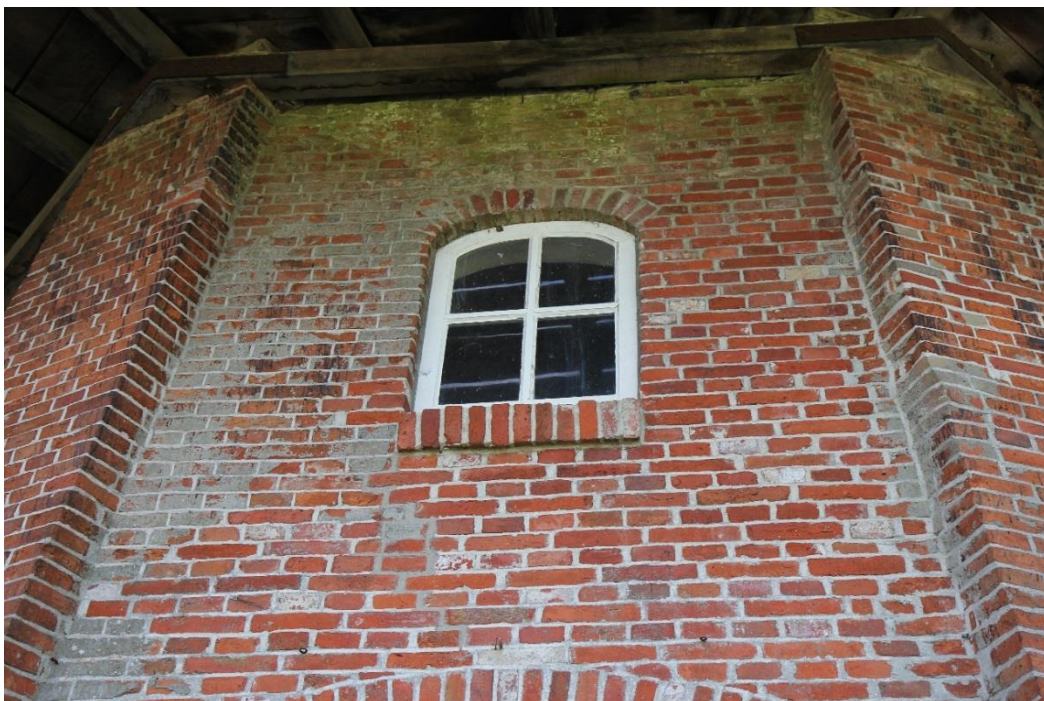
10. Detail van het muurwerk aan de westzijde. De sporen van de pleisterlaag zijn nog goed te zien. Voor het aanbrengen van de binnensluiting heeft men simpelweg hoeken van de penanten weggehaakt.
