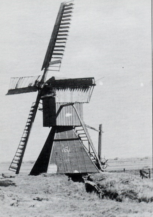
Midwolda, spinnekop van de Ennemaborg uit 1863. Vlucht 15,20 meter. Als laatste Groninger spinnekop gesloopt in 1949. Foto: B. van der Veen Czn., 1943.
