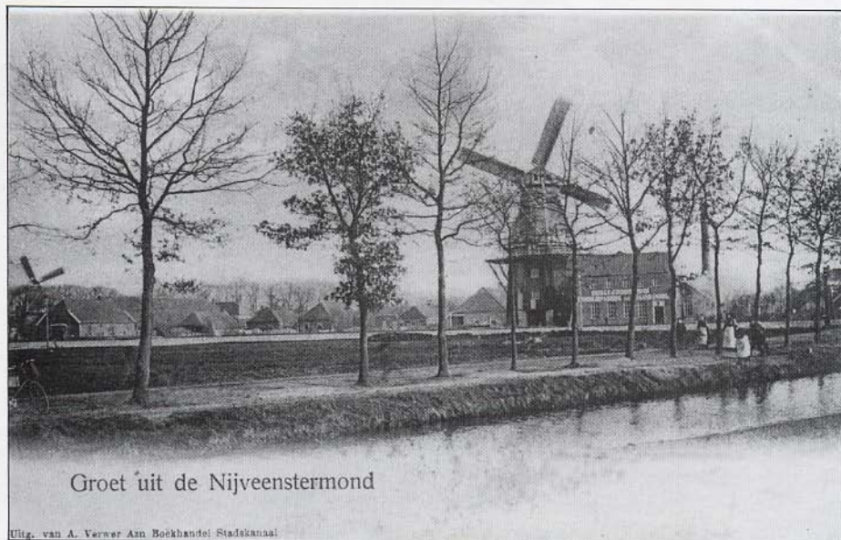
Een Ansicht van omstreeks 1900. Rechts de met zelfzwiching uitgeruste molen uit 1848. Op de gevel van het gebouw naast de molen staat geschilderd: Firma F.J. Doornbosch, Meelfabriek en Graanhandel. Links in de verte de molen van Kuipers, malende met zeilen. Collectie: H.A. Hachmer.
