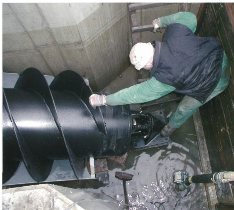
DE TIJDELIJK GEPLAATSTE NIEUWE VIJZEL IS VOORZIEN VAN EEN BEKISTINGSPLAAT
