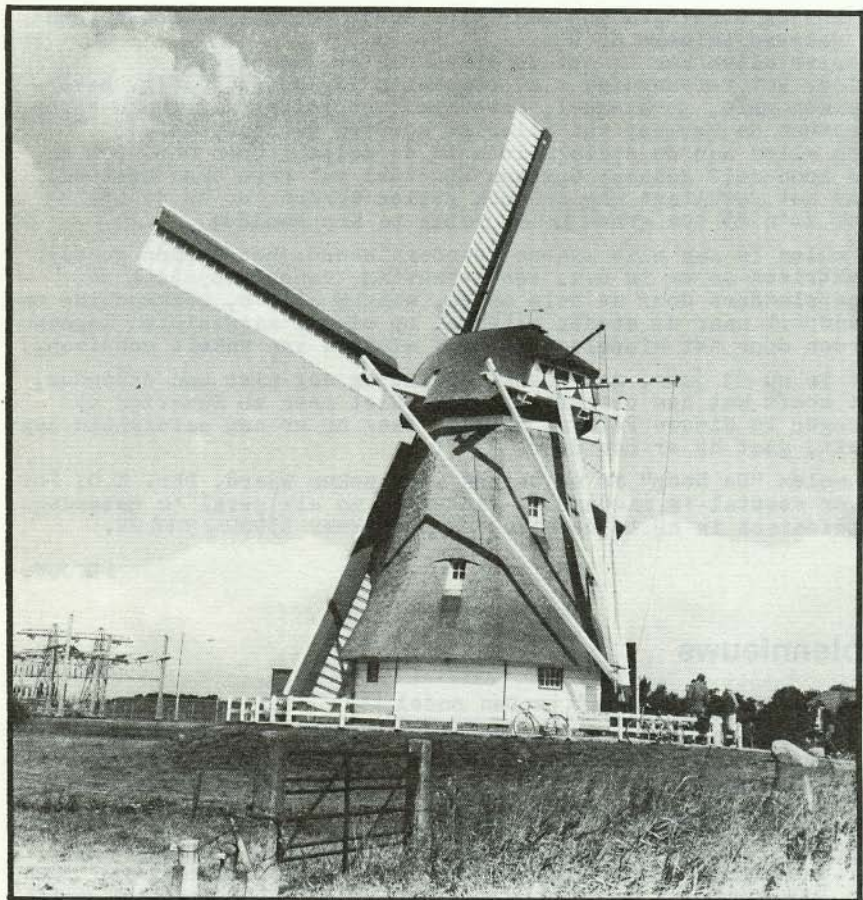
Korenmolen - grondzeiler "De Hoop" in Kropswolde. Men ziet, dat deze molen is uitgerust met Fauël-wieken en zelfzwiching.
