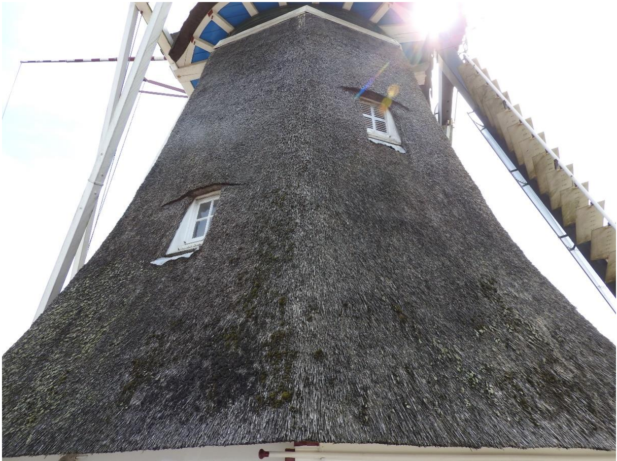
Afbeelding 4.9: De romp van de molen vanuit het noorden: een met riet gedekt achtkant voorzien van kistramen.
