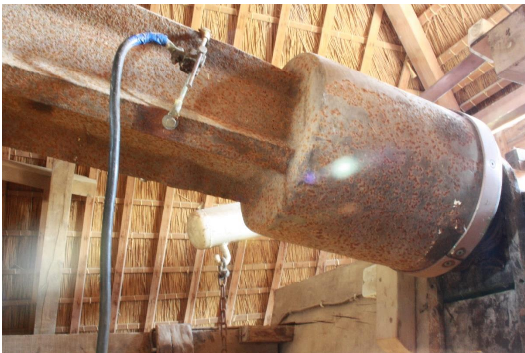
Afbeelding 4.45: Bovenas met bliksembeveiliging (links) en pensteen (rechts) op de kapzolder.
