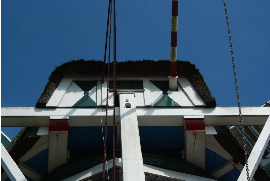
Afbeelding 4.15: De achterzijde van de kap vanuit het oosten, met losse bezaan met zwichtketting (midden) en vangstok (rechts).
