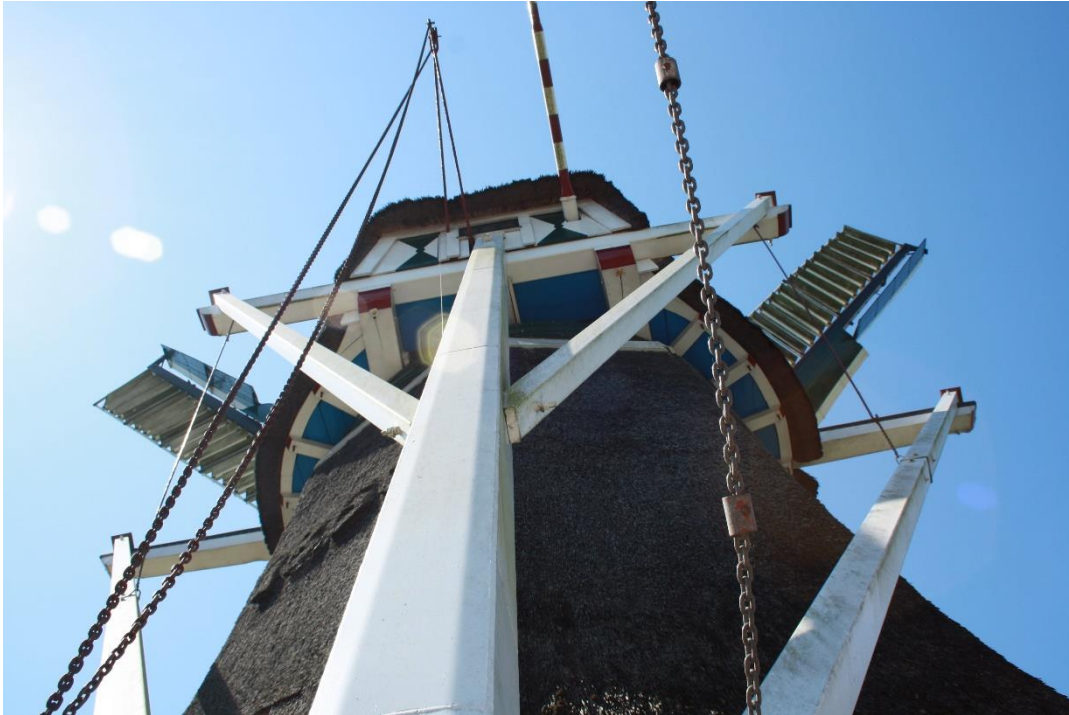
Afbeelding 4.11: De staartconstructie van onderaf met losse bezaan met zwichtketting (midden links) en vangstok met vangketting (midden rechts).
