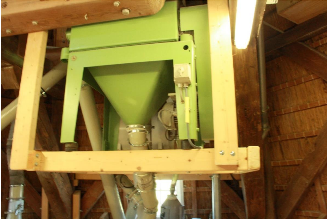
Afbeelding 4.28: De controle zeefinrichting (voor bijv. hout of metaalsplinters).
