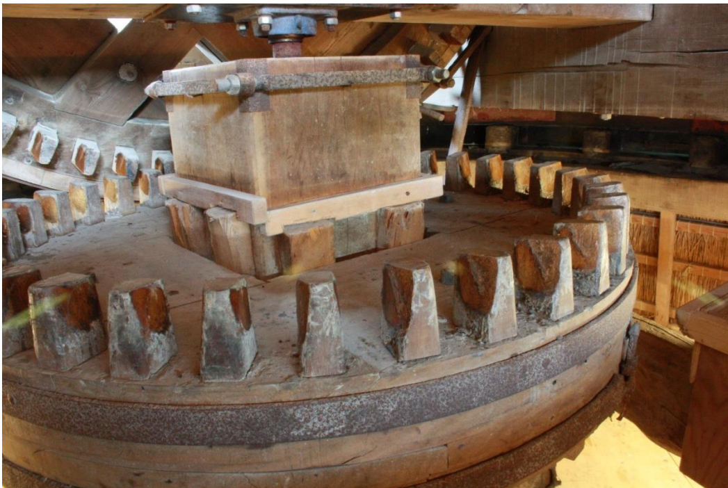
Afbeelding 4.48: De bovenbonkelaar (op de voorgrond) en het bovenwiel (op de achtergrond) op de kapzolder. Het bovenwiel heeft 61 kammen, de bovenbonkelaar 36. Er is sprake van een ruime overbrenging tussen het bovenwiel en de bovenbonkelaar.
