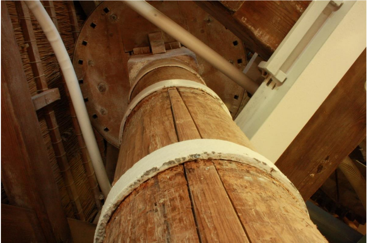
Afbeelding 4.32: De houten maalspil van de barksteen.
