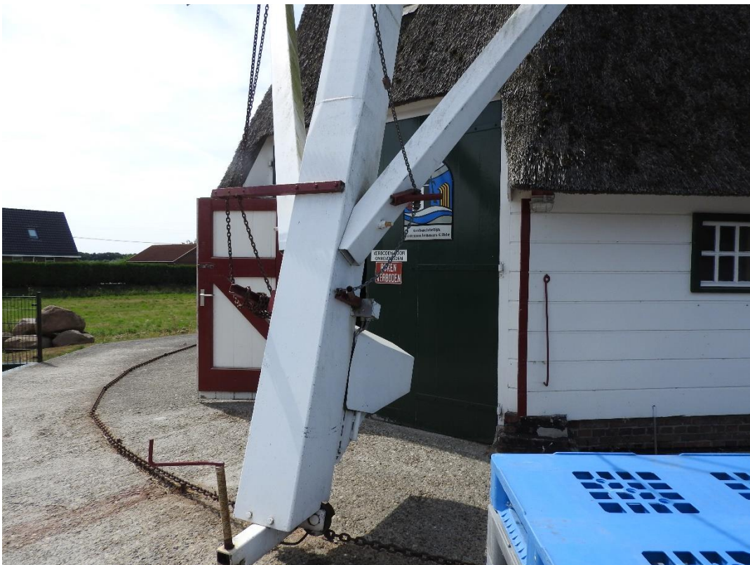
Afbeelding 4.12: De staart met kruilier, die wordt aangedreven door een reductiekast met een motor er in.
