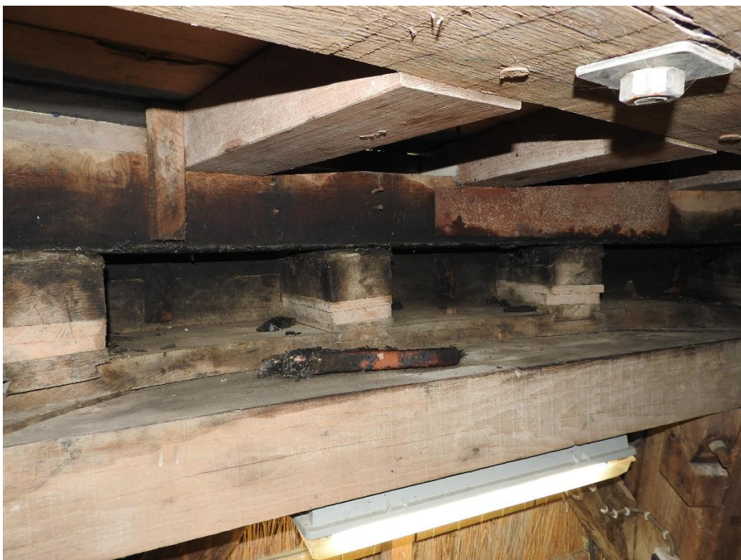
Afbeelding 4.49: Tussen de huidige neuten zijn (van verschillende dikten, van enkele millimeters tot 4 cm) plankjes van oude neuten geplaatst, zodat de kap weer waterpas kwam te staan ten opzichte van de betonnen vloer om de molen.
