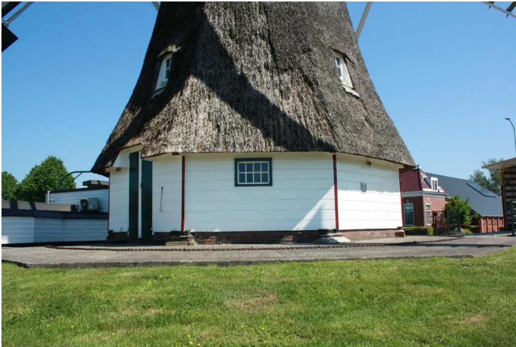
Afbeelding 4.7: De onderbouw van molen De Hoop vanuit het zuiden: een met horizontale planken gedekt onderstuk.
