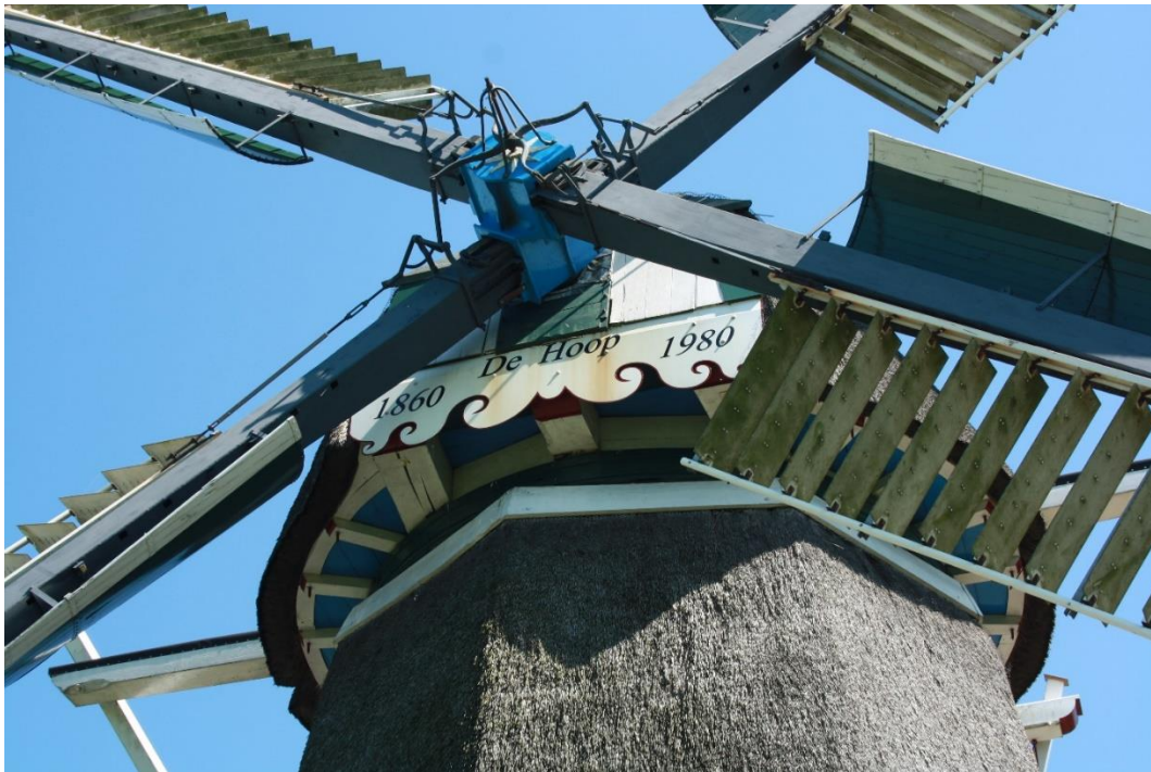
Afbeelding 4.17: Het wiekenkruis van de molen met askop met spin voor de zelfzwichting en de baard met het bouwjaar van molen De Hoop te Vierlaten (1860), waarvan de kap en het achtkant zijn gebruikt voor de bouw van De Hoop te Kropswolde, en het jaar van restauratie van de molen (1980).
