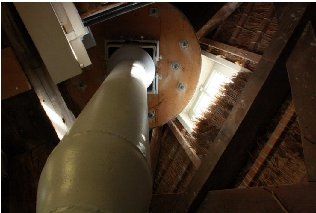
Afbeelding 4.31: De stalen maalspil van de flintsteen, gefabriceerd door dhr. L. Duim.
