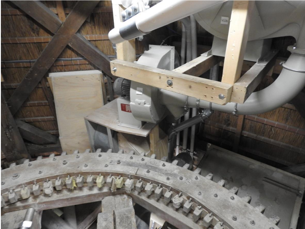
Afbeelding 4.35: De stofafzuiging op de luizolder (rechtsboven). Oorspronkelijk bevonden zich tot op deze zolder de graansilo's.
