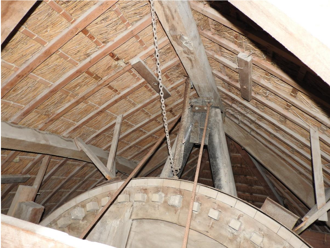
Afbeelding 4.43: Het bovenwiel met stalen bandvang aan de buitenzijde.
