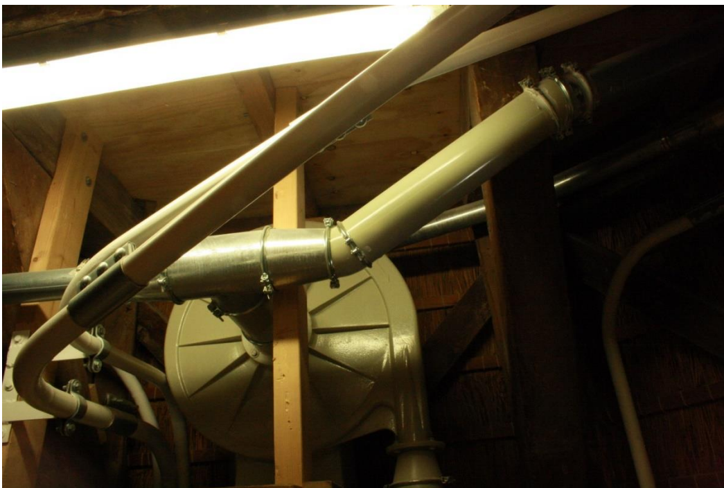
Afbeelding 4.36: De buizen van de stofafzuiging op de luizolder.
