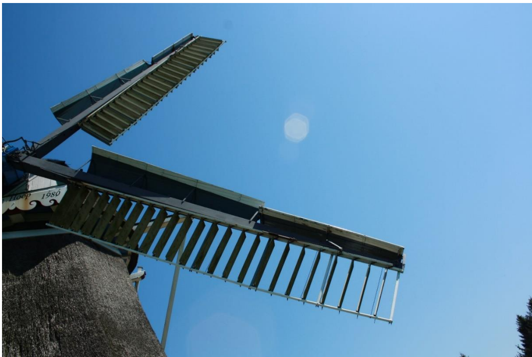
Afbeelding 4.18: Het gevlucht van de molen, uitgerust met zelfzwichting met fokwieken en remkleppen.
