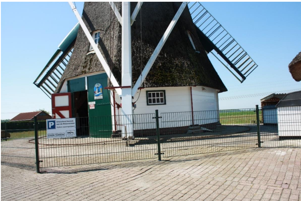
Afbeelding 4.8: De onderbouw van molen De Hoop vanuit het noordoosten. In het midden de staartconstructie.
