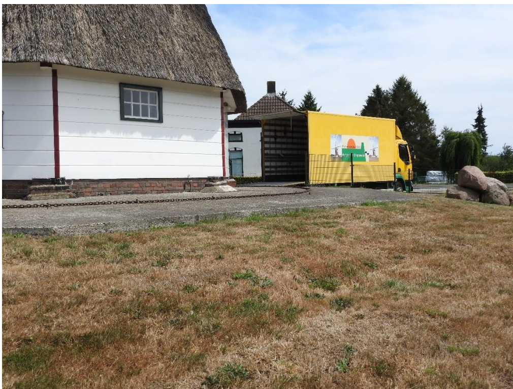
Afbeelding 4.3: De molenbelt van de molen met betonvloer rondom de molen vanaf het zuidwesten. De vloer is aangebracht om de stiepen van de molen bijeen te houden.
