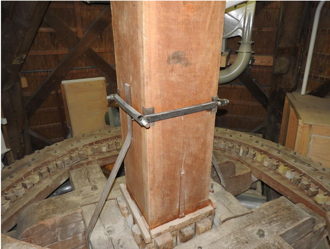
Afbeelding 4.33: Het spoorwiel op de luizolder, waarvan de kruisarmen nog origineel zijn. De velgen zijn uit de tijd van de restauratie van 1979-1981. De koningsspil is 41 cm vierkant van bilingahout. De wiggen in de koningsspil zijn hergebruikt.
