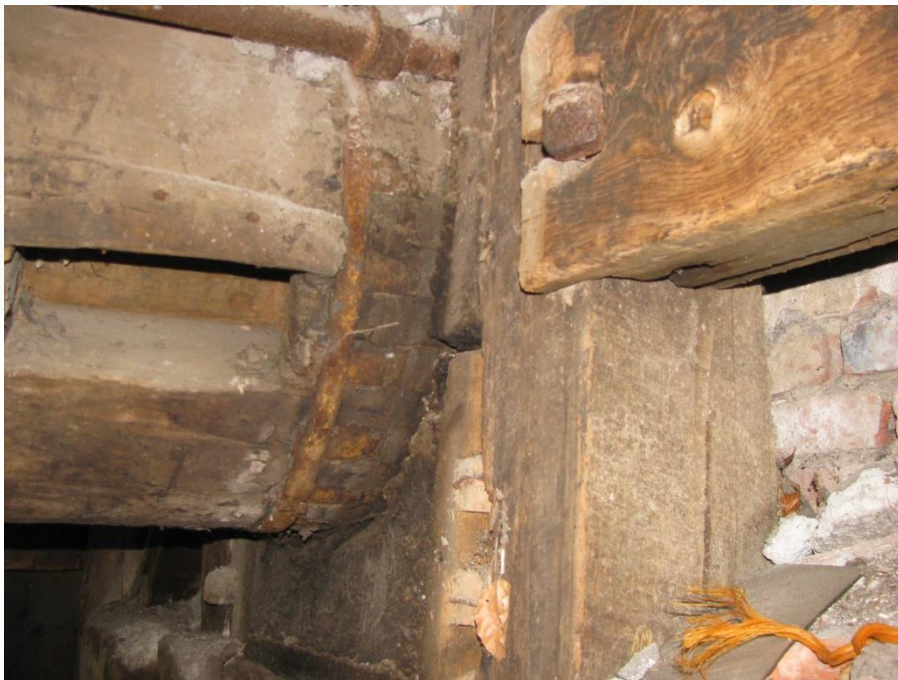
Figuur 39 Lagering wentelas tegen de molenmuur. Te zien zijn de halssteen en de schenen in de as. De eerste spaak zat zo dicht tegen het lager dat de lagerbalk hiervoor moest worden uitgekeeft (zie hiervoor de voorgaande foto).
