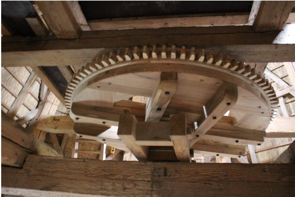
Figuur 54 Deling in de spil bij de koren- en oliemolen te Oldebroek. Het takrad zit vast op de bovenste spil, het raamwerk daar onder op de onderste spil. Met houten koppelhouten kunnen rad en raamwerk worden gekoppeld.
