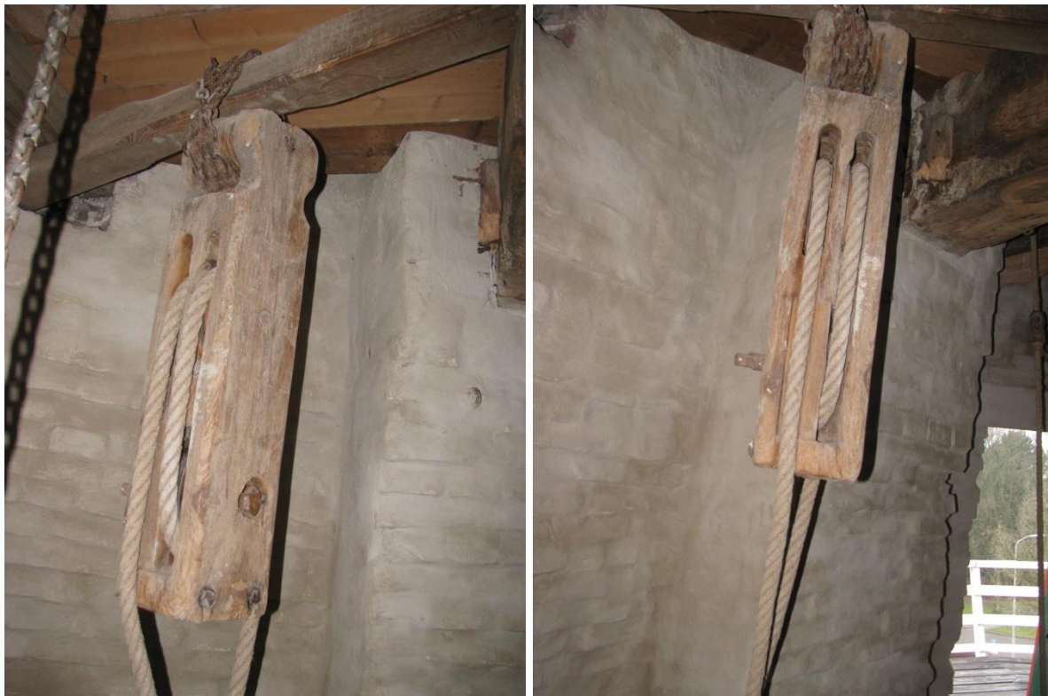
Figuur 80 Afschietwerk op de maalzolder
