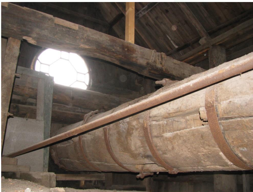
Figuur 37 Wentelas in gebouw 2 met rechtsboven een spantplaat met daartegen nog de oorspronkelijke houten buitenwand.
