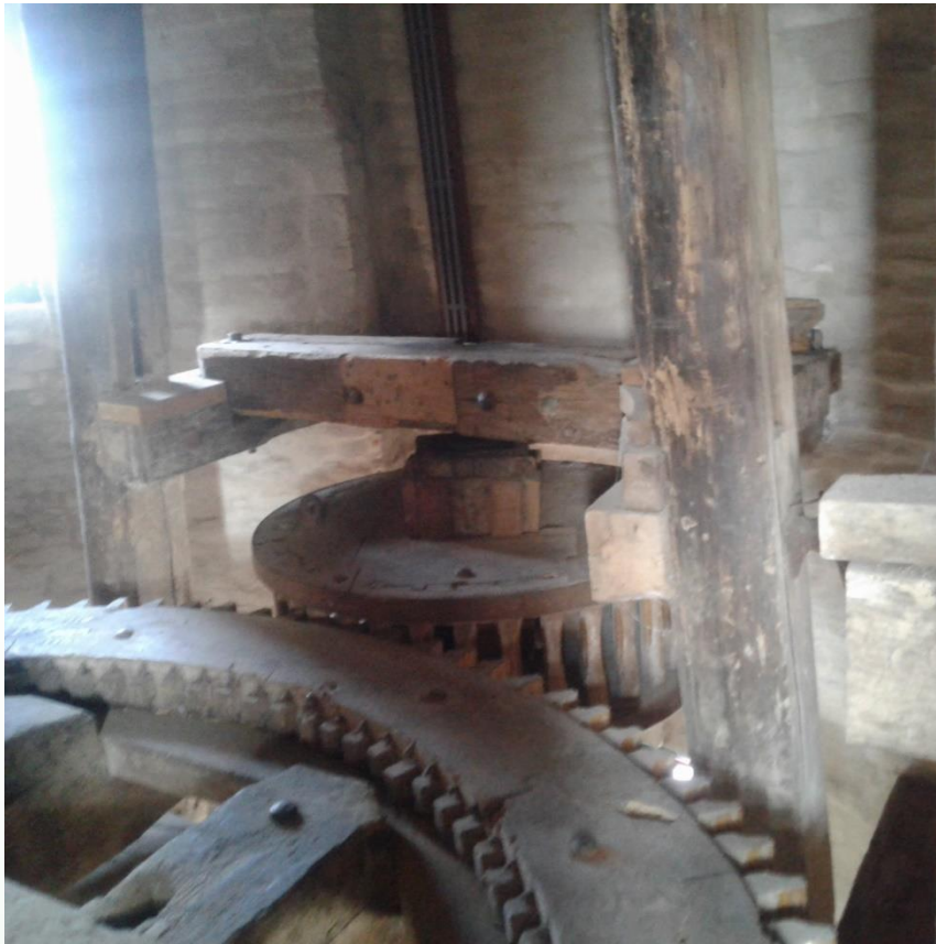
Figuur 62 Stoelconstructie voor het opvangen van de ijzerbalk.
