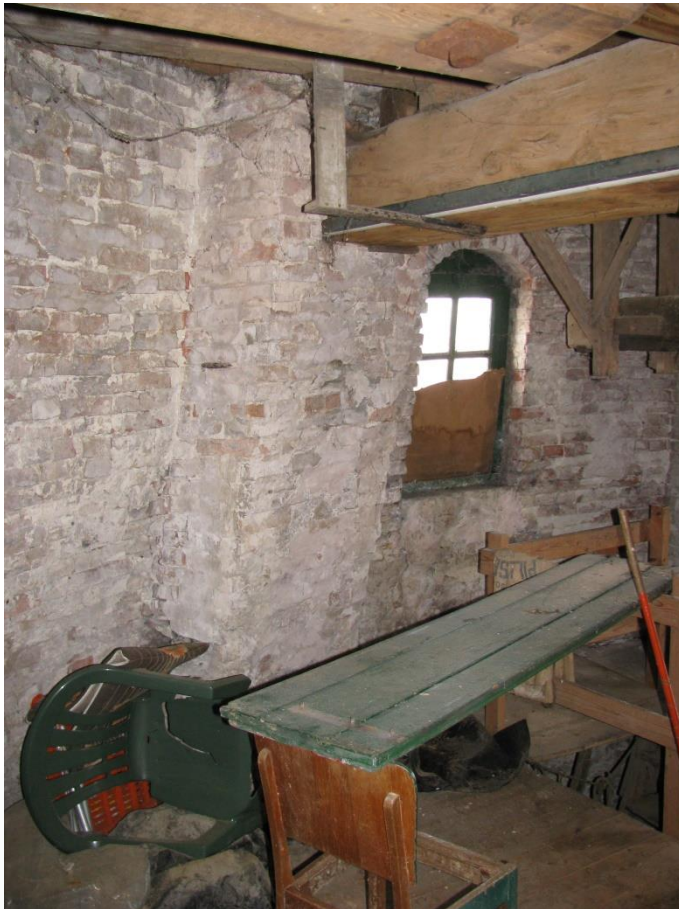
Figuur 13 De zolders van de molen bestaan uit vier kruisbalken die zijn opgelegd in de acht steunberen.
