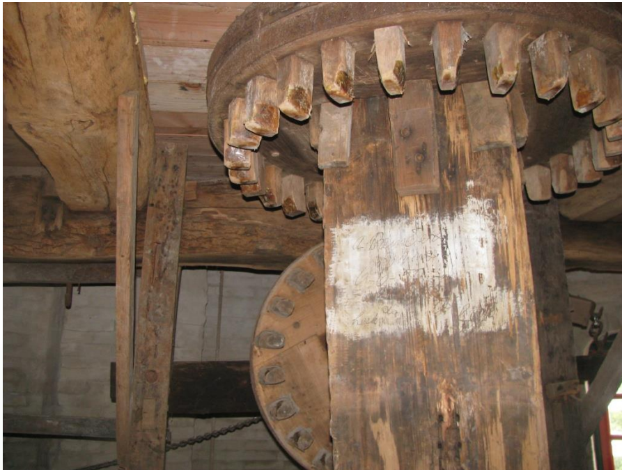
Figuur 59 Op de voorgrond de spil met daarop, net onder de kapzolder, het grote luiwad. Op de achtergrond het kleine luiwad met luiketting. Boven het luiketting de lichtbalk met rechts van de spil de lichtstok.
