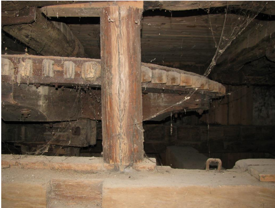
Figuur 67 Takrad van de stoomaandrijving met daaronder het oude koppelraam.
