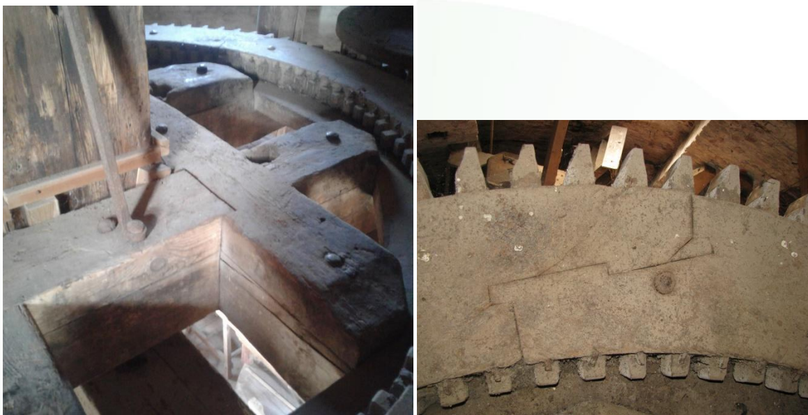
Figuur 61 Links de bovenste kruisarmen takrad met hangers, rechts een las in de ring.
