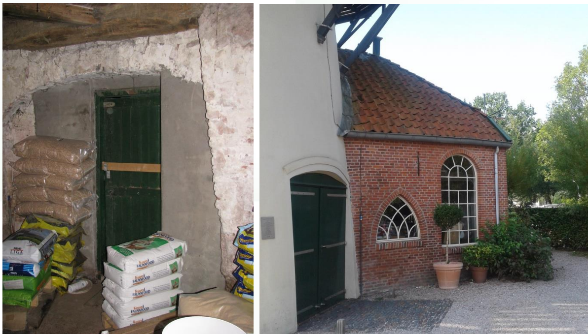
Figuur 31 Links de groene deur vanuit de binnenzijde. Hij zit in de dichtgemetselde uitgang. Rechts de toestand in 2018, waar de oude uitgang weer is teruggebracht.
