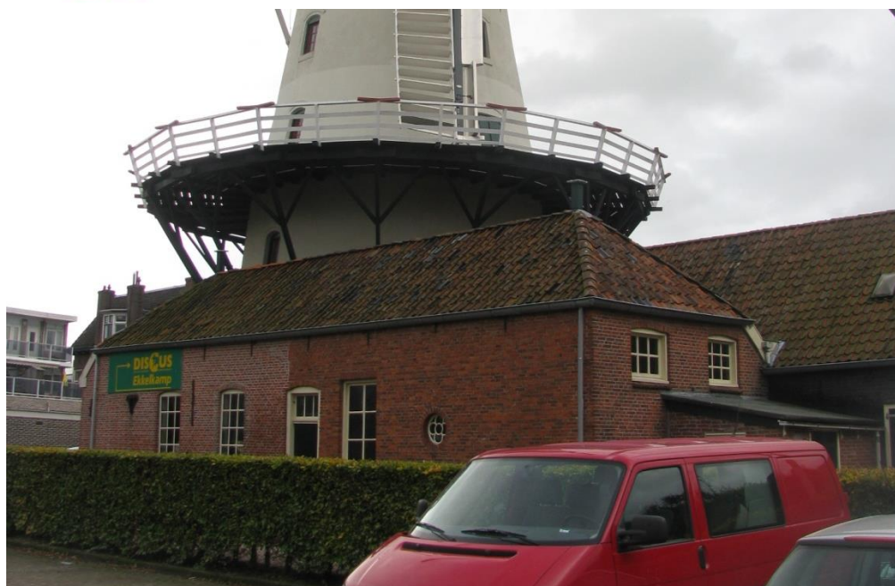
Figuur 28 Machinekamer en ketelhuis (3) van de voormalige stoomaandrijving. De schoorsteen zal ergens tussen het ronde raam en de regenpijp hebben gestaan of bij de aanbouw (7) met het lessenaarsdak.
