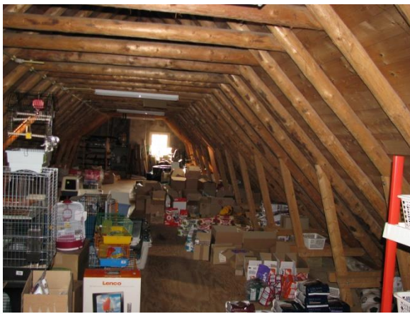
Figuur 48 Vernieuwd dak van gebouw 4.
