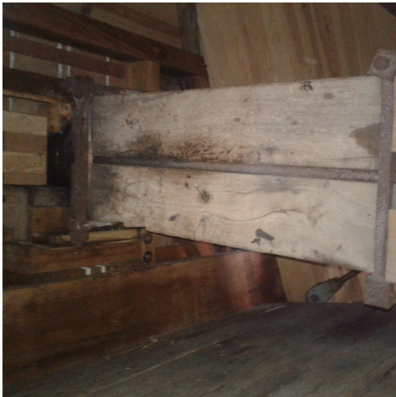
Figuur 51 De bovenas is tot de hals ingepakt door de vulstukken.
