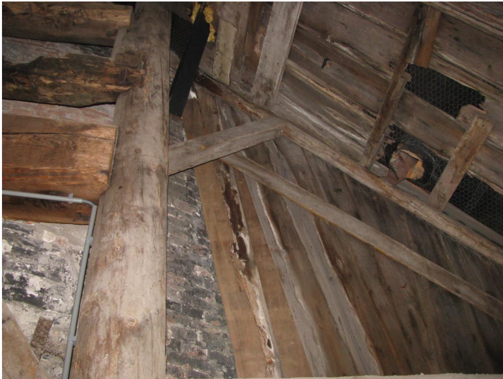
Figuur 46 De luifel aan de rechterkant (oostzijde) lijkt veel ouder. De molenmuur is hier ook nog onbehandeld en sporen van een wand zijn niet gevonden.
