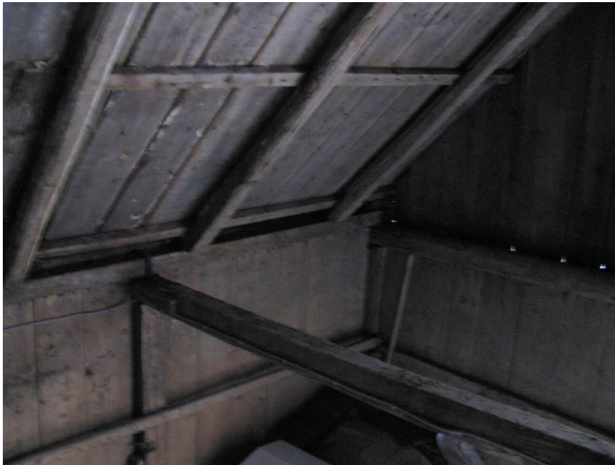
Figuur 42 Schuur bij de topgevel met oorspronkelijke buitenwanden.
