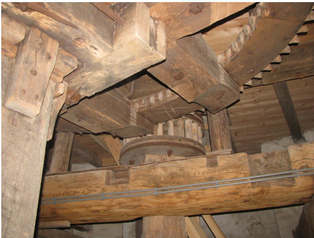
Figuur 58 Het (loze) takrad onder de maalzolder met daaronder een raamwerk dat in de (ingekorte) armen nog sporen laat zien van koppelgaten.
