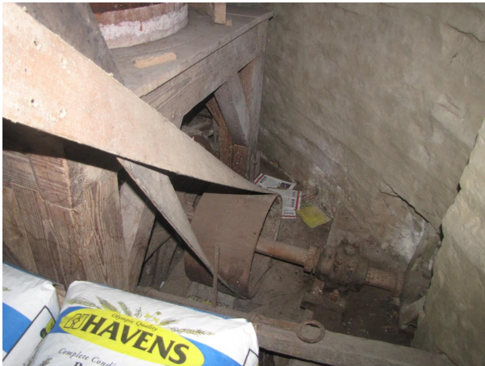
Figuur 78 Aandrijving maalstoel vanaf de hoofdas. Op de horizontale as zit een gietijzeren wiel met houten tanden dat het wiel op de steenspil aandrijft.
