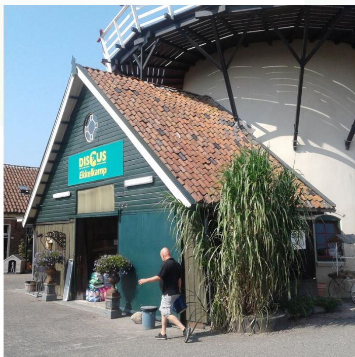
Figuur 33 De houten aanbouw (2), waarin nog een wentelas ligt.
