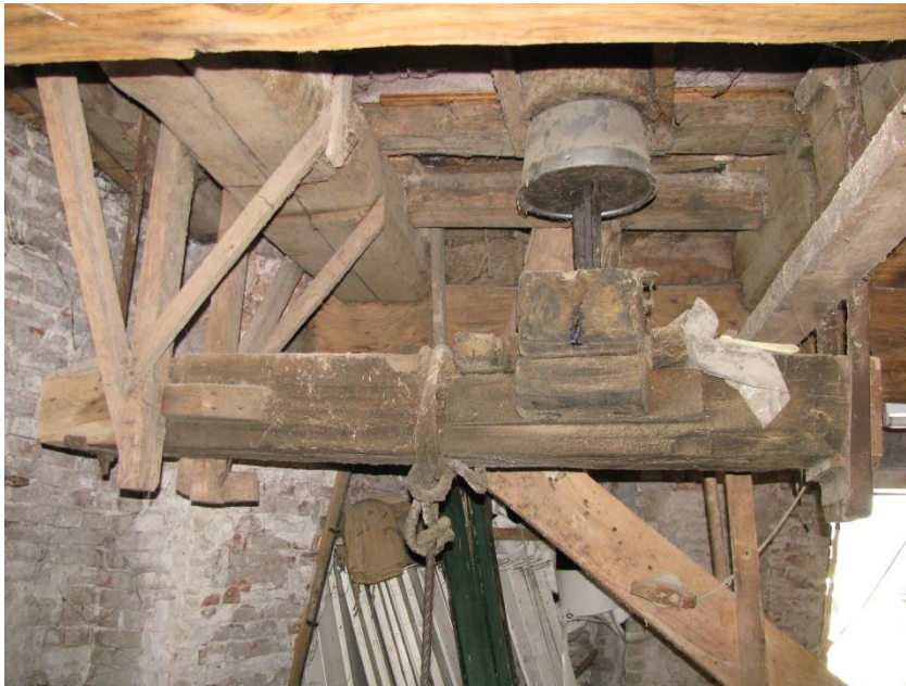
Figuur 65 Brugconstructie op de maalzolder, met op de achtergrond de maalbak.
