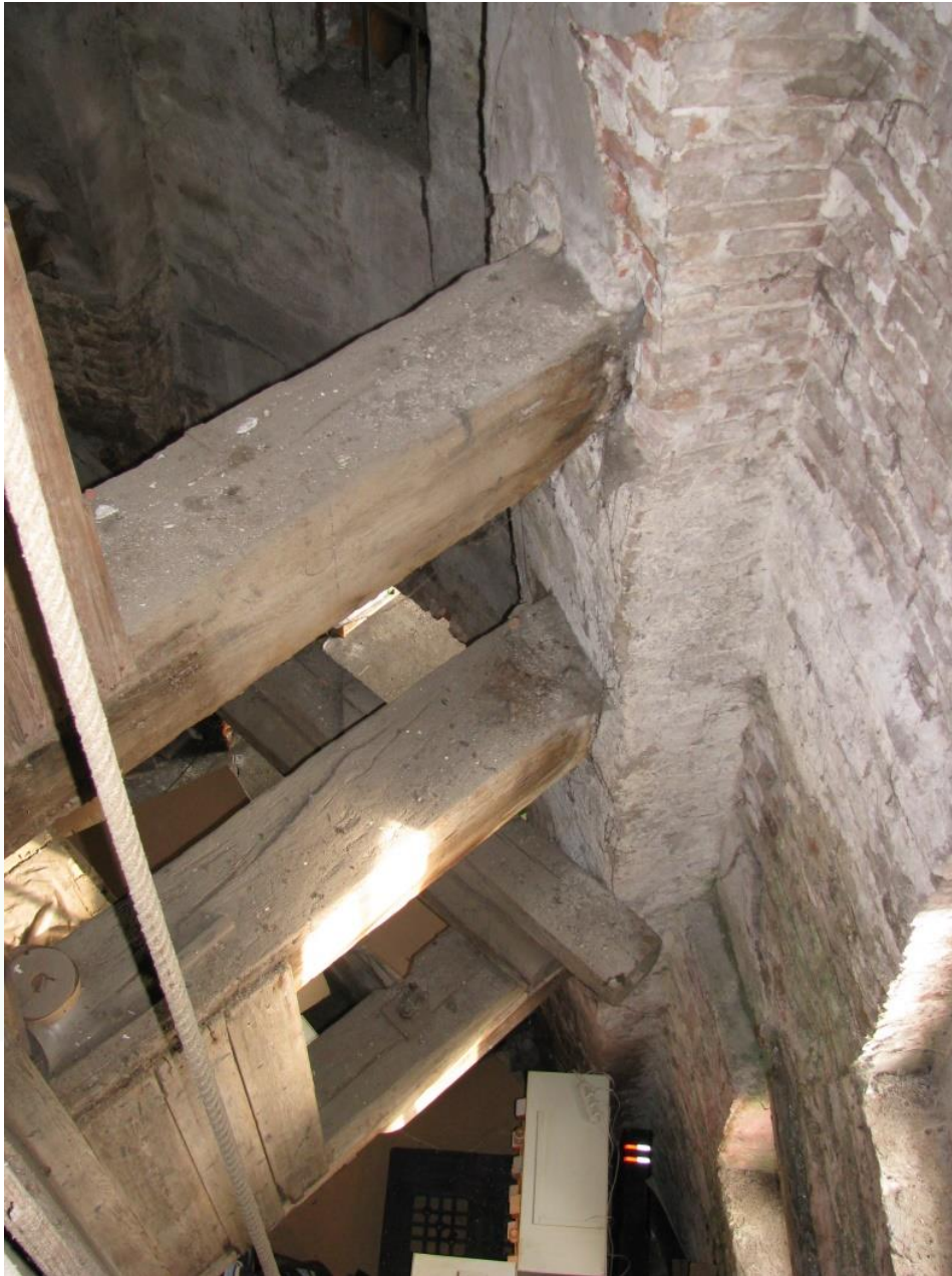
Figuur 20 Een kijkje in het luigat met zicht op de begane grond en daarboven drie balklagen.
