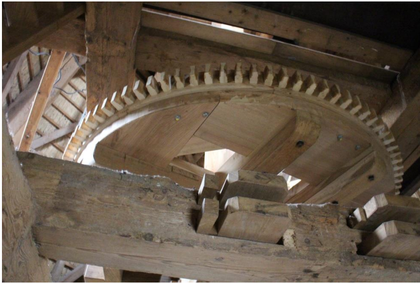
Figuur 55 In Oldebroek staan beide spillen op elkaar, waarbij de onderste spil is voorzien van een hals dat tussen de beide balken (met de dubbele pennen) is gelagerd.
