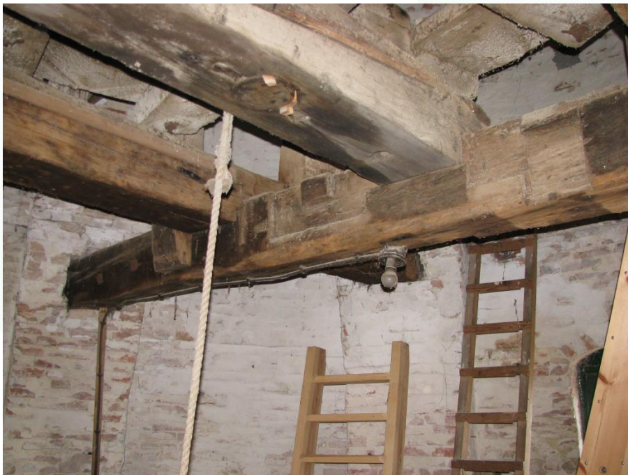
Figuur 56 Donsbalk met daarop de spil en het takrad. Aan de kepen in de onderste kruisbalk is te zien dat ook hier twee lagerbalken hebben gezeten.
