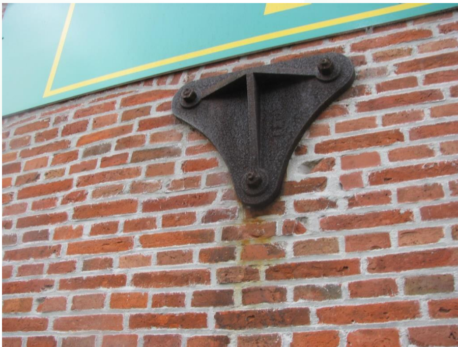
Figuur 75 Andere zijde van de muur. Hier is te zien dat er naast de lagerstoel nog een raam of deur heeft gezeten (zie ook figuur 28).
