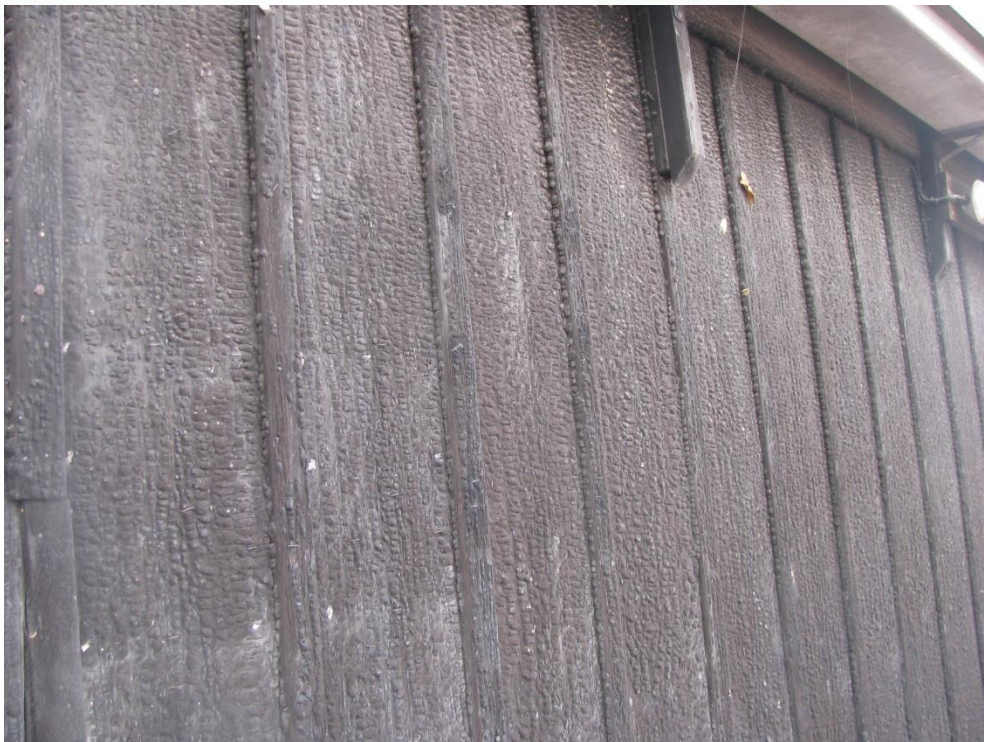
Figuur 47 Geteerde planken van de oostwand.
