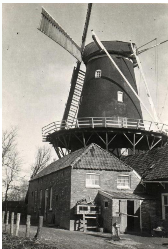
Figuur 29 Dezelfde zijde van de molen in 1943. Het gebouw heeft nog geen goten en de molen is nog zwart geteerd. (foto W.O. Bakker).
