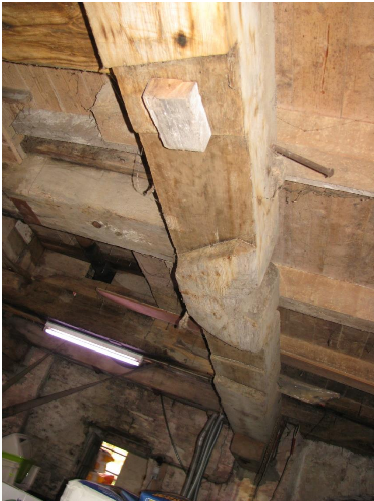
Figuur 24 De onderste legering met een veelheid aan sporen uit het verleden. In deze kepen zal het steenraam hebben gelopen van de kantstenen van het oliewerk.
