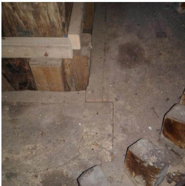
Figuur 53 bonkelaar met vulstukken rond de wiggen.
