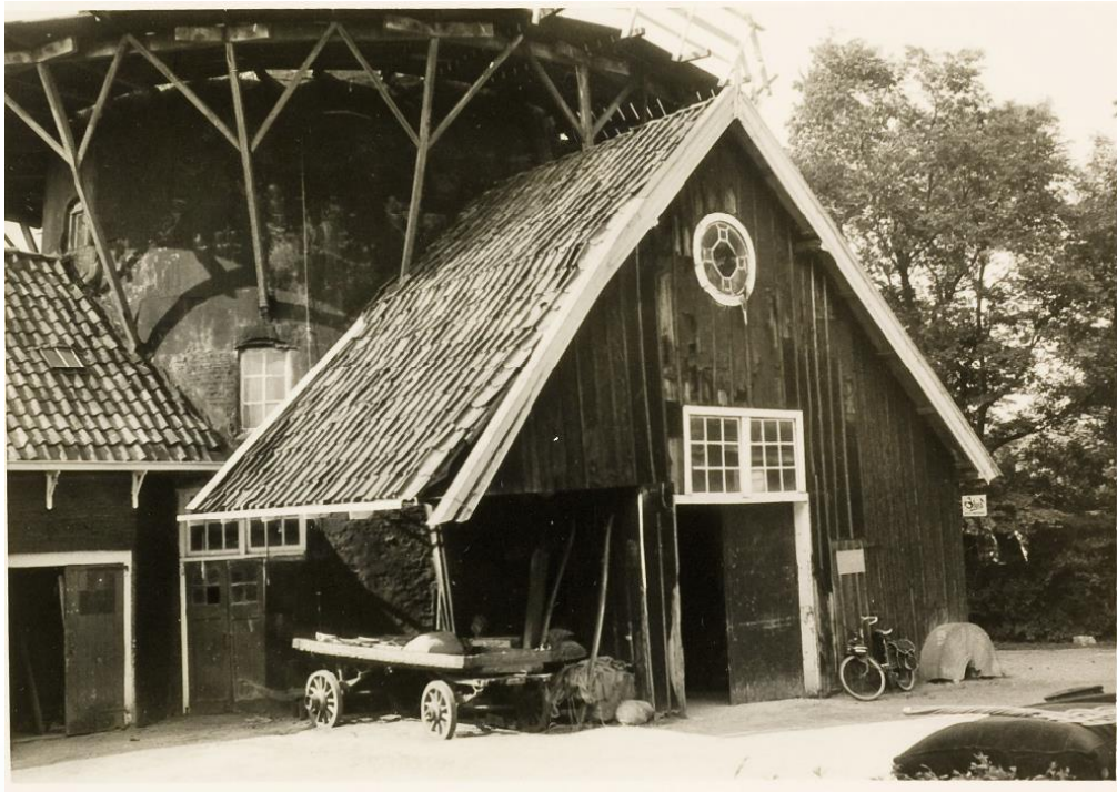
Figuur 36 De voormalige olieslagerij (gebouw 2) nog duidelijk met luifel. Aan de knik in het dak en aan de dikke spantplaten naast het ronde raam valt te zien dat het oorspronkelijke gebouw smaller was (foto W.O. Bakker 1962).
