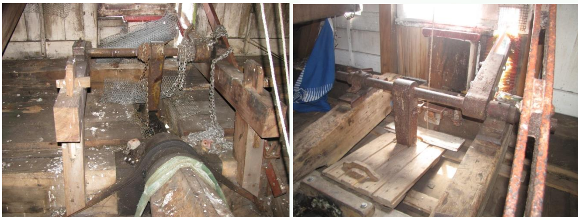
Figuur 50 Links het hefboomstelsel voor de zwichtstang op molen De Hoop, rechts die van de Fortuna te Noordhorn.
