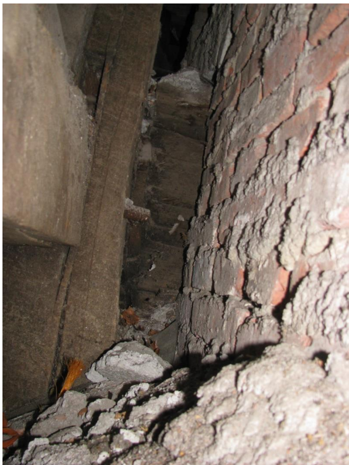
Figuur 40 Hier is te zien dat de wentelas nog doorloopt tot in de muur, maar aan de andere zijde valt er niets te zien van een gat in de muur.
