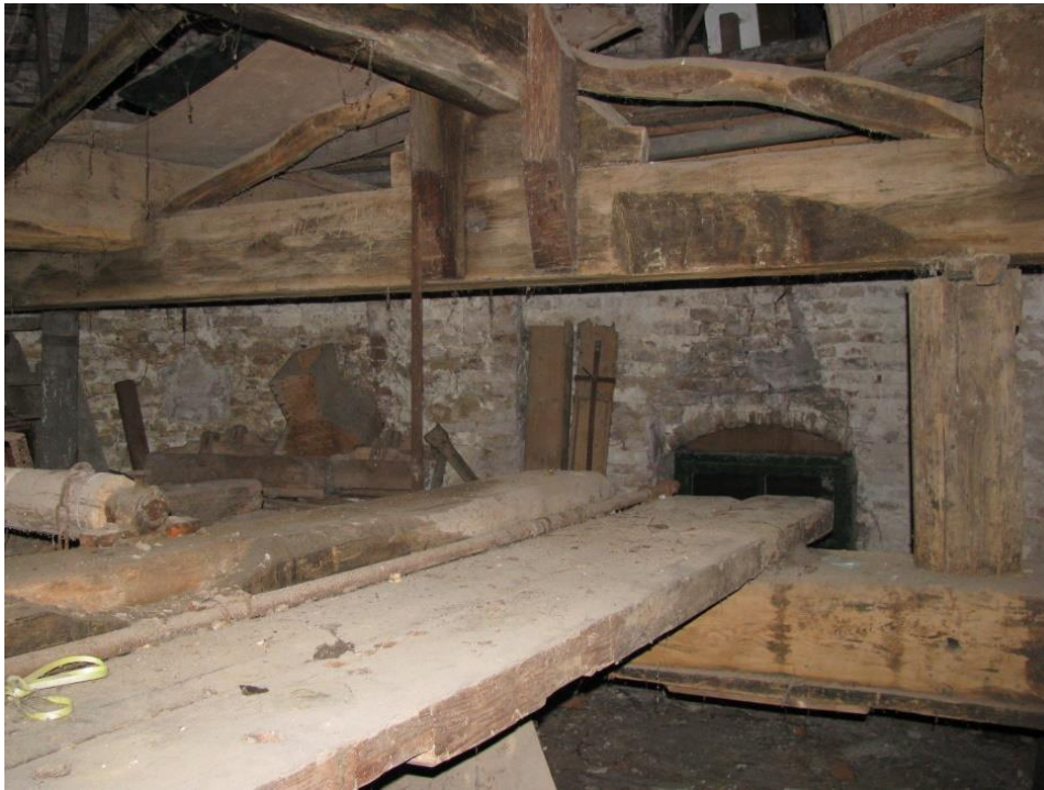
Figuur 21 De bovenste balklaag van de vorige foto draagt de dons balk voor de (thans loze) grote spil.
