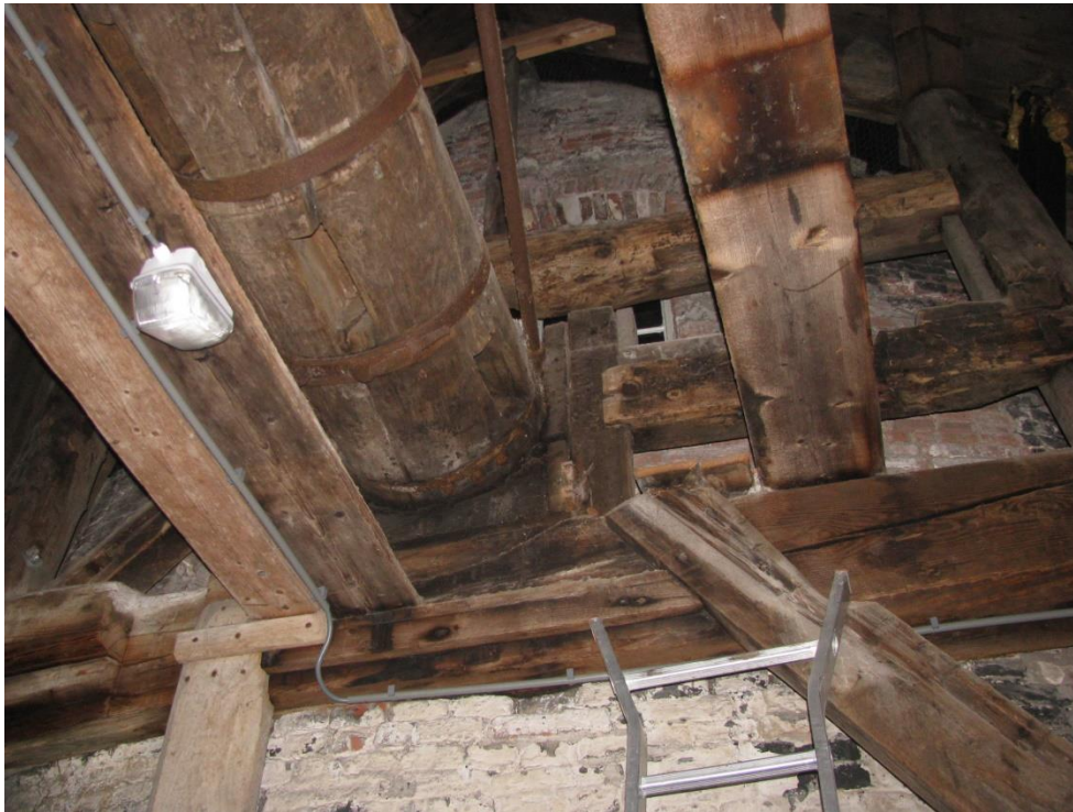
Figuur 38 Wentelas aan de zijde van de molen. Opmerkelijk is dat de molenmuren hier niet zijn geteerd.
