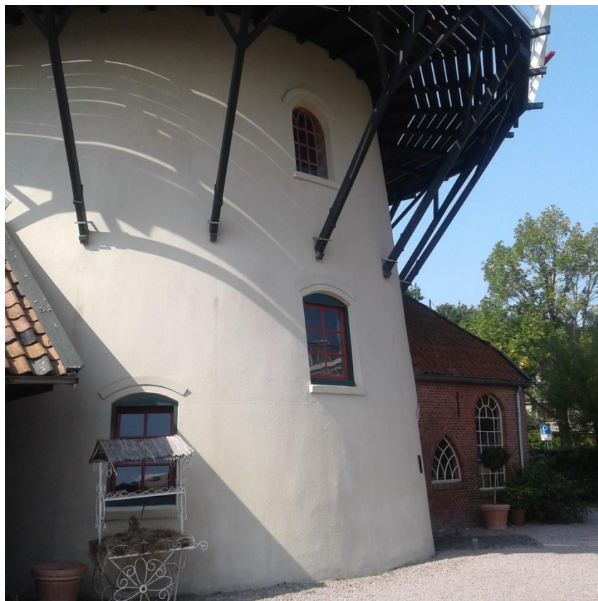
Figuur 32 Rechts de voormalige machinekamer (3) en links een stukje van gebouw 2.
