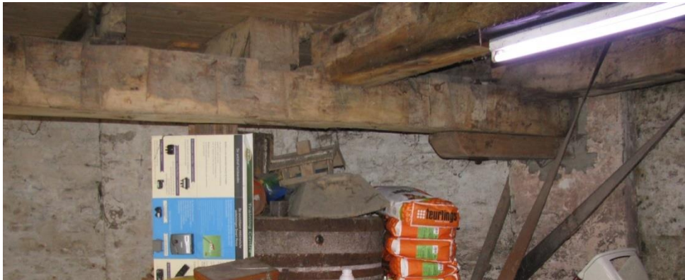
Figuur 17 Kruisbalk met sleutelstuk op de begane grond.
