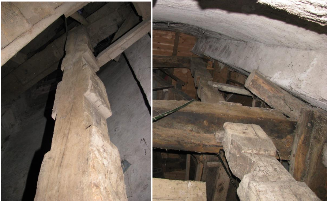
Figuur 44 Oude blokstutten van het oliewerk verwerkt tot steunbalken in de molen.
