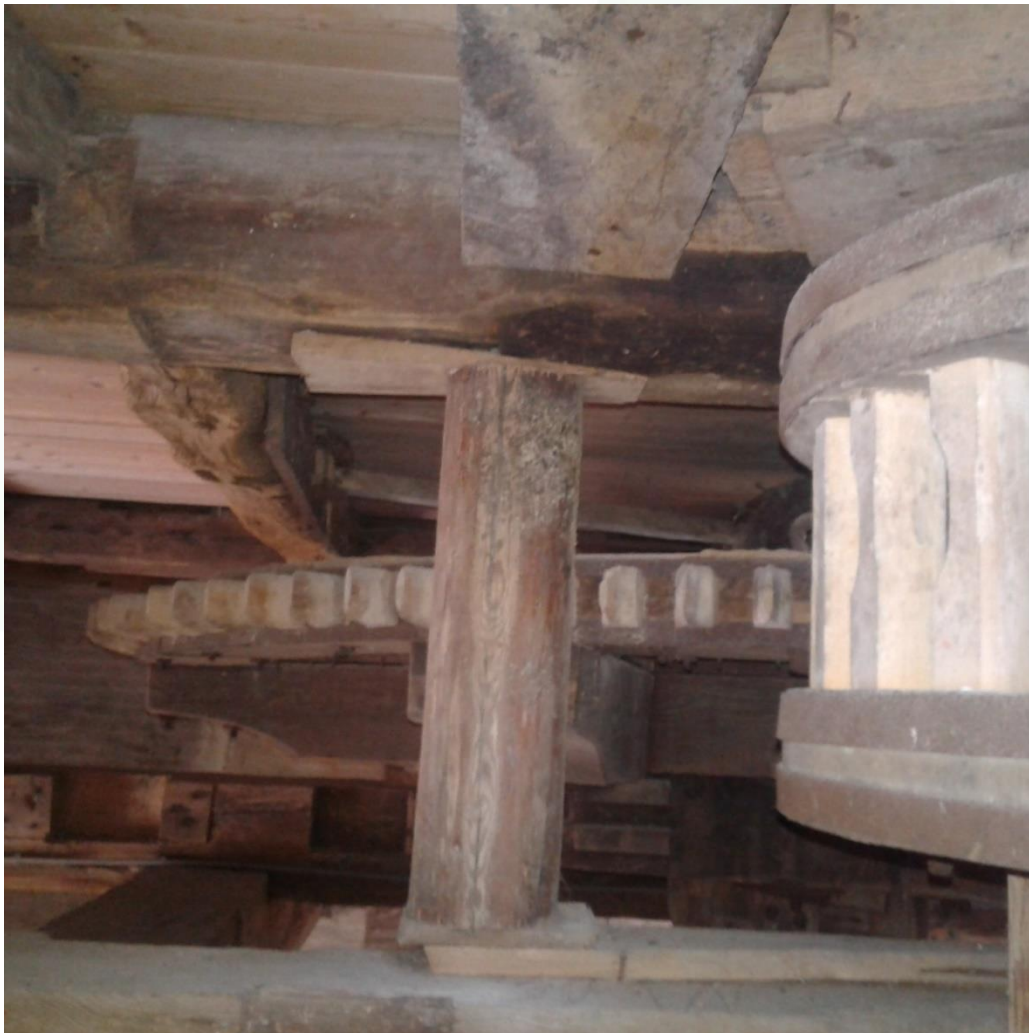
Figuur 19 Boven de stellingzolder die is afgestempeld op een laag volledige kruisbalken. Aan de kepen te zien hebben er zware balken in de kruisbalken gezeten, waarschijnlijk ten behoeve van pelstenen. Takrad en schijfloop hebben thans geen functie meer.
