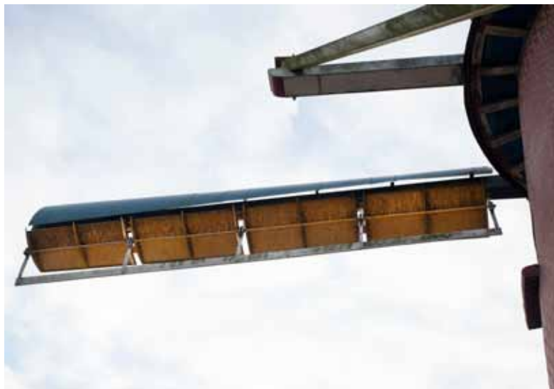
DE ROEDE IS VOORZIEN VAN HET WIEKSISTEEM VAN TEN HAVE IN COMBINATIE MET EEN FOKWIEK VAN HET SYSTEEM FAUËL. BEIDE UITVOERINGEN ZIJN VAN METAAL EN NIET ZOALS GEBRUIKELIJK VAN HOUT.
