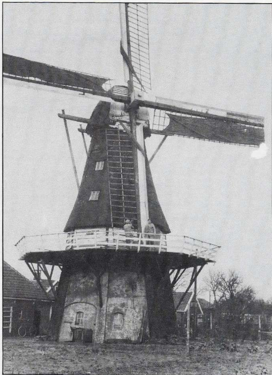
De kleine koren- en pelmolen van Oudeschip in maart 1941. Let op de houten as en er was slechts één tussenzoomlat op de verticale wieken. Staande voor de roede molenaar Jacob Bakker.
