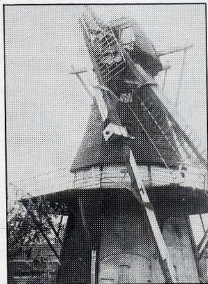
De molen van Oudeschip met het vernielde wiekenkruis, gefotografeerd één dag na het ongeluk, op 19 oktober 1941. Foto: W.O. Bakker.
