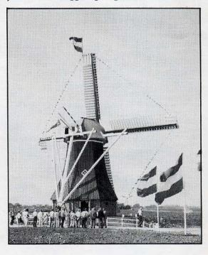
werd een dergelijk sein aangegeven door middel van een lantaren in een hoge mast. Wanneer er geen wind was, lag het bedrijf stil, vandaar dat in 1907 de molen werd uitgerust met een stoommachine als hulpkracht. In 1926 is de stoommachine vervangen door een electromotor, welke één van de beide vijzels aandreef.
