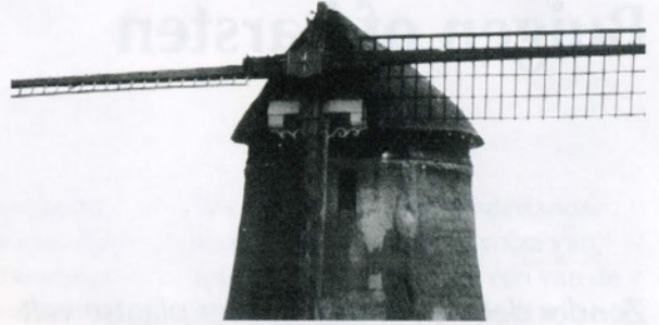
Afb. 1b: Haspelwiekenkruis voor een ijzeren as op de binnenkruier te Ouddorp (N.H.), 1955 Collectie C.E. v.d. Horst, Scheemda
