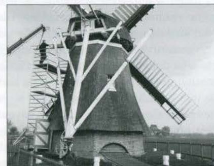
De lange schoren hangen tijdelijk met takels aan de korte spruit
