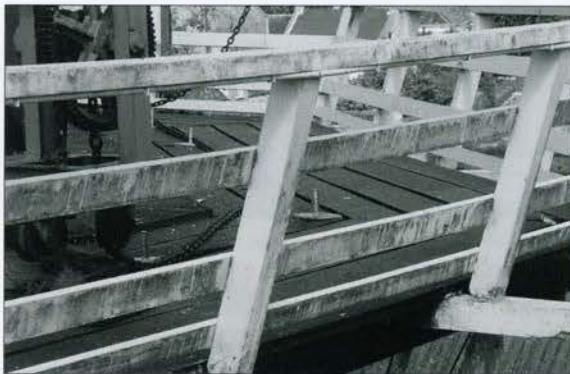
Het schoonmaken van geschilderd houtwerk hoort bij het reguliere bijhouden van de molen; niet alleen vlak voordat het houtwerk zal worden geschilderd!
