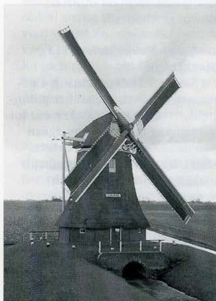
Poldermolen Goliath te Uithuizermeeden, gebouwd in 1897. Dit is de noordelijkste molen van de provincie Groningen en heeft ter versteviging van het achtkant extra veldkruizen wegens de ligging achter de zeedijk. De molen is uitgerust met 2 vijzels, waarvan er destijds één door een elektromotor werd aangedreven. De molen had voor de restauratie zelfzwinging, maar is uit bezuiniging niet weer aangebracht. (foto: Peter Buitter)
