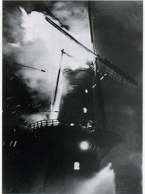
Korenmolen De Noord in het hartje van Rotterdam. De molen overleefde de bombardementen van 1940. Als enige bouwwerk bleef hij staan tussen puin en ruïnes. De molen wist door vonken malen te overleven. Op 27 juni 1954, veertien jaar na het bombardement ging de molen toch nog in vlammen op. Deze foto werd na de brand als prentbriefkaart verkocht ten bate van wederopbouw van de molen. Het heeft niet zo mogen zijn. foto: D.J.H. van der Ven, verzameling C. E. van der Horst
