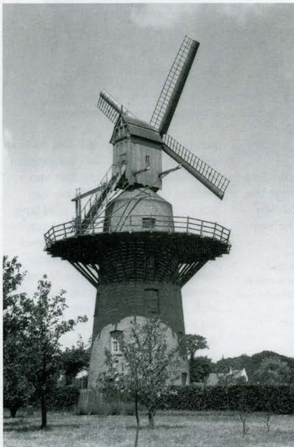
In 1933 liet molendeskundige Alfred Ronse deze kleine molen te Gistel (W.Vl.) bouwen. Het is een standermolen op een hoge stenen romp. In 1977 werd het molentje wettelijk beschermd. Toch mocht dat niet baten. Nu staat alleen de romp er nog.
