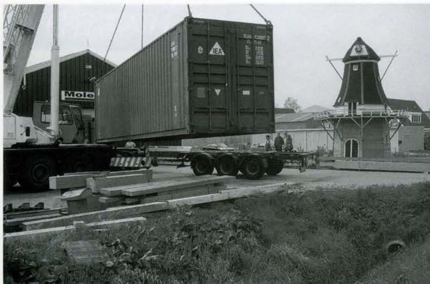
Begin mei gingen de eerste twee van de in totaal vier benodigde containers vanuit Heiligerlee op transport naar Fulton. Het molentje rechts op de foto is de befaamde 1:3 replica die momenteel gerestaureerd wordt.
