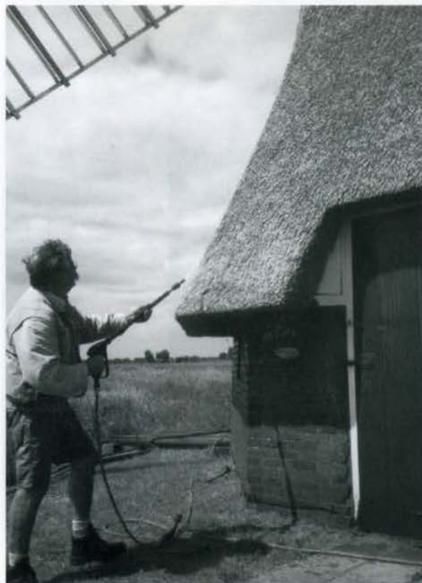
Brandvertragend middel spuiten op De Noordermolen Foto: Ties Kalk
