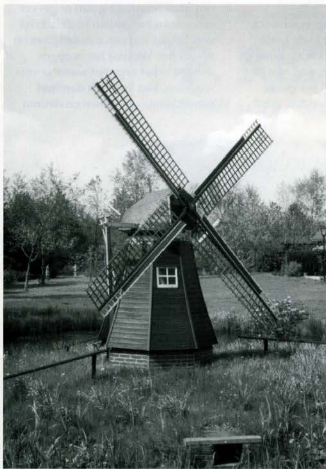
Het fraaie molenmodel met een gevucht van \pm 9 m van J.J. Fluks bij zijn woning te Woudbloem tussen Scharmer en Slochteren. De molen is kruikbaar; de wieken en de vijzel zijn elektrisch aangedreven: er is te veel windbelemmering!
