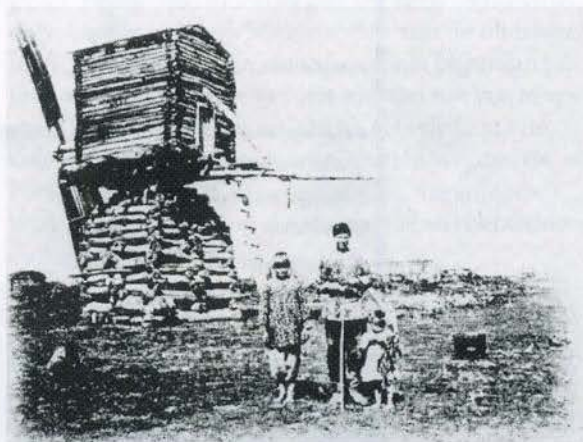
Omgekeerde standaardmolen bij Omsk (ongeveer 1905) (Uit: International Molinology , juli 1999, nr. 58, p. 24; collectie P.A.M. v.d. Berg te Gouda)
