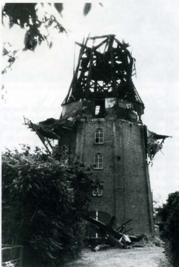
De door de brand zwaar beschadigde Entreprise , Kolham
