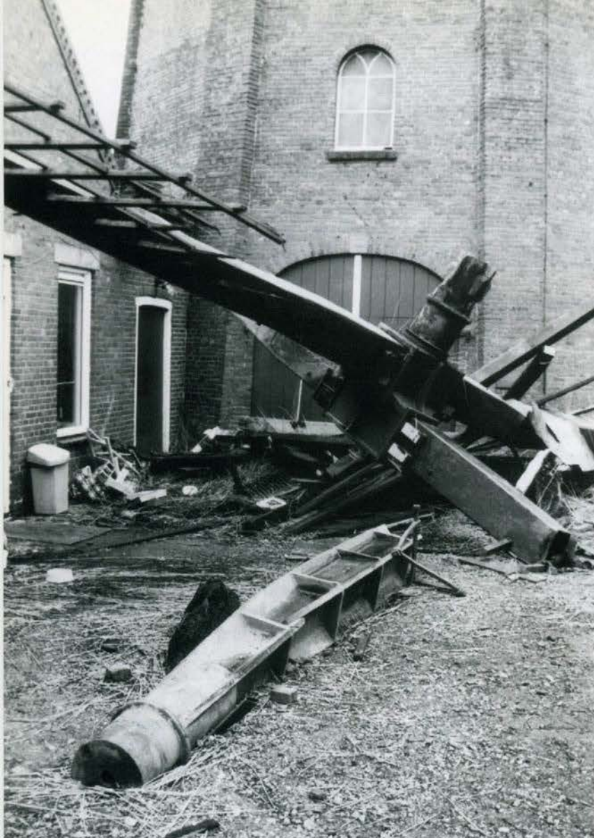
De ravage voor de Entreprise in Kolham, met de in 3 stukken gebroken bovenas
