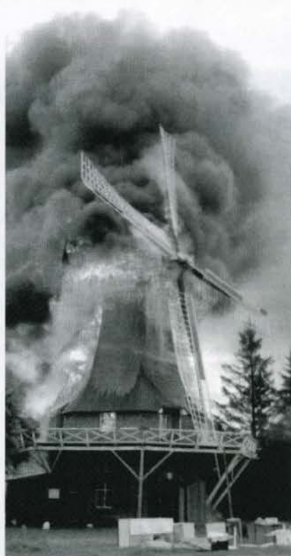
Durch die Mühlekonstruktion ist der Sogeffekt zu stark, wie dieser Bild auch beweist. Die Johanni-Mühle stürzte vollkommen in sich zusammen.
