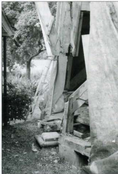
Niemand zal het ontkennen: deze achtkantstijl was echt aan herstel toe!
