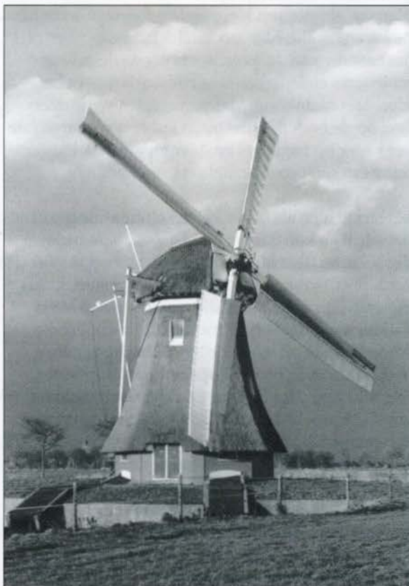
De Krimstermolen malend met aluminium kleppen; zo op het oog geen verschil met TR-kleppen (november 1999)
