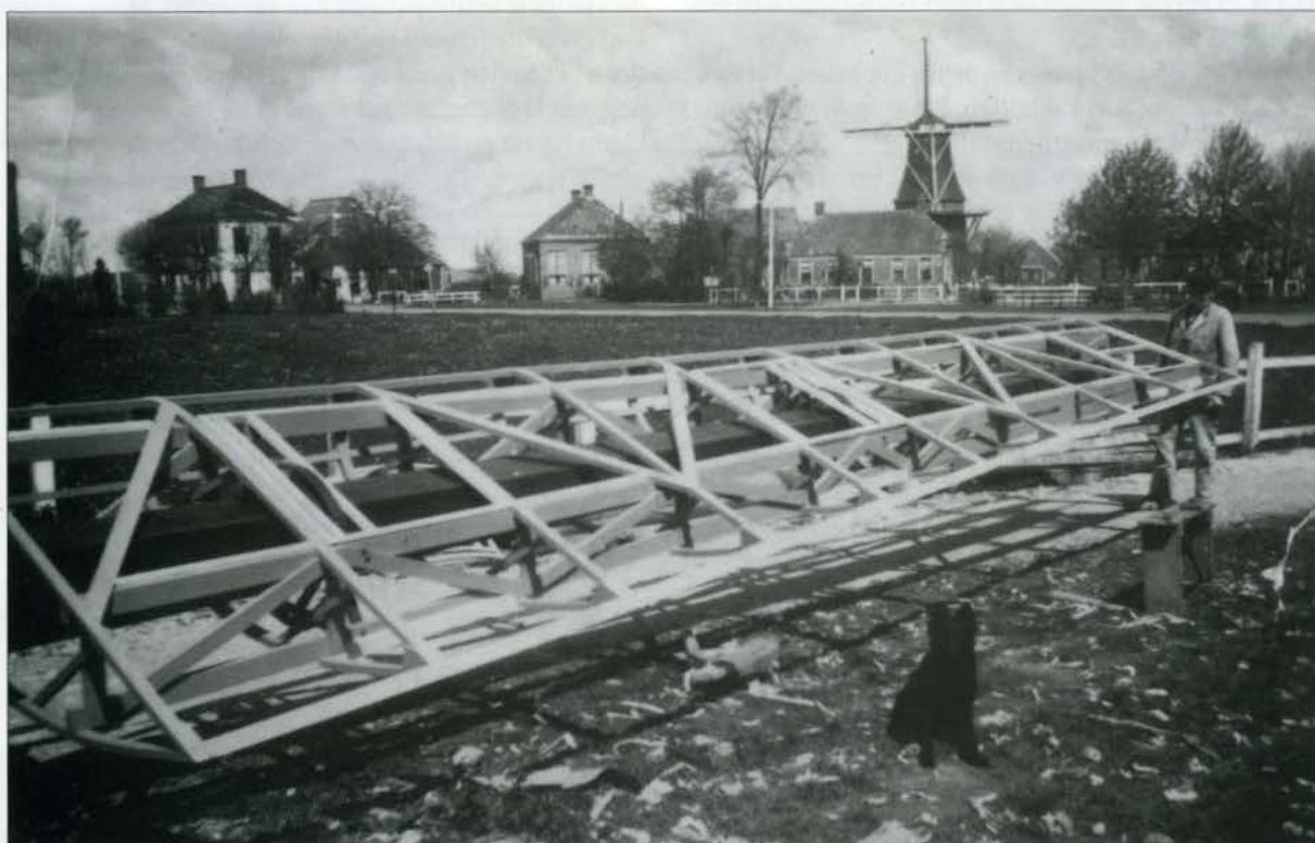
Afb. 3 De opbouw van de kleppen met als hoofdonderdelen twee langsliggers, ieder opgebouwd uit twee lengteprofielen die onderling verbonden zijn door dwarshouten
