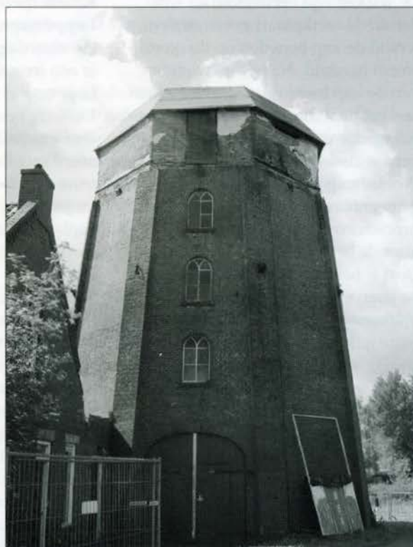
Onderbouw van de Entreprise
