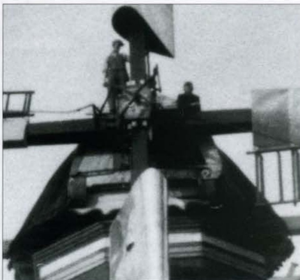
Afb. 6 Detailvergroting van de afbeelding op het omslag, hefbomen, compensatieveren, trek- en duwstangen om de klep om de roeden te kunnen draaien
