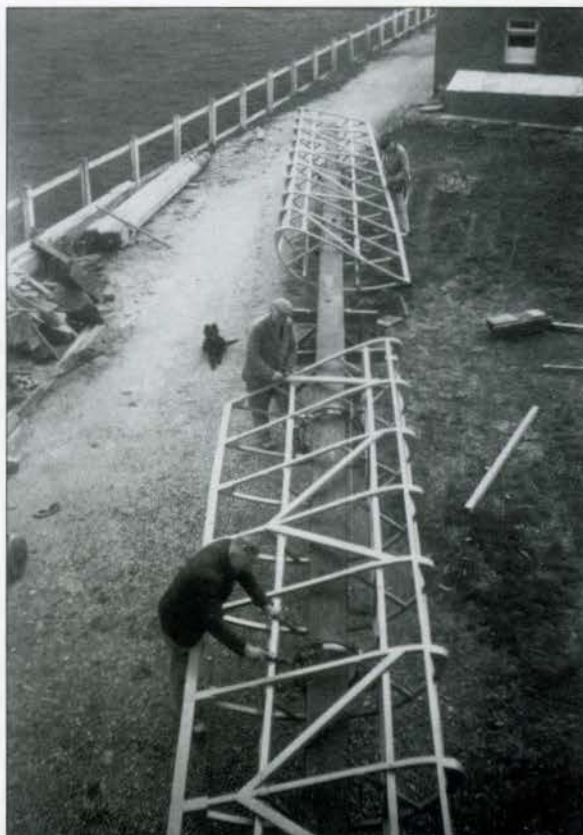
Afb. 4 De klepconstructie is doormiddel van een drietal lagers draaibaar om de vierkante roede. Duidelijk zijn de twee stellen concentrisch geplaatste ringen zichtbaar
