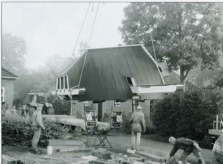
De kap op weg van de bouwplaats naar de hijsplaats Foto: Gerhard Visker, Westerwijtwerd
