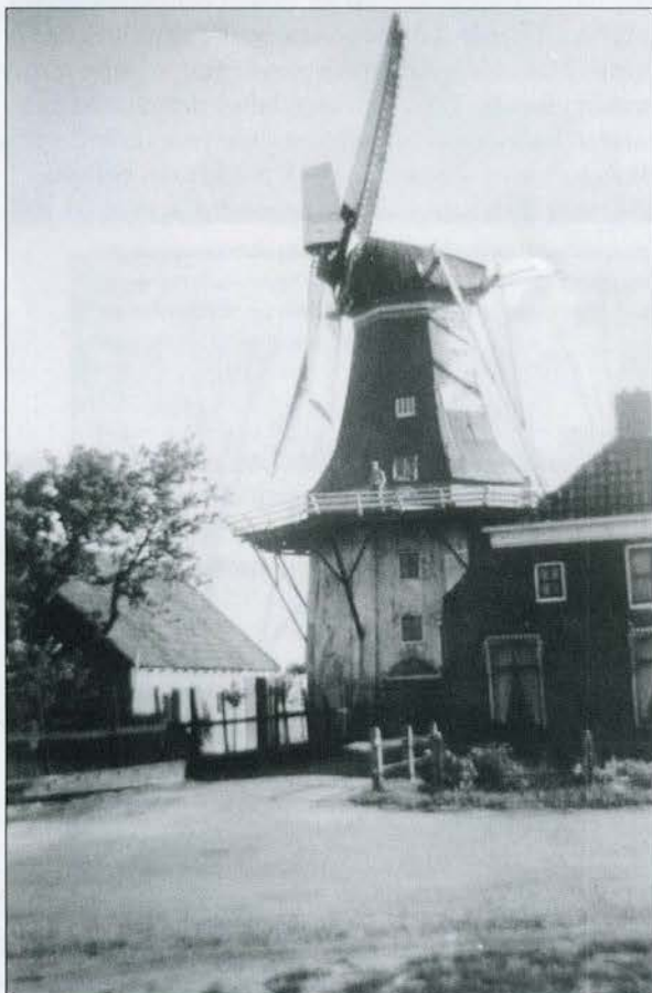
Afb. 2: De molen met de draaibare vleugels op de buitenroede. Links op de voorgrond is de oude roede zichtbaar.
