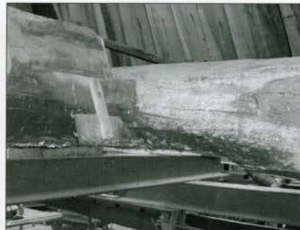
Aangetast linkervoeghout Foto: D.J. v.d. Zee, Groningen
