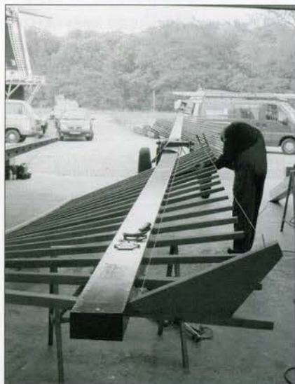
Voorzoom van de binnenroe uitlijnen Foto: D.J. v.d. Zee, Groningen
