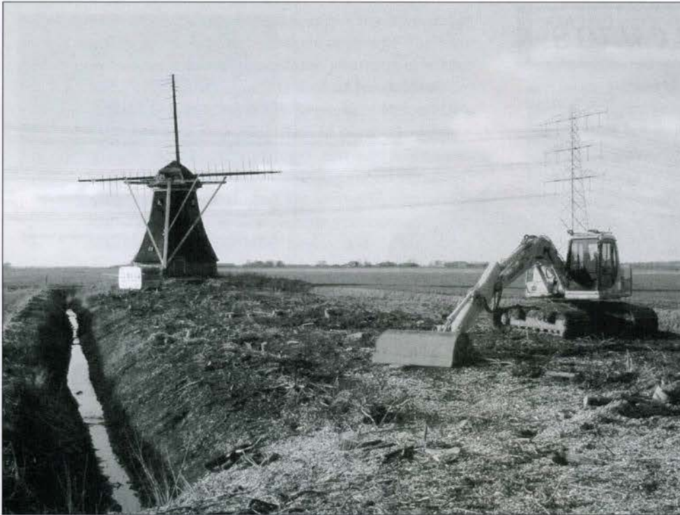
Begin van de werkzaamheden aan De Noordermolen (21-01-'04)
