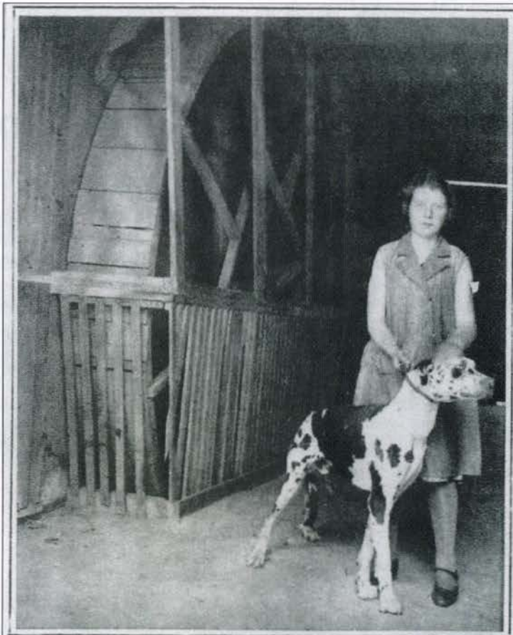
Het ouderwetsche en het moderne gaan op een zonderlinge wijze samen bij den heer E. Lieuws, stel- en wagenmaker te Diepswal bij Leek. Hij laat n.l. zijn moderne schaaf- en zaagmachines drijven door de verouderde tredmolen en niet door electriciteit. De „motor” is hier de stevige Duitsche dog, die hier in de schuur naast het groote wiel staat, waarin hij letterlijk een „hondenleven” heeft. Als zijn plaats vacant komt zullen er weinig sollicitanten komen voor deze allesbehalve benijdenswaardige positie...
