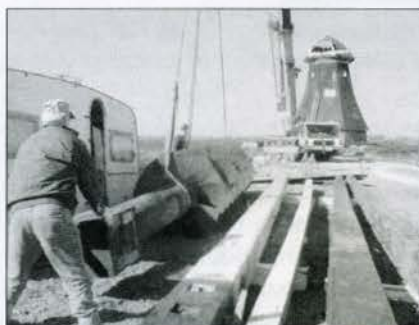
De restauratie is begonnen met het uitnemen van oude onderdelen.
