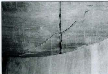
De scheur in de vijzelbalk Foto: Molenmakersbedrijf Molema, Heiligerlee
