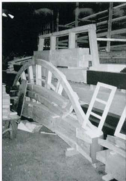
Bouwpakket van de kap Foto: J.-J. Sterenberg, Bedum
