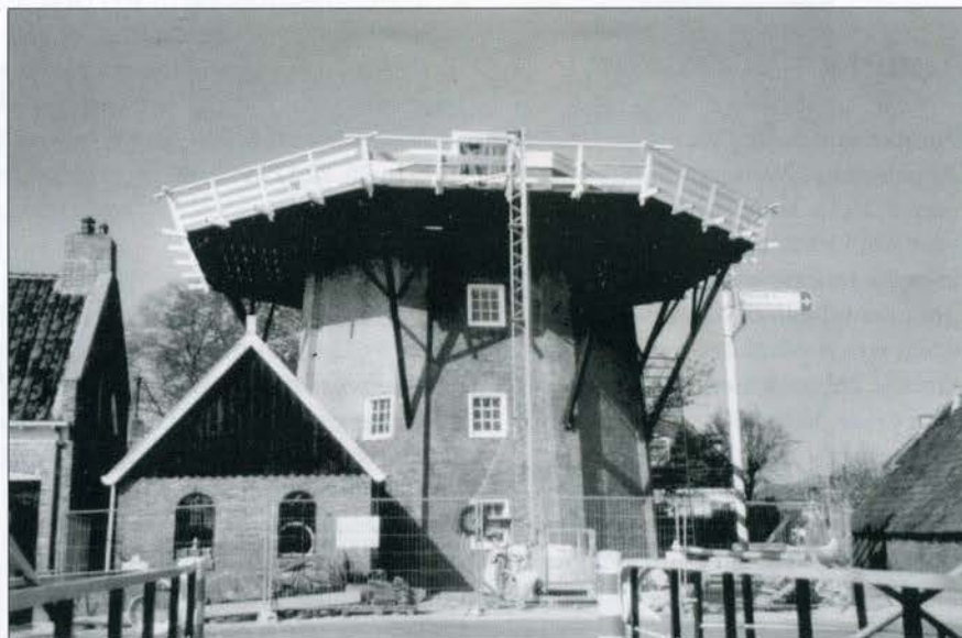
Het voegwerk aan de romp Hunsingo vordert Foto: J.-J. Sterenberg, Bedum
