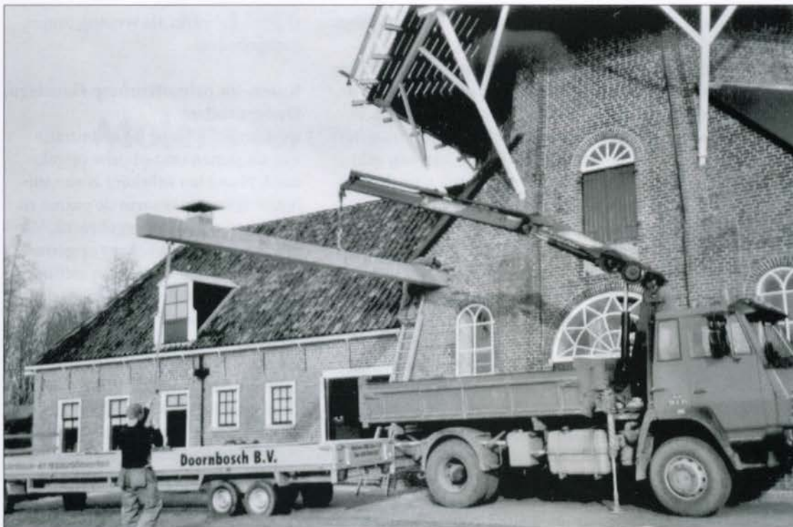
Plaatsing van de nieuwe steunbalk Foto: A. Doornbos, Roderwolde
