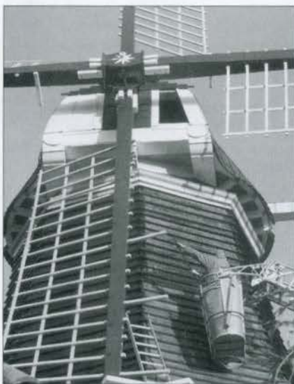
Gerben Vaags teert de romp Foto: A. Nibbelink (Fa. Vaags Molenwerken, Aalten)
