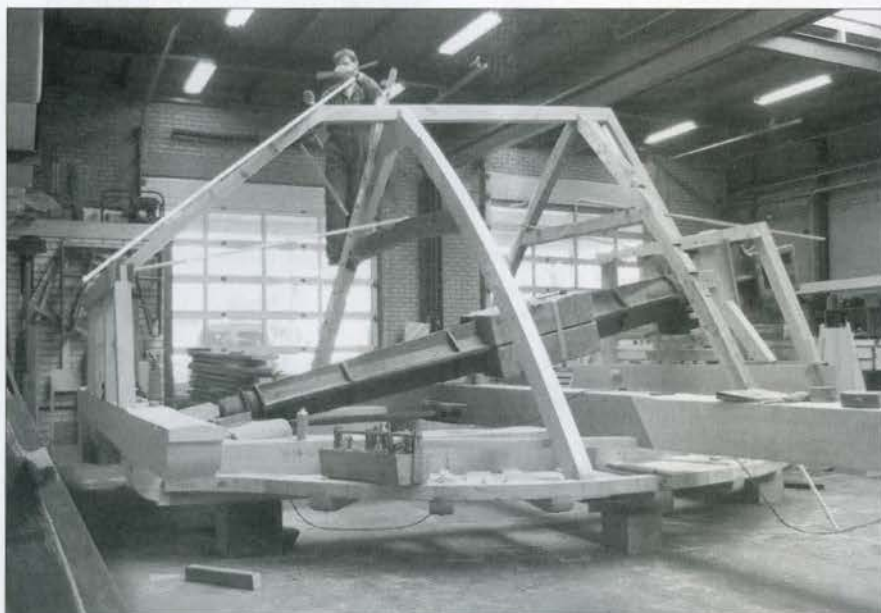
A. Nibbelink werkt aan de spanten van de kap van De Korenschoof Foto: Vaags Molenwerken, Aalten
