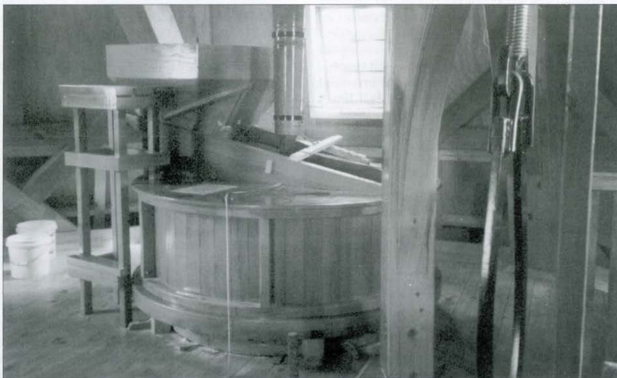
Maalzolder van De Molen (alles in de vernis!)
