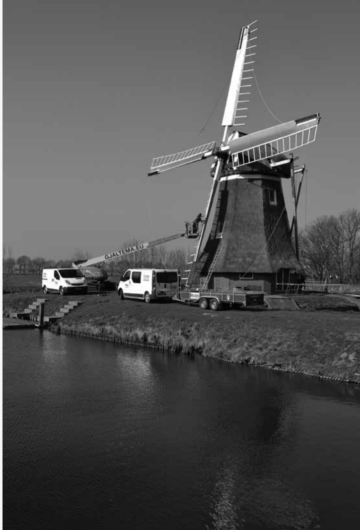
HOOGWERKER TEN BATE VAN WERKZAAMHEDEN AAN HET GEVLUCHT VAN DE KRIMSTERMOLEN (FOTO ANNE WIERINGA)
