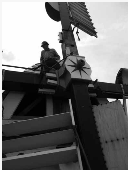
MEDEWERKER MOLENMAKER DUNNING TIJDENS WERKZAAMHEDEN DOORHALEN VAN DE ROEDEN (FOTO ANNE WIERINGA)
