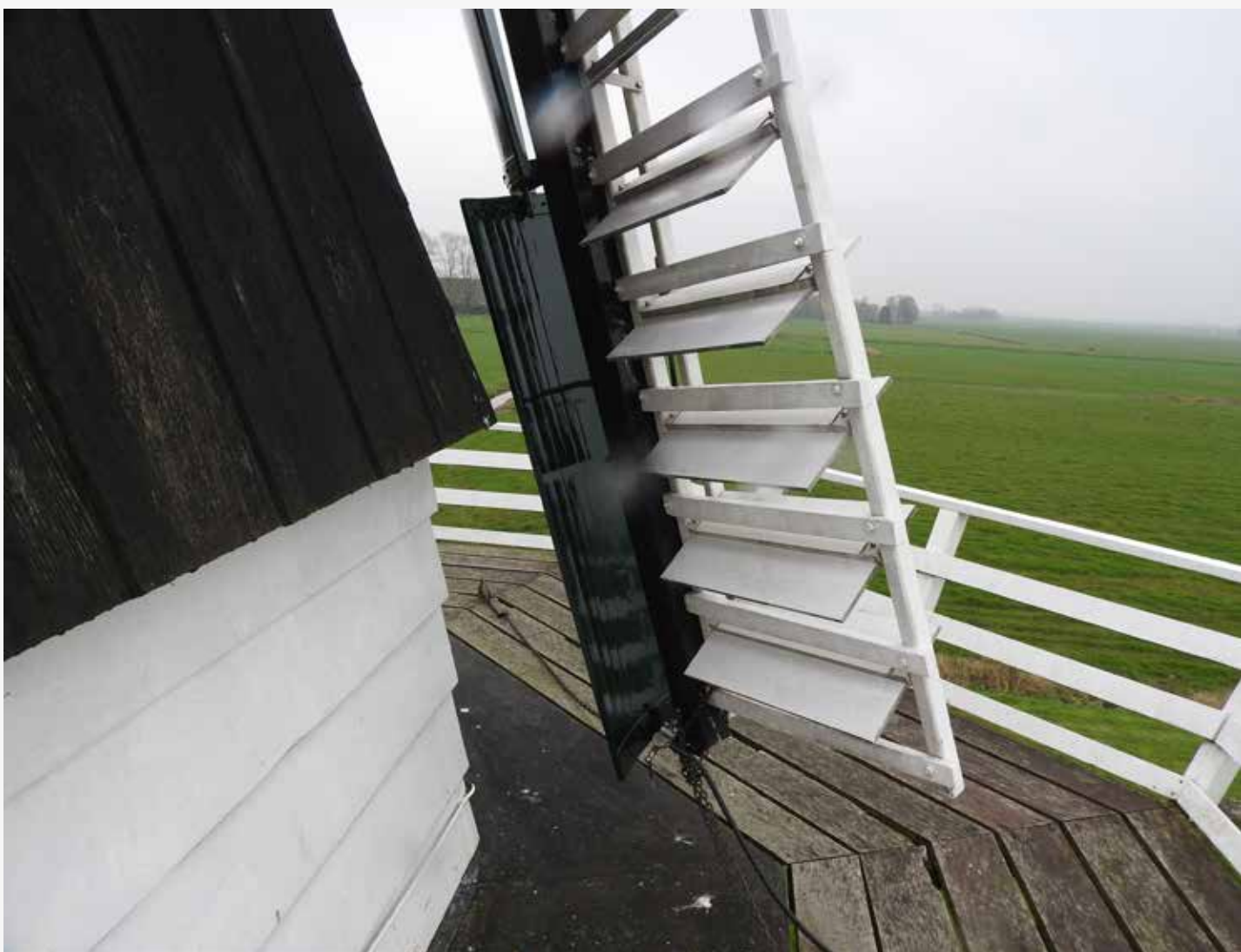
Koren- en houtzaagmolen Bovenrijge (020) te Ten Boer De fokwieken zijn hersteld
