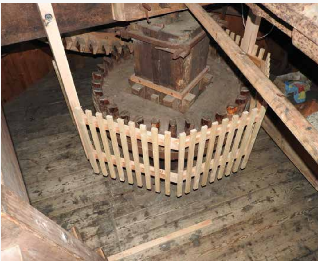
Koren- en pelmolen Stormvogel (070) te Loppersum Omheining bovenbonkelaar ten bate van de veiligheid
