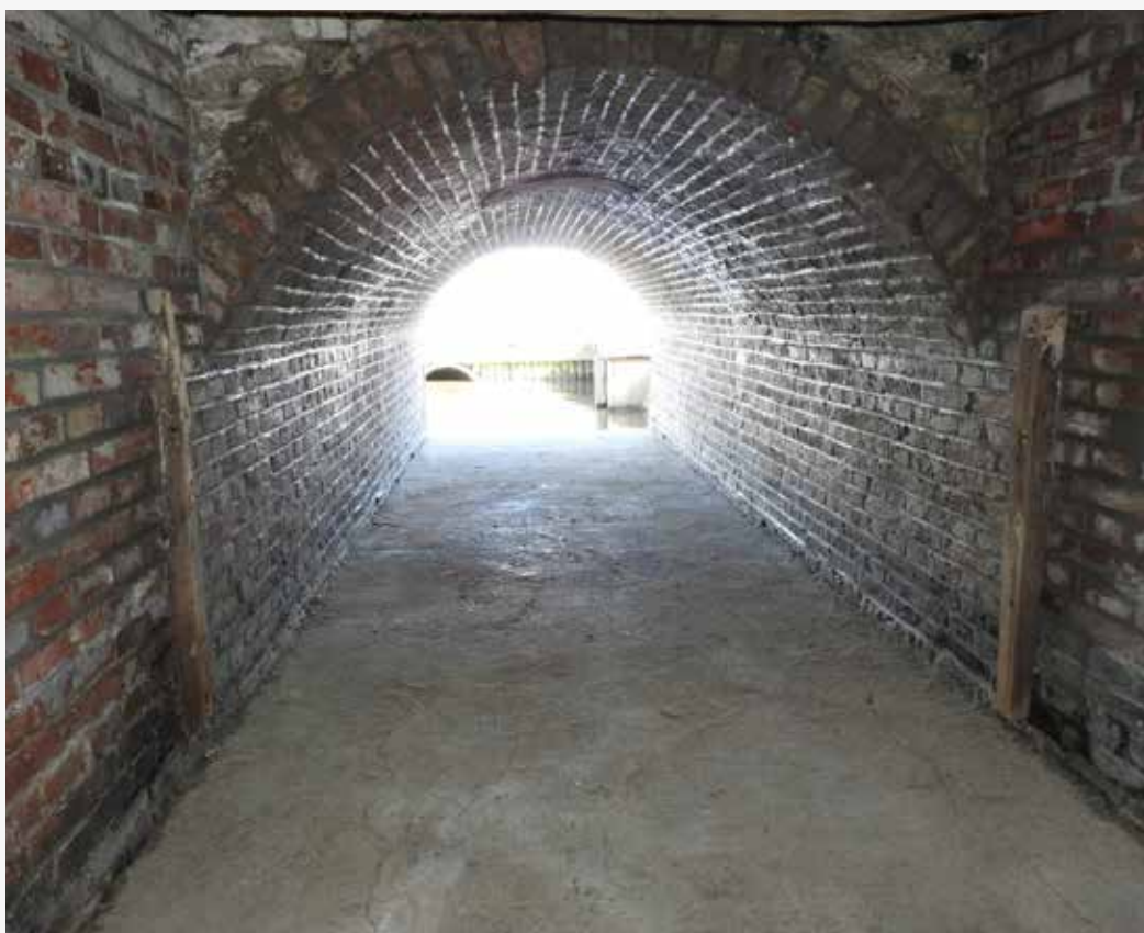
Poldermolen Koningslaagte (031) te Zuidwolde. Metselwerk waterloop hersteld
