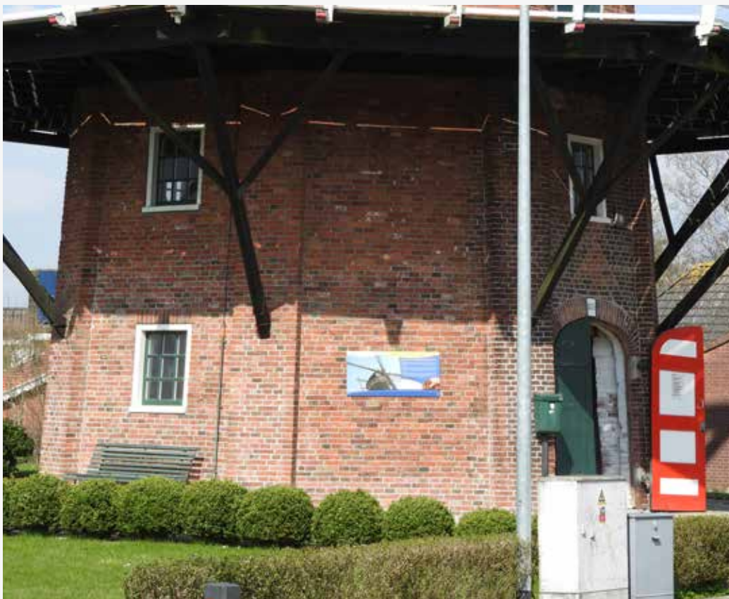
Korenmolen Germania (025) te Thesinge Metselwerk onderbouw hersteld
