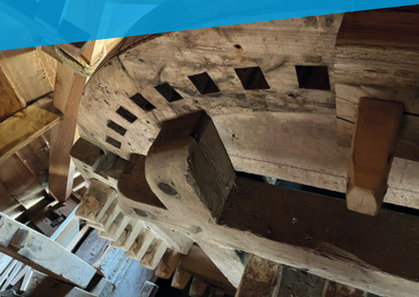
Windlust, bovenwiel en vang. Foto: MsMOG
