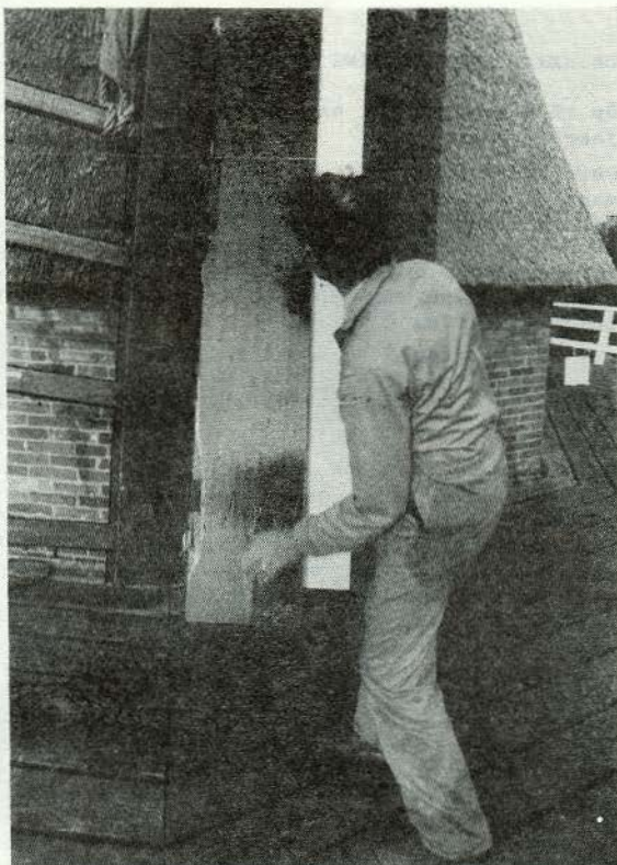
Er wordt gedemonstreerd hoe de windbor-den verwijderd kunnen worden (Thesinge)
