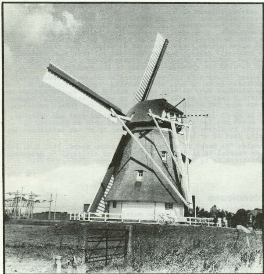
Korenmolen - grondzeiler "De Hoop" in Kropswolde. Men ziet, dat deze molen is uitgerust met Fauël-wieken en zelfzwichting.
