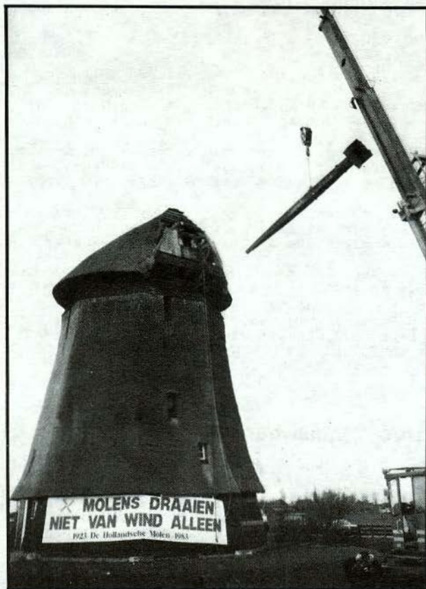
De oude - ruim 4 ton wegende - bovenas wordt uit de kap van Molen K. gelicht.
