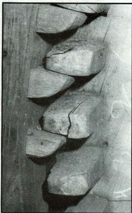
Door het verzakken van de bovenas oefent zich een geweldige druk uit op de pal, zodat een kam van het bovenwiel gebroken is.
