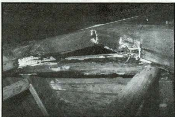
Het vermolmd veldkruis boven de westelijke stellingdeur en de vloer van de steenzolder wordt gestut.
