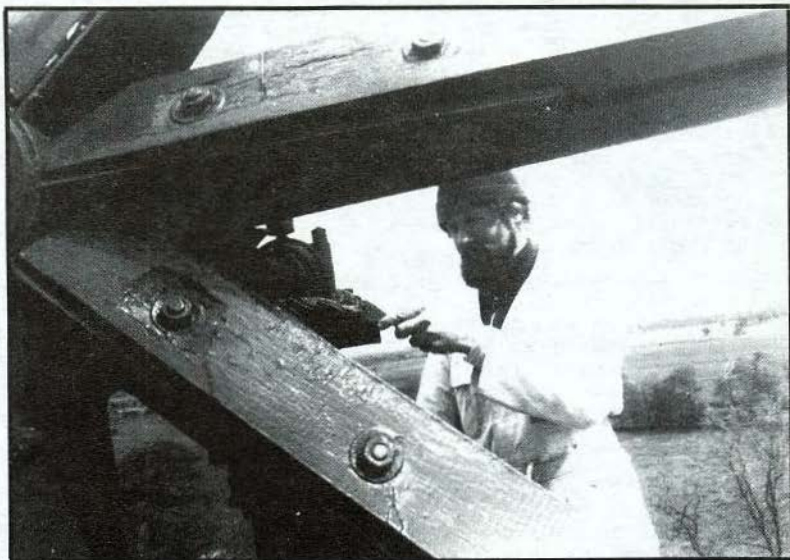
Hoogtevrees? Nee hoor, gewóón doen. Smeerwerkzaamheden aan de windroos.
