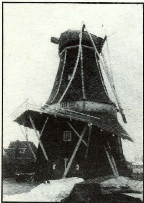
90. De "Aeolus" te Oldehove met de ingestorte stelling.
