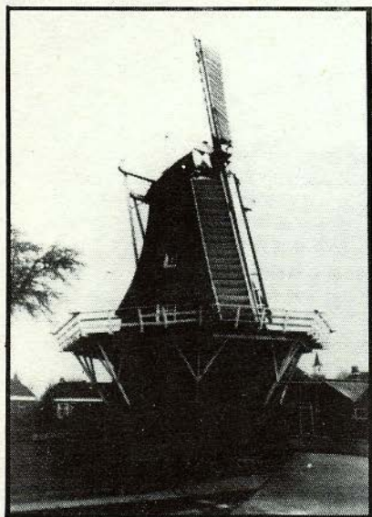
22. De "Windlust" te Overschild met één roede met zelfwichting.
