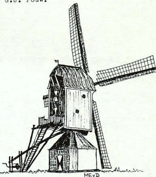
De standerdmolen te Volkel. Bouwjaar 1738, vlucht 26 meter.
