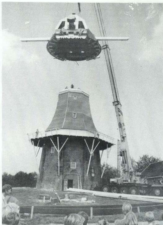
Even een terugblik op de restauratie, toen op 21 september 1983 de herstelde kap op de molen "Eva" werd gehesen.
