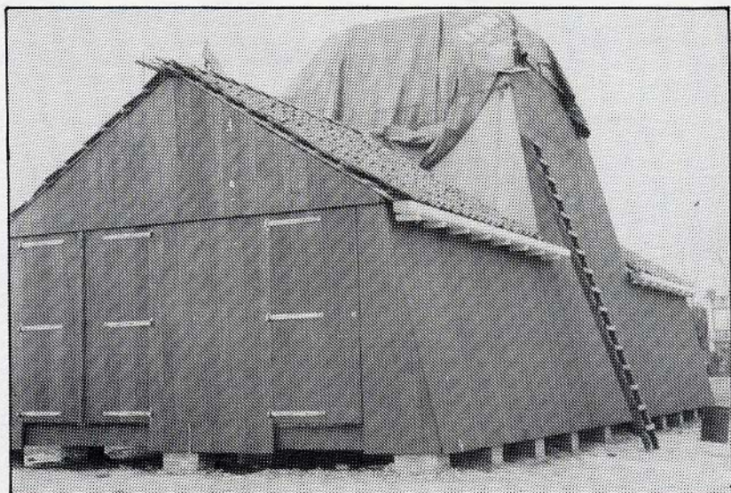
De zaagschuren met het ondervierkant van de molen Bovenrijge te Ten Boer zijn bijna klaar. Alleen moeten de ramen e.d. nog ingezet worden.
