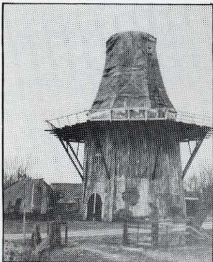
De molen van Wetsinge, nu zonder kap, staat en roeden. De nieuwe stelling nadert zijn voltooiing. Foto 25 april 1986.
