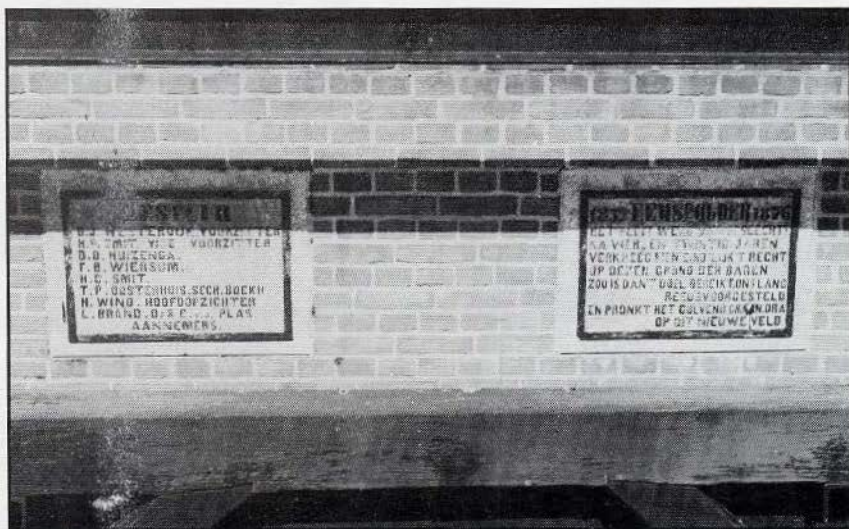
De beide gedenksteden op de muur van de duikersluis bij de molen. De donkere streep boven is de schaduw van een balk.
