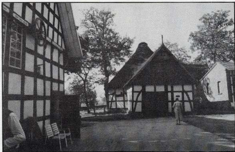
In het midden de achthoekige rosmolen (een koren- en vlasbeukmolen) van Oberbauerschaft uit 1797. Ook kon men met deze molen een dorsmachine aandrijven; aan de gevel van de boerderij links ziet men nog het aandrijftrad.
