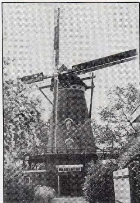
De korenmolens "Nooit Gedacht" te 's-Heer Arendskerke (gem. Goes), op 26 juni 1983. Op de horizontale roede systeem Van Riet.
