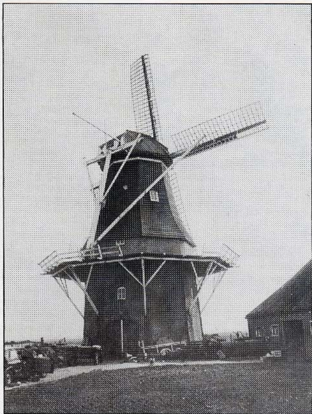
De koren- en pelmolen van Ganzedijk in de gemeente Finsterwolde, gefotografeerd in maart 1984. Deze vervallen molen, die gerestaureerd zal worden, heeft voor Groningen afwijkende kenmerken: vang met korte sabelijzer, een sleepluiwerk en lange spruit vóór het bovenwiel. Foto: M.E. van Doornik.
